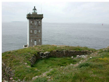
Vue générale (état en 2006). En arrière-plan, le phare de Kermorvan Phot. Guillaume Lécueillier IVR53_20062903889NUCA
