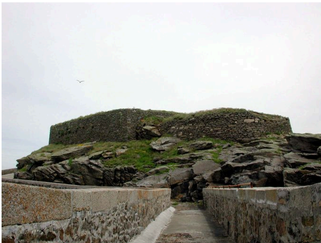
Vue générale depuis l'ouest (état en 2006)
