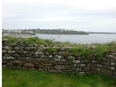
Vue de détail du parapet (état en 2006) Phot. Guillaume Lécueillier IVR53_20062903892NUCA
