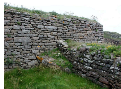
Vue de détail du liaisonnement entre les deux parapets (état en 2006) Phot. Guillaume Lécueillier IVR53_20062903891NUCA
