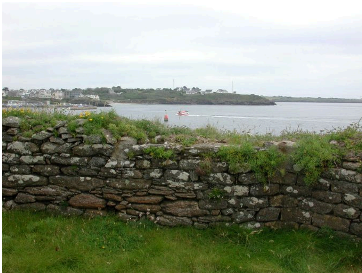
Vue de détail du parapet (état en 2006)
