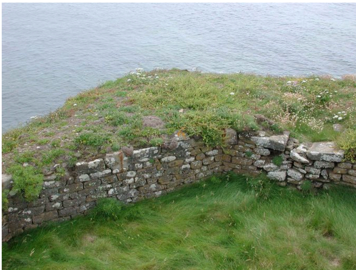
Vue de détail du parapet (état en 2006)
