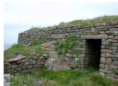
Vue du liaisonnement et de la galerie de communication avec la batterie haute (état en 2006) Phot. Guillaume Lécueillier
