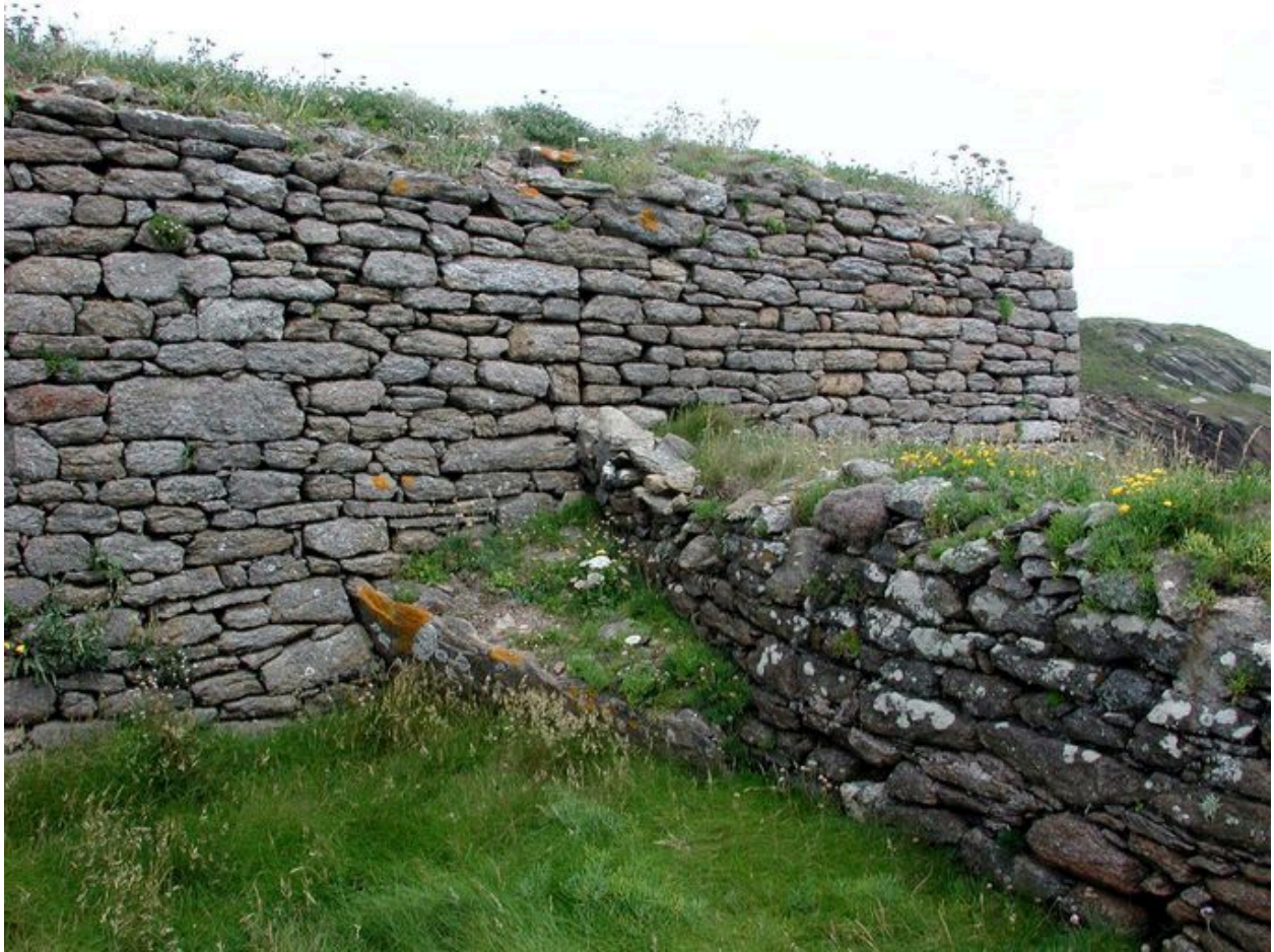
Vue de détail du liaisonnement entre les deux parapets (état en 2006)
