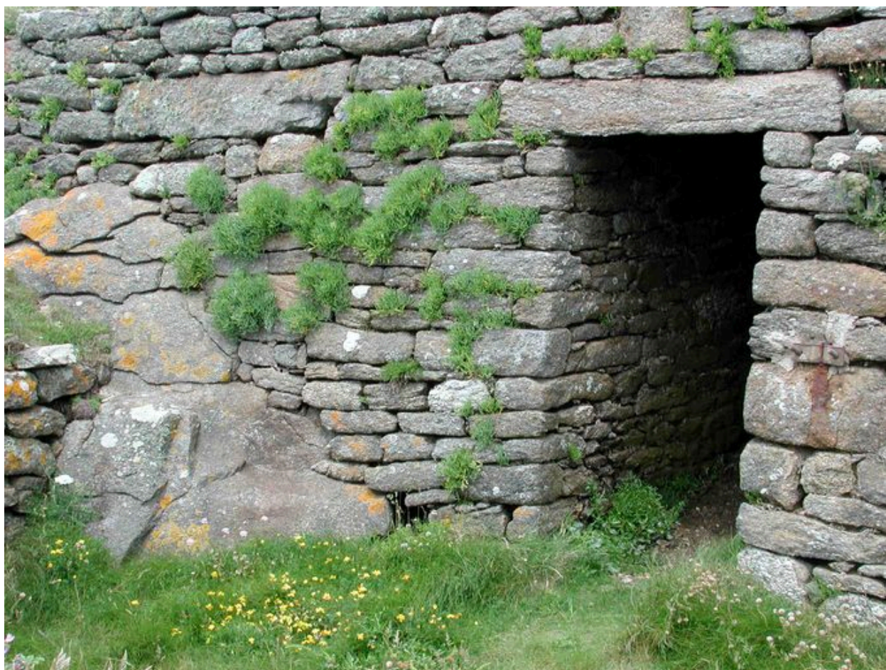
Vue de la galerie de communication avec la batterie haute (état en 2006)
