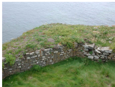
Vue de détail du parapet (état en 2006) Phot. Guillaume Lécueillier IVR53_20062903893NUCA
