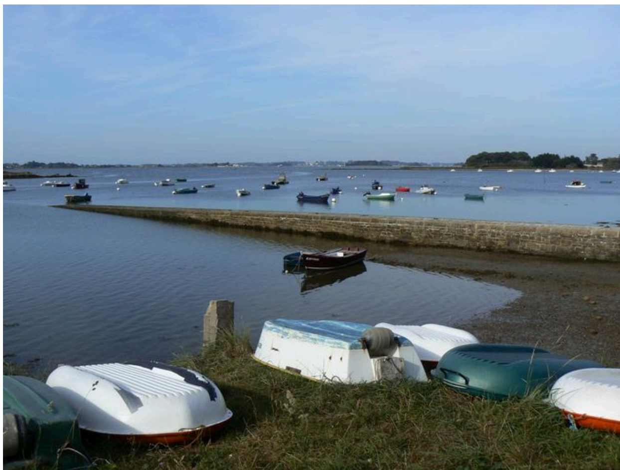
Vue générale de la cale de Badel
