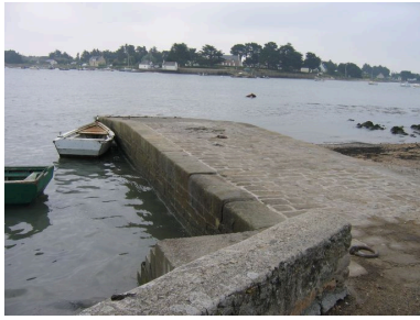
Vue générale de la cale du Passage Saint-Armel Phot. Françoise Péron IVR53_20075605721NUCA
