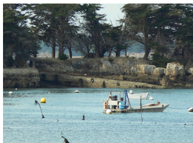
Cale de l'île de Boëdic Phot. Johan Vincent IVR53_20075605747NUCA
