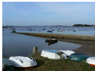
Vue générale de la cale de Badel Phot. Johan Vincent IVR53_20075605700NUCA
