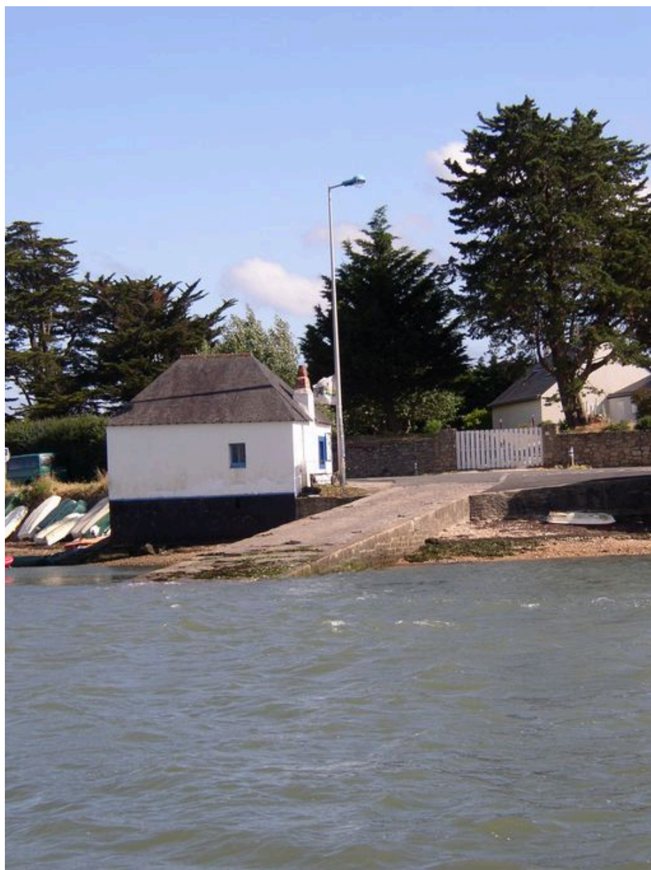
Vue générale de la cale du Passage (commune de St-Armel)
