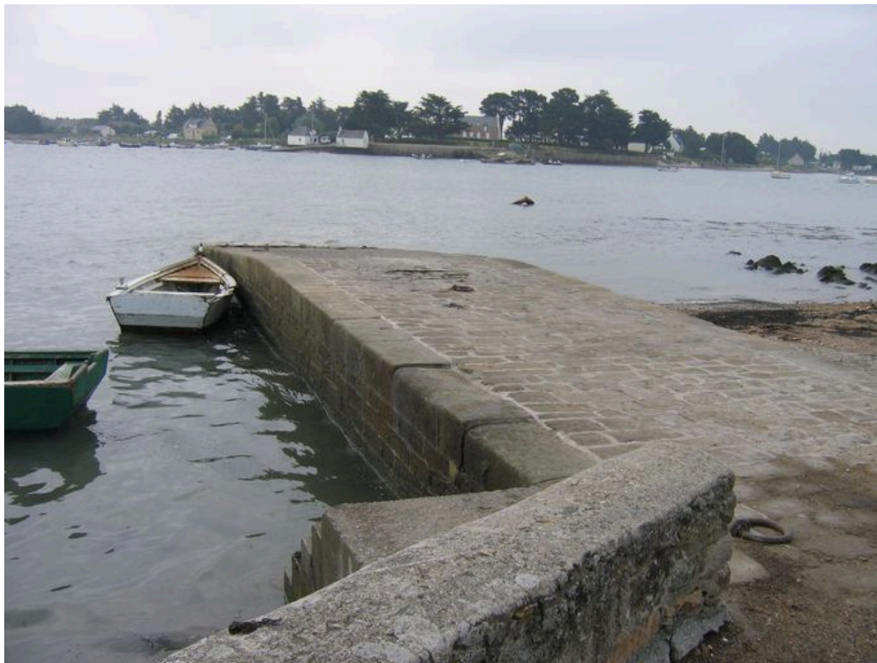
Vue générale de la cale du Passage Saint-Armel
