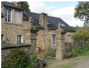
Piliers limitant l'accès à l'allée sud, déplacés à Malachappe, 18e siècle ? Phot. Catherine Toscer IVR53_20155606975NUCA
