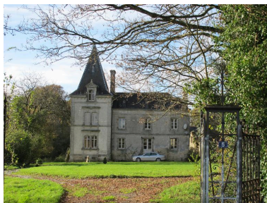
Logis, élévation antérieure est, état en 2015 Phot. Catherine Toscer IVR53_20155606968NUCA
