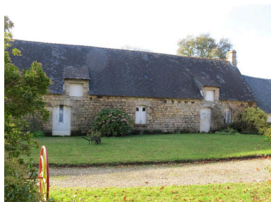
Ferme, élévation antérieure est, état en 2015 Phot. Catherine Toscer IVR53_20155606970NUCA
