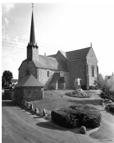
Vue générale sud Phot. Guy Artur, Phot. Norbert Lambart IVR53_19943501757X
