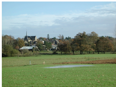
Vue de situation sud ouest Phot. Claude Quillivic IVR53_20003510711NUCA
