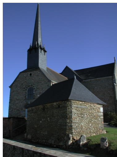
Vue générale sud ouest Phot. Claude Quillivic IVR53_20003510650NUCA
