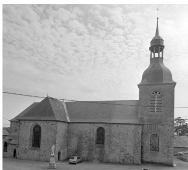
Élévation nord : vue générale Phot. Guy Artur, Phot. Norbert Lambart IVR53_19943501418X
