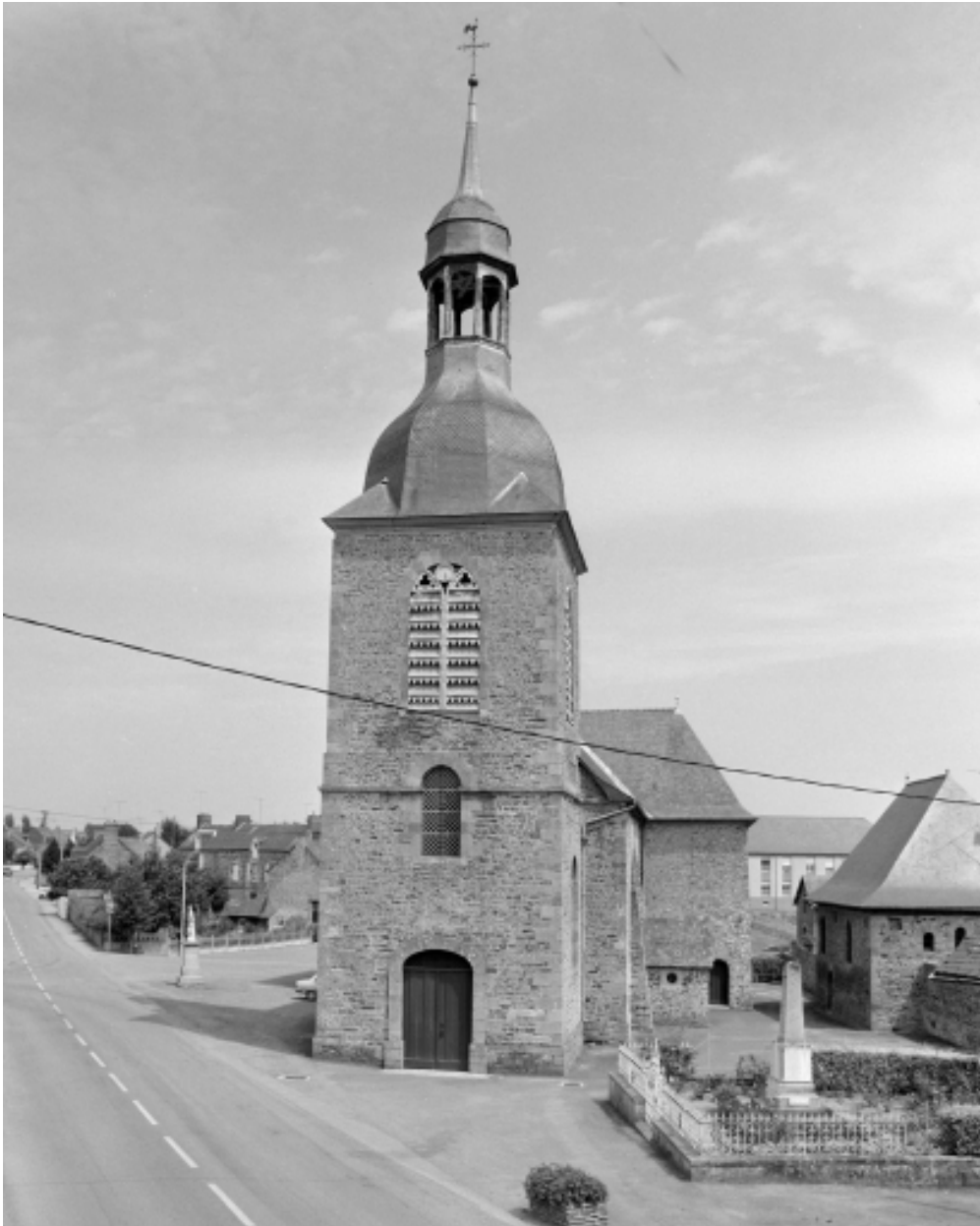
Elévation ouest : vue générale
