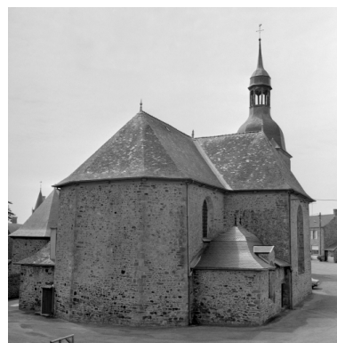
Élévation nord-est : vue générale Phot. Guy Artur, Phot. Norbert Lambart IVR53_19943501419X
