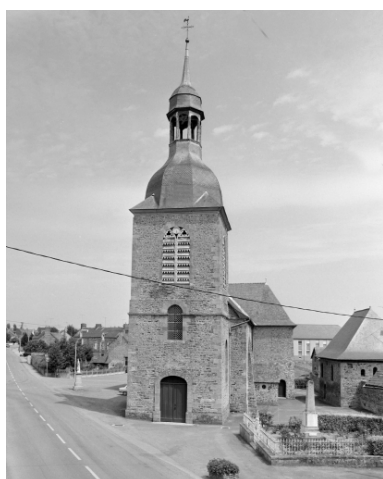
Élévation ouest : vue générale Phot. Guy Artur, Phot. Norbert Lambart IVR53_19943501420X
