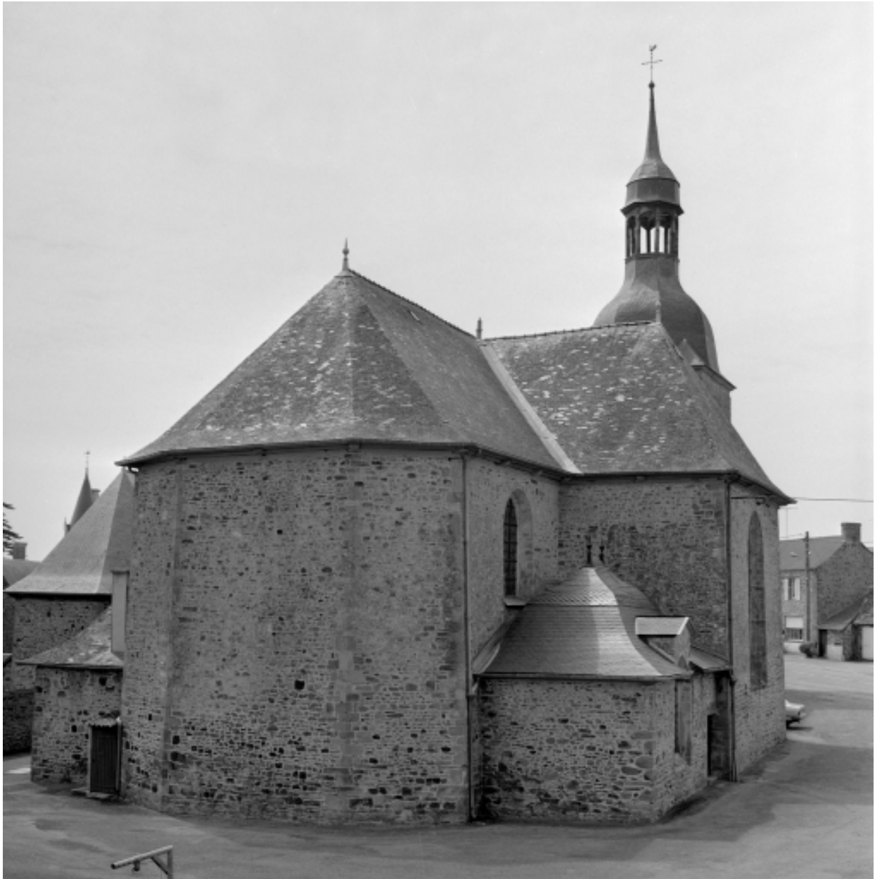
Elévation nord-est : vue générale
