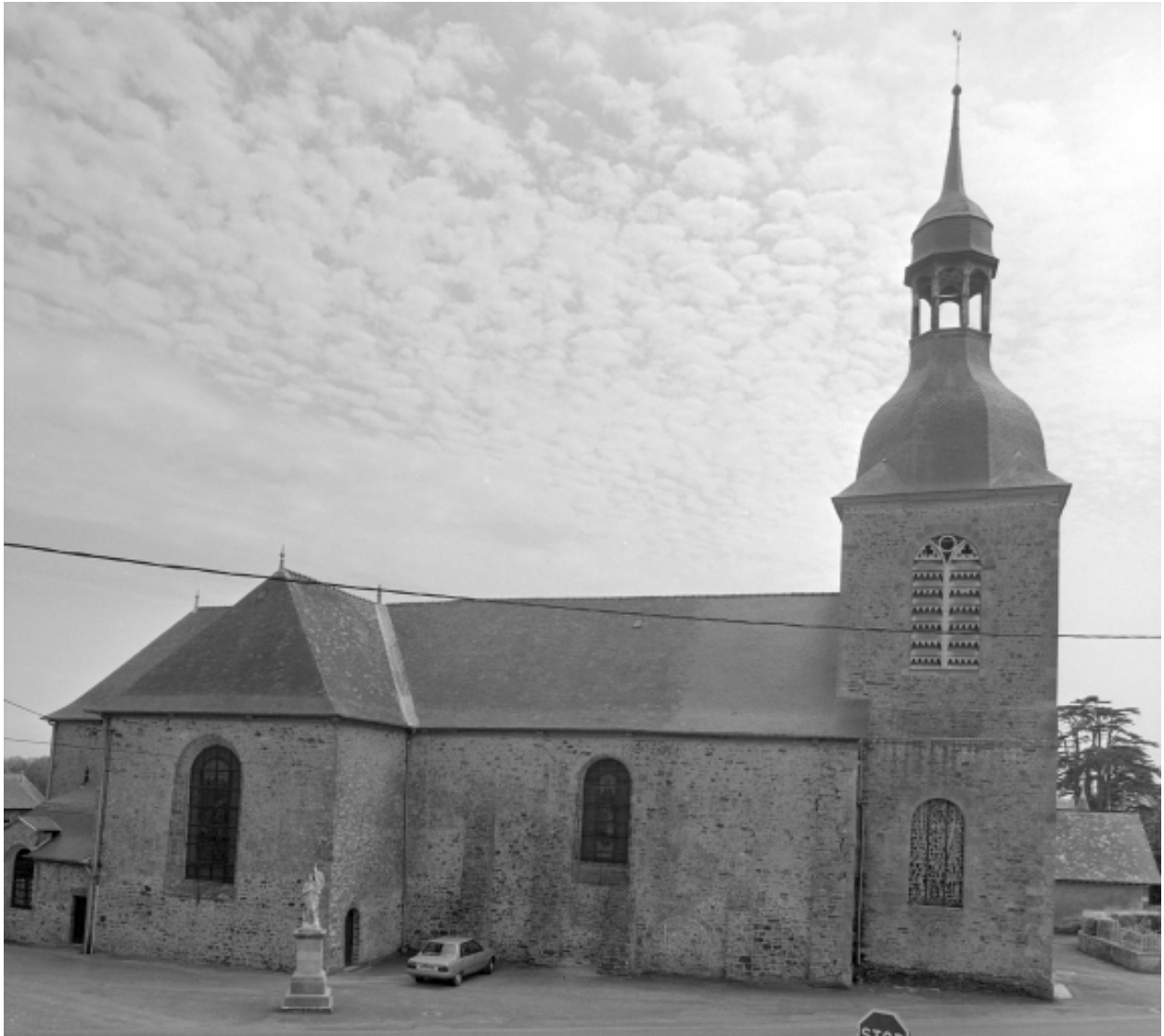
Elévation nord : vue générale
