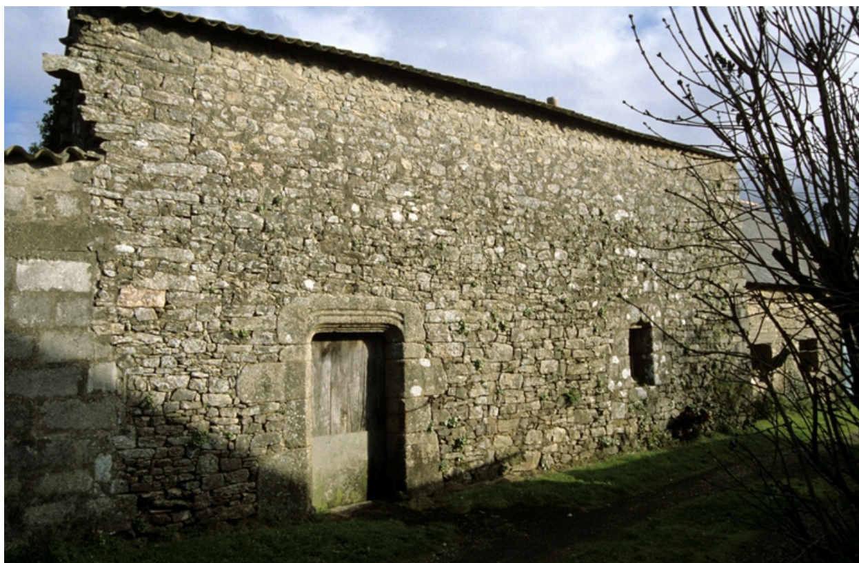
Vue générale élévation sud.
