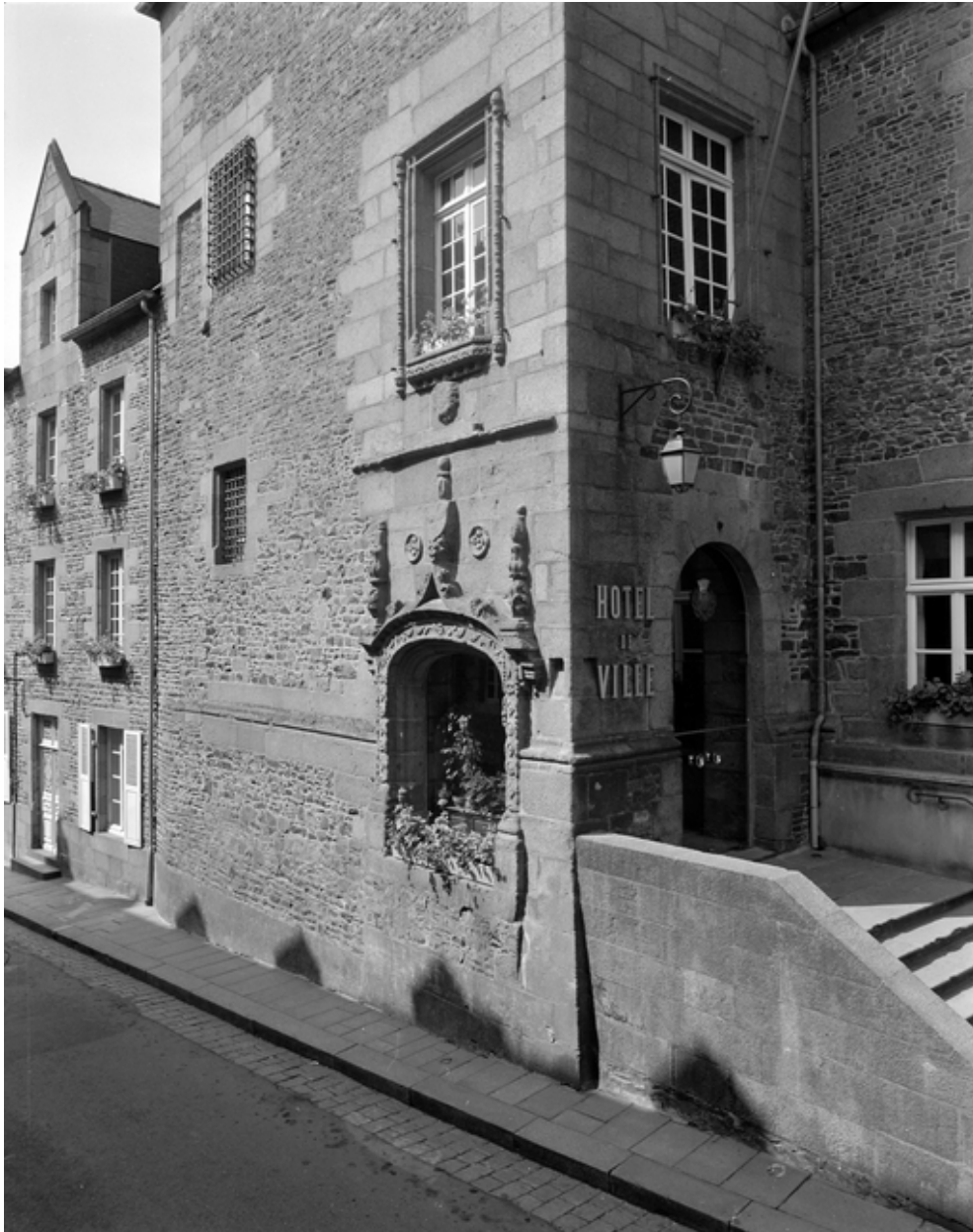
Vue générale de la porte et de la fenêtre du corps d'escalier.
