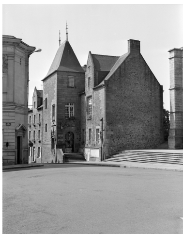
Vue générale nord-est. Phot. Guy Artur IVR53_19783500354X
