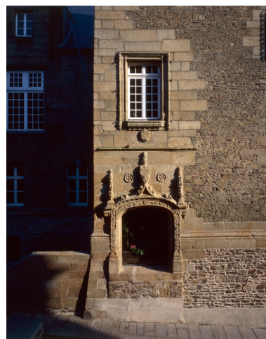
Extérieur, travée à décor, vue générale. Phot. Guy Artur IVR53_19853500108VA
