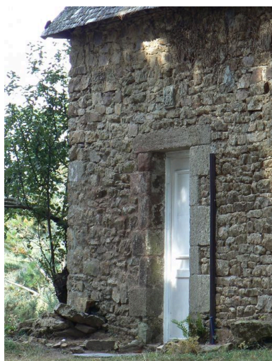
détail de la guérite des douaniers de Barrarac'h Phot. Johan Vincent IVR53_20075605761NUCA
