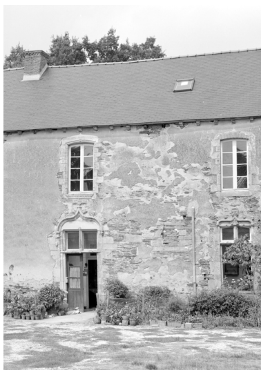
Manoir : élévation sud (état en 1984) Phot. Jean-Pierre Ducouret IVR53_19845601896X
