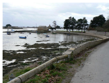
Ancien magasin ostréicole, actuellement hangar d'une station biologique Phot. Julien Amghar IVR53_20085606119NUCA
