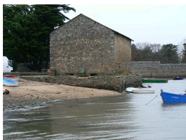
Ancien magasin ostréicole, actuellement hangar d'une station biologique Phot. Julien Amghar IVR53_20085606117NUCA
