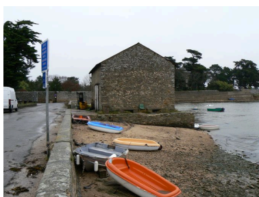
Ancien magasin ostréicole, actuellement hangar d'une station biologique Phot. Julien Amghar IVR53_20085606118NUCA
