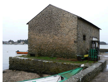
Ancien magasin ostréicole, actuellement hangar d'une station biologique Phot. Julien Amghar IVR53_20085606116NUCA
