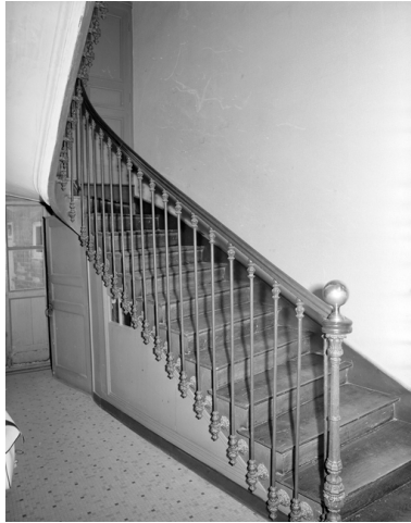
Vue du départ de l'escalier. Phot. Guy Artur IVR53_19783500264X
