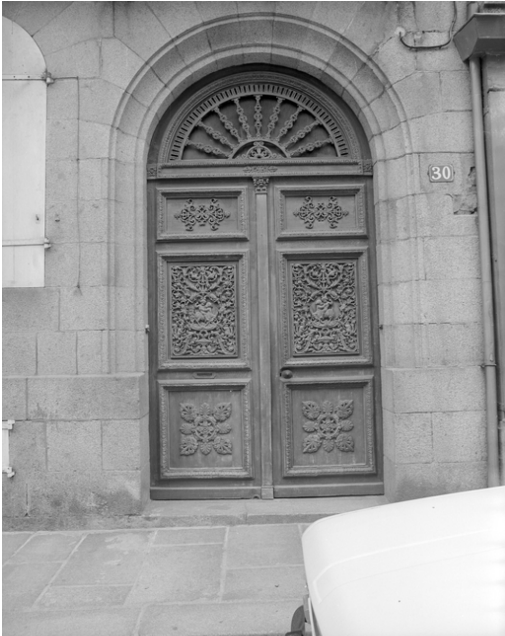
Vue générale de la porte d'entrée.
