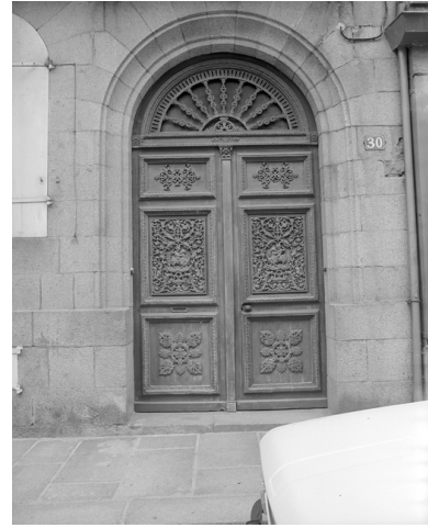
Vue générale de la porte d'entrée. Phot. Guy Artur IVR53_19783500260X
