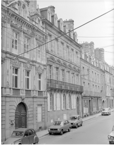
Elévation antérieure. Phot. Guy Artur IVR53_19783500262X
