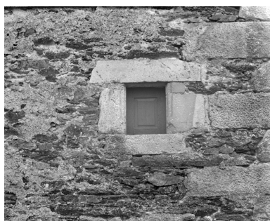
Elévation ouest, fenêtre ; vue générale Phot. Guy Artur, Phot. Norbert Lambert IVR53_19933500077X
