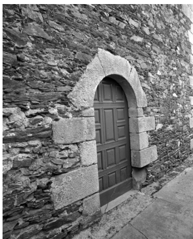
Elévation sud ouest, porte ; vue générale Phot. Guy Artur, Phot. Norbert Lambert IVR53_19933500080X
