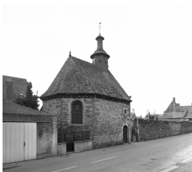
Elévation nord-est ; vue de situation Phot. Guy Artur, Phot. Norbert Lambart IVR53_19933500083X
