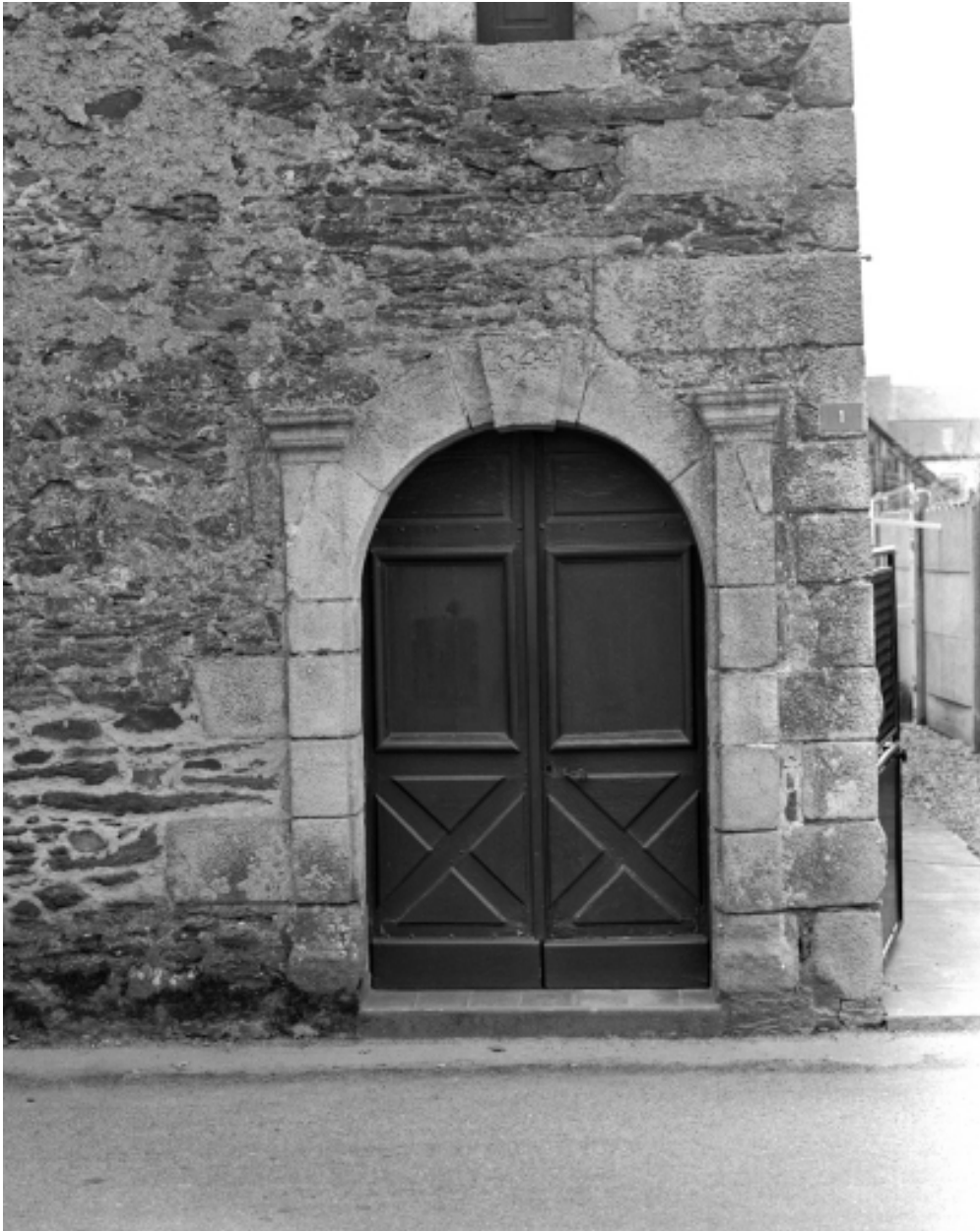
Elévation ouest, porte ; vue générale
