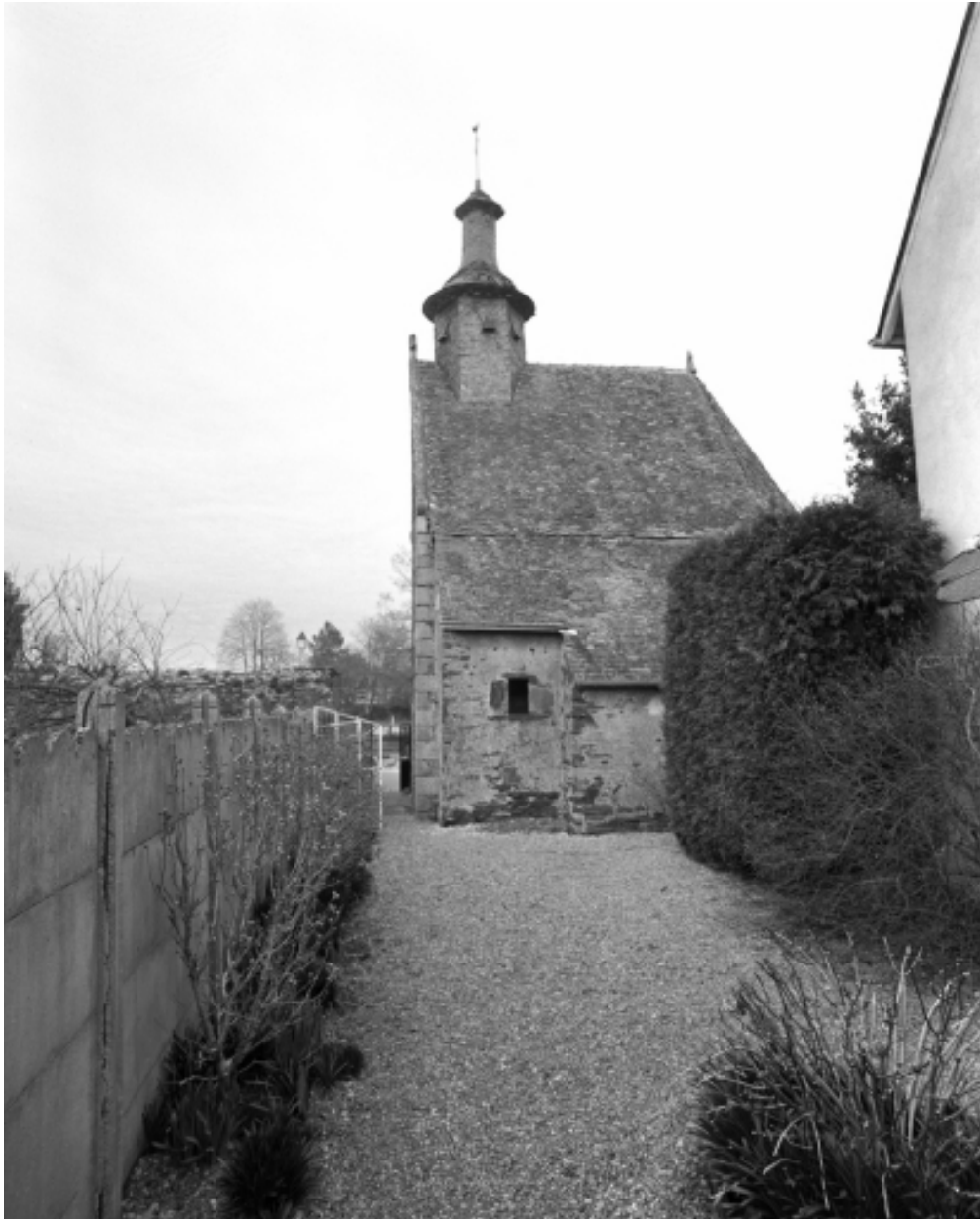
Elévation est ; vue générale
