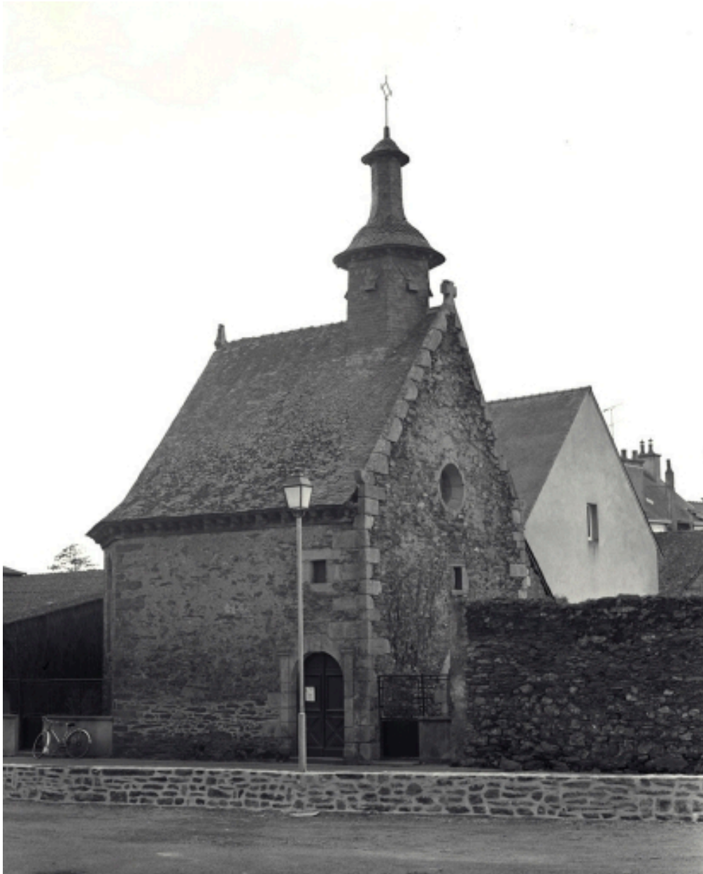
Elévation nord-ouest ; vue générale
