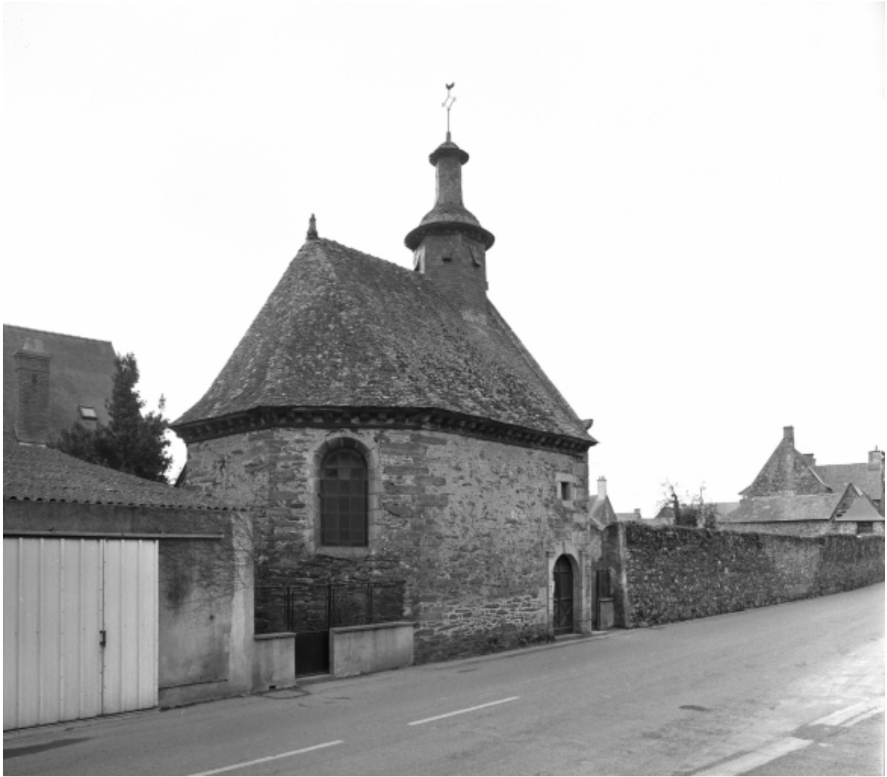
Elévation nord-est ; vue de situation
