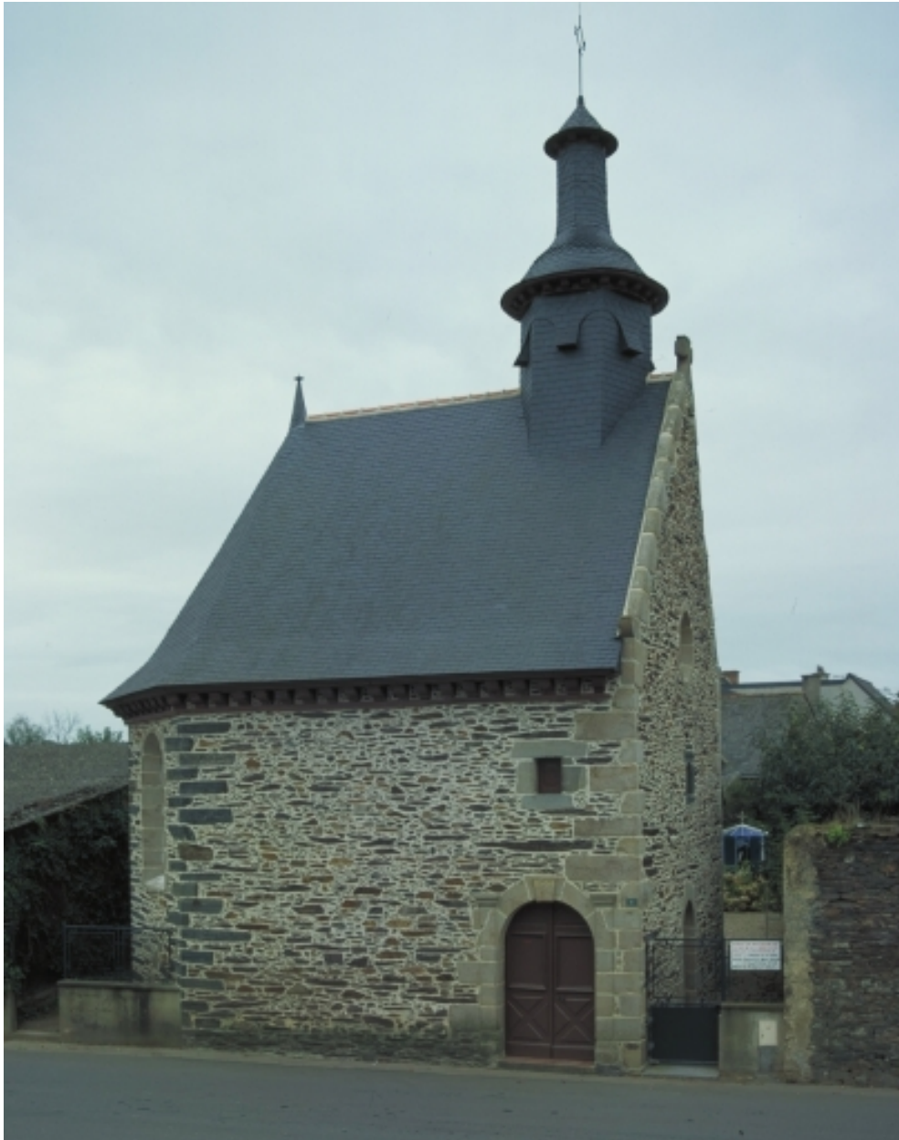
Elévation nord-ouest ; vue générale
