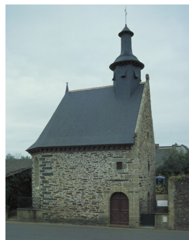
Elévation nord-ouest ; vue générale Phot. Guy Artur, Phot. Norbert Lambart
