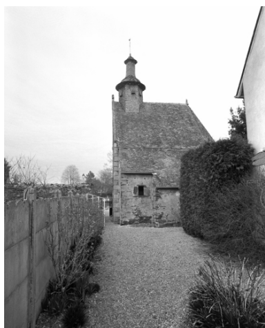
Elévation est ; vue générale Phot. Guy Artur, Phot. Norbert Lambart
