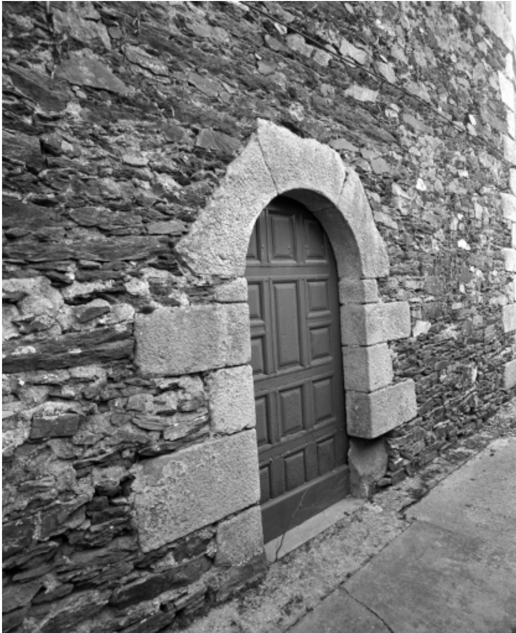
Elévation sud ouest, porte ; vue générale
