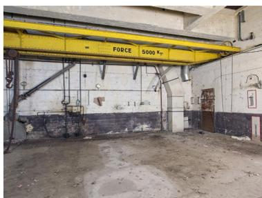
Locaux techniques, partie nord, rez-de-chaussée, grande pièce de la centrale électrique : pont roulant manuel d'une capacité de 5 tonnes et son treuil. Sur les murs bicolores, sont fixés des systèmes de tuyauterie et une gaine de ventilation
