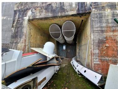
Locaux techniques : entrée nord avec petite avancée de protection. Au-dessus de la porte débouche deux gaines de ventilation
