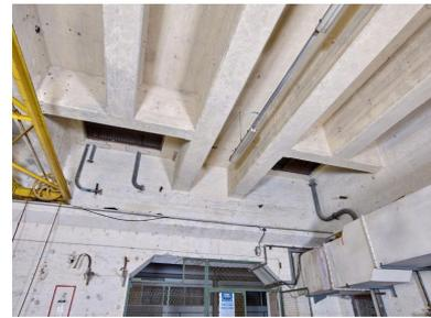
Locaux techniques, partie nord, rez-de-chaussée, grande pièce de la centrale électrique : la dalle du premier étage repose sur d'imposantes poutres en béton armé. Le mur de refend séparant les parties nord et sud est percé d'un passage
