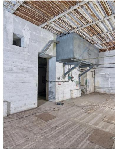
Locaux techniques, partie sud, premier étage, grande pièce : grand réservoir métallique (caisse de réserve) fixé en hauteur contre le mur de refend et lavabo. Le plafond est en tôle nervurée en acier
