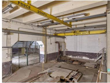
Locaux techniques, partie sud, rez-de-chaussée, grande pièce de la centrale électrique : passage percé dans le mur de refend avec grille.
