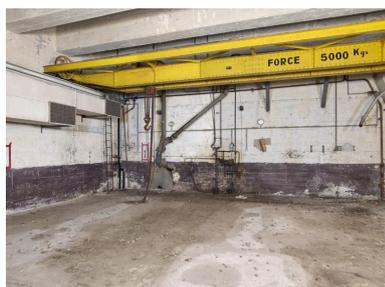
Locaux techniques, partie nord, rez-de-chaussée, grande pièce de la centrale électrique : pont roulant manuel d'une capacité de 5 tonnes et son treuil. Sur les murs bicolores, sont fixés des systèmes de tuyauterie et des gaines de ventilation
