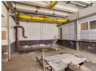
Locaux techniques, partie sud, rez-de-chaussée, grande pièce de la centrale électrique : pont roulant manuel d'une capacité de 5 tonnes.
