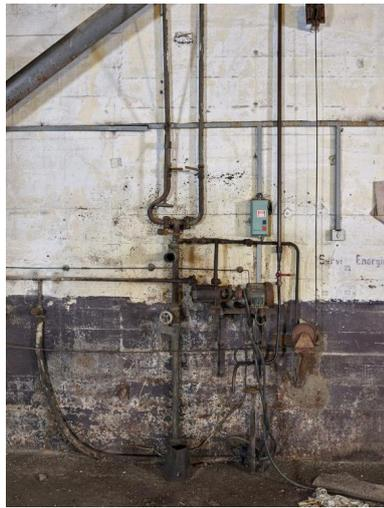
Locaux techniques, partie nord, rez-de-chaussée, grande pièce de la centrale électrique : sur les murs bicolores sont fixés des systèmes de tuyauterie, ici, une pompe électrique. Un treuil à câble permet d'actionner deux vannes
