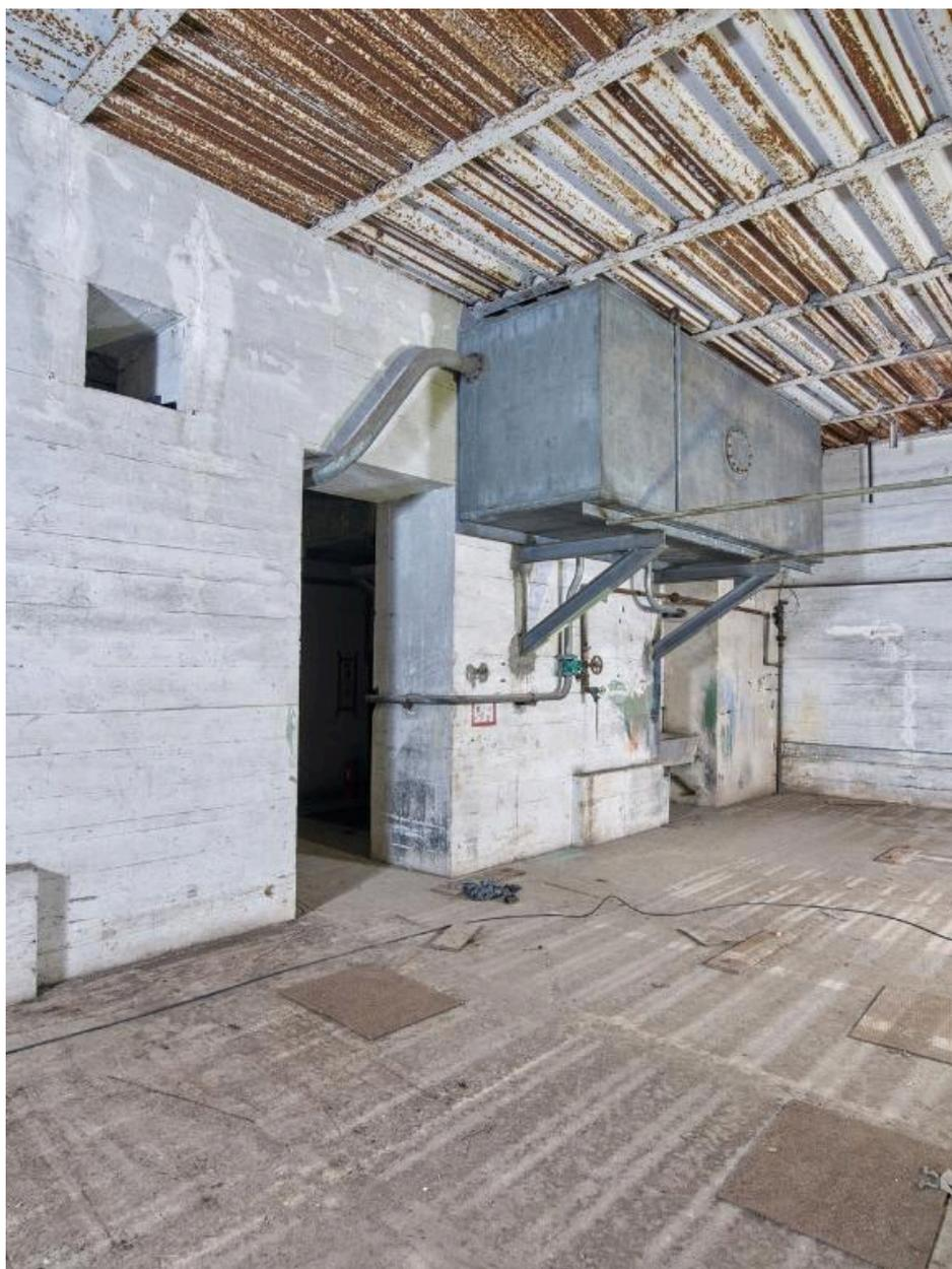
Locaux techniques, partie sud, premier étage, grande pièce : grand réservoir métallique (caisse de réserve) fixé en hauteur contre le mur de refend et lavabo. Le plafond est en tôle nervurée en acier
