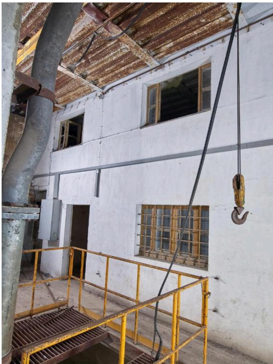
Locaux techniques, partie nord, premier étage : espace central de circulation, puits dans le sol et monorail pour treuil électrique à crochet. Les fenêtres hautes correspondent au troisième étage situé sous le plafond en tôle nervurée
