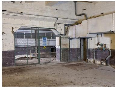
Locaux techniques, partie nord, rez-de-chaussée, grande pièce de la centrale électrique : mur de refend avec passage. Sur les murs bicolores sont fixés les vannes et tuyaux d'arrivée d'eau pour le refroidissement des moteurs et une gaine de ventilation
