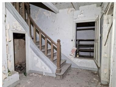
Locaux techniques, partie nord, premier étage : cage d'escalier et couloir de distribution. Le mauvais état sanitaire de l'escalier ne permet pas d'accéder au dernier niveau sur poutres, solives et plancher
