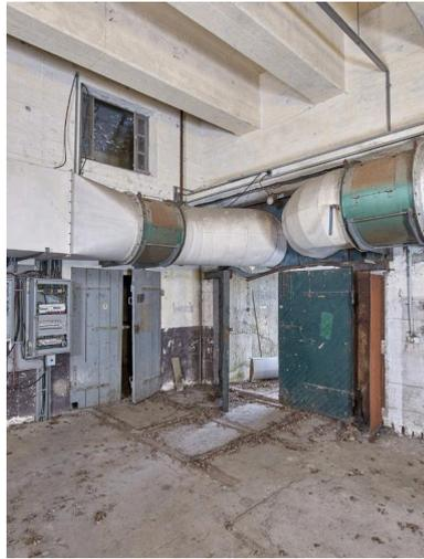
Locaux techniques, partie nord, rez-de-chaussée, grande pièce de la centrale électrique : gaines de ventilation implantées au-dessus de la porte (en bois, doublé de métal). La fenêtre haute correspond à une pièce en entresol.
