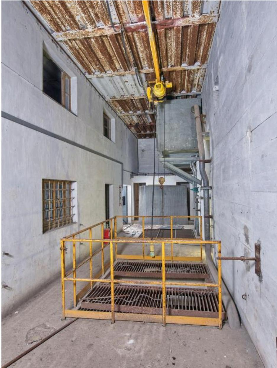
Locaux techniques, partie nord, premier étage : espace central de circulation, puits dans le sol et monorail pour treuil électrique. Un grand réservoir métallique (casse de réserve) est fixé en hauteur contre le mur de refend
