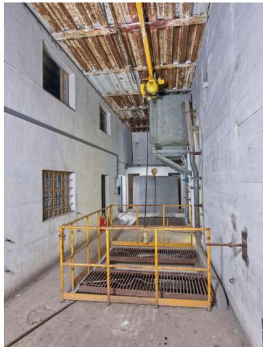
Locaux techniques, partie nord, premier étage : espace central de circulation, puits dans le sol et monorail pour treuil électrique. Un grand réservoir métallique (caisse de réserve) est fixé en hauteur contre le mur de refend
