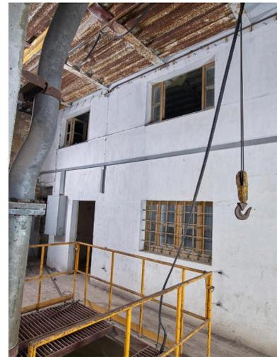
Locaux techniques, partie nord, premier étage : espace central de circulation, puits dans le sol et monorail pour treuil électrique à crochet. Les fenêtres hautes correspondent au troisième étage situé sous le plafond en tôle nervurée
