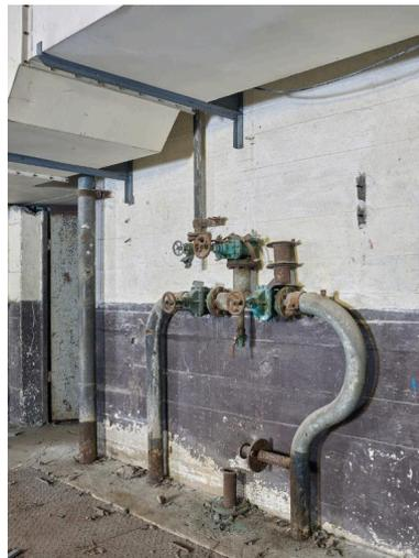
Locaux techniques, partie nord, rez-de-chaussée, grande pièce de la centrale électrique : tuyaux d'arrivée d'eau et vannes pour le refroidissement des moteurs. Des plaques précisent Eau de ville ou Eau de mer
