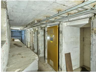
Locaux techniques, partie sud, en demi-sous-sol : cellules pour transformateur électrique. Sur la seule porte en place, on peut lire sur une plaque : Transfo[r]mateur] n° 1 5500/400 V 250 KVA
