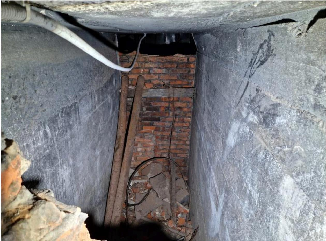
Locaux techniques, partie nord, premier étage : passage débouchant dans l'alvéole nord (le mur en béton armé mesure 3 m d'épaisseur). Ce passage est actuellement muré par des briques montées au ciment
