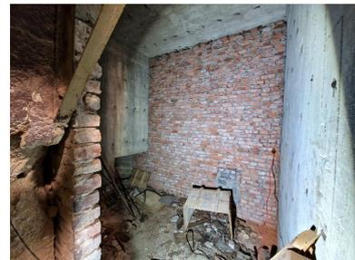
Locaux techniques, partie sud, rez-de-chaussée : passage situé dans l'angle sud-ouest (le mur en béton armé mesure 3 m d'épaisseur). Actuellement muré par des briques montées au ciment, le passage débouchait dans l'alvéole sud
