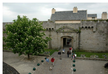
Vue de la ville-close de Concarneau : porte d'entrée monumentale Phot. Guillaume Lécueillier IVR53_20062907338NUCA
