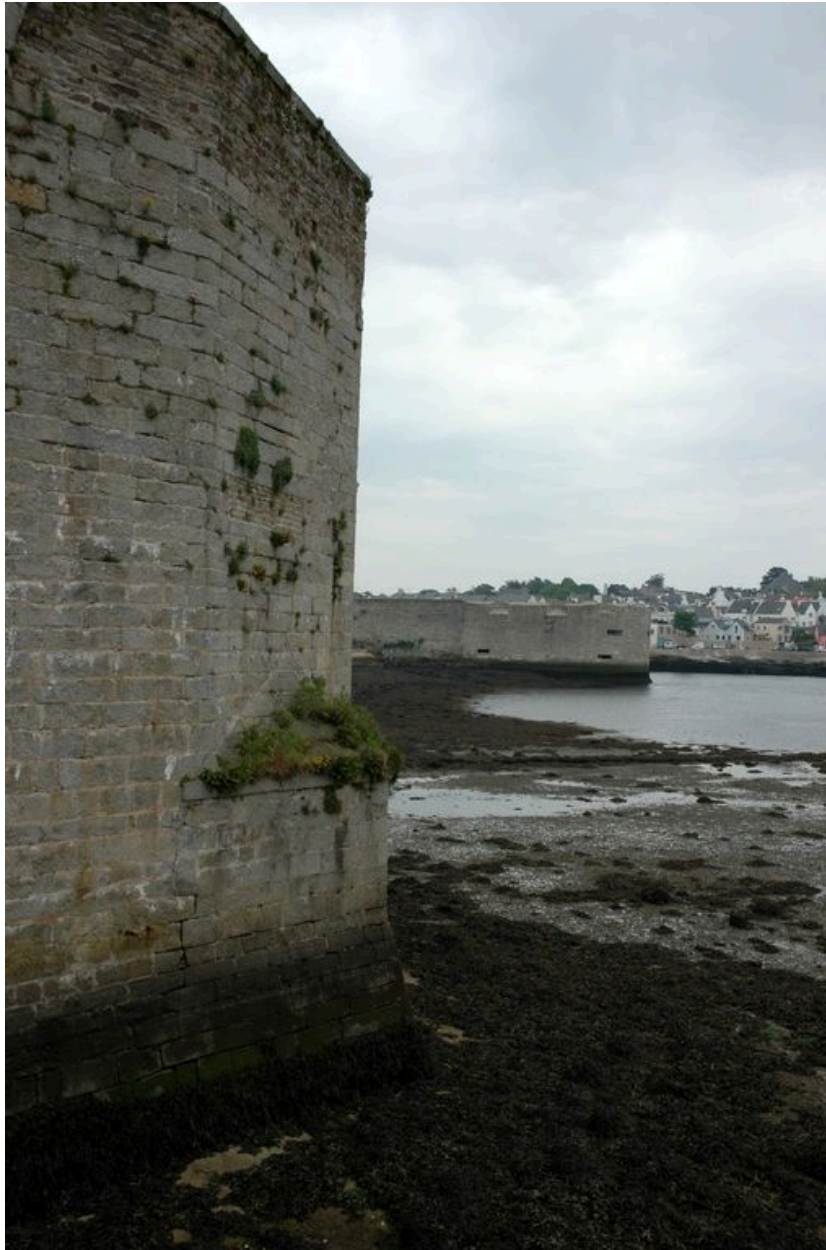
Vue de la ville-close de Concarneau : le Fer à Cheval. Au premier plan : éperon de la tour du Gouverneur
