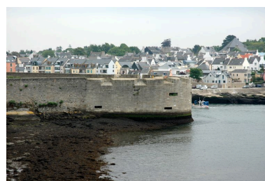
Vue de la ville-close de Concarneau : ouvrage dit le Fer à Cheval percé de canonniers. Le parapet est percé d'embasures plongeantes Phot. Guillaume Lécueillier IVR53_20062907341NUCA
