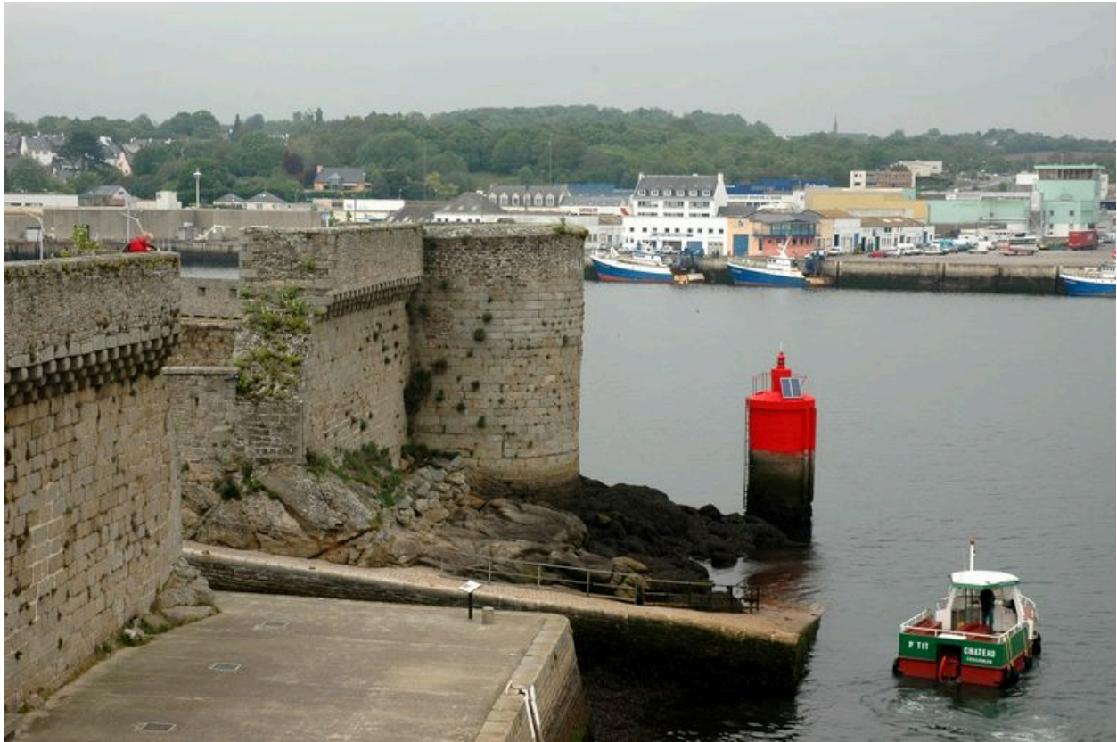
Vue de la ville-close de Concarneau : la porte et la tour du Passage
