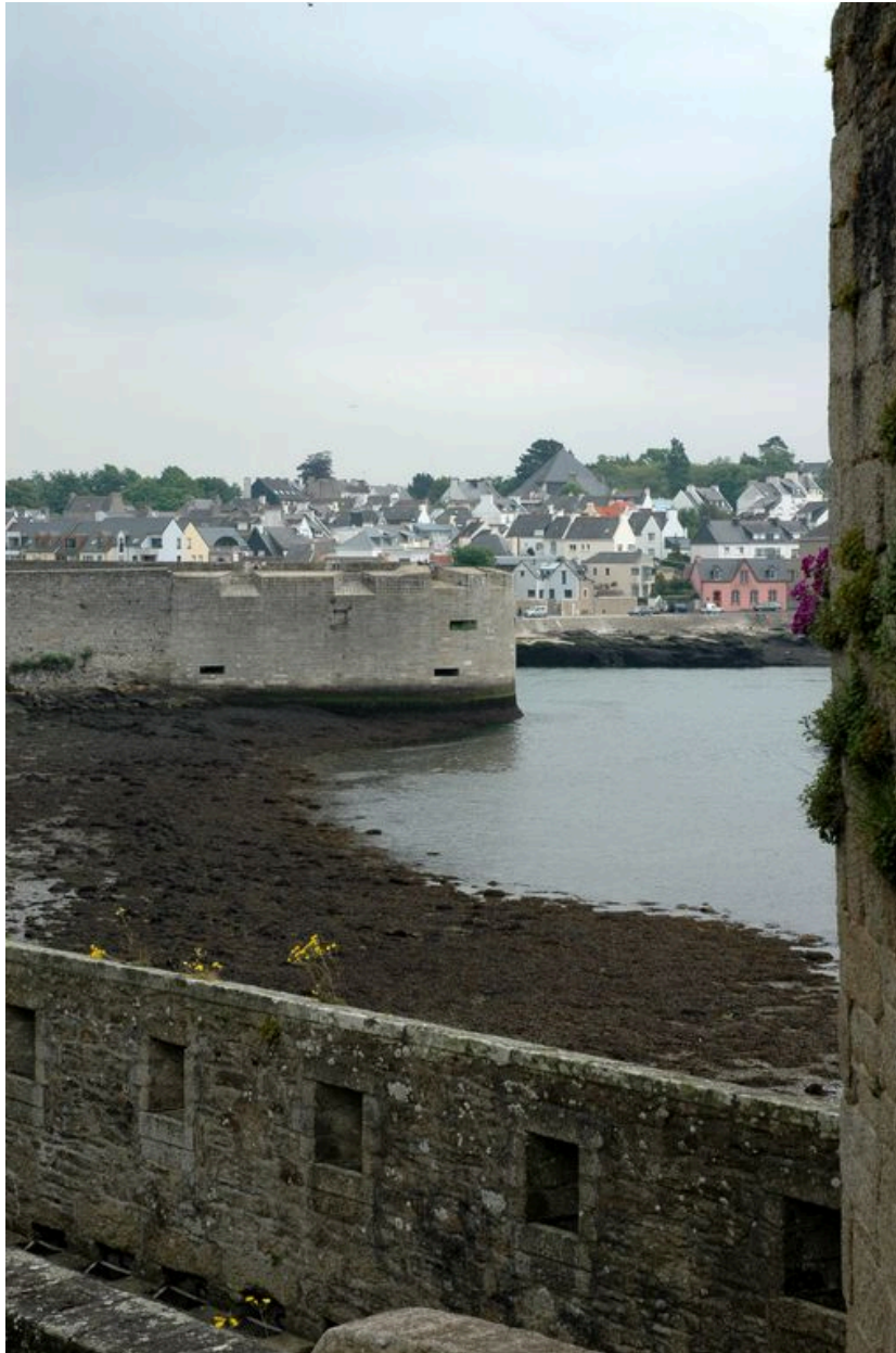
Vue de la ville-close de Concarneau : le Fer à Cheval. Au premier plan : parapet crénelé
