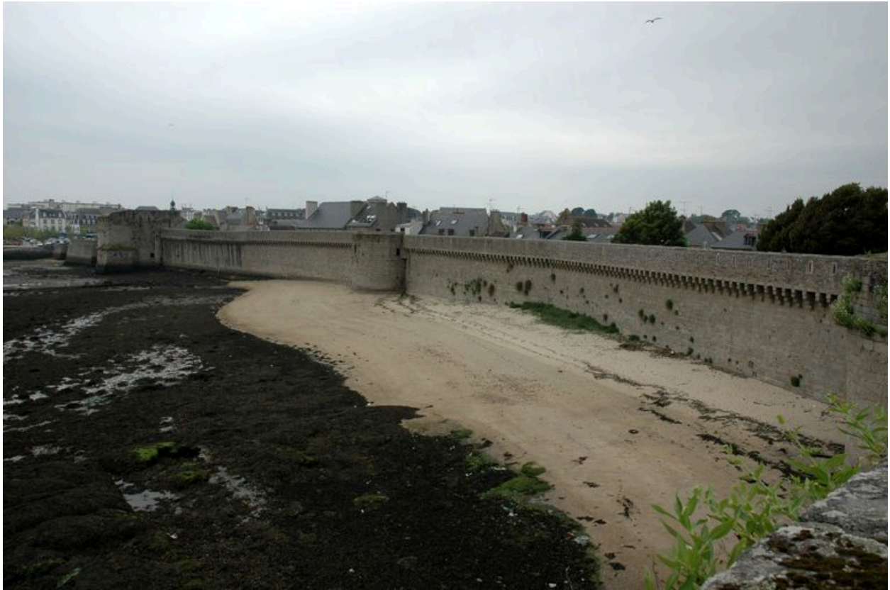
Vue de la ville-close de Concarneau : les remparts à marée basse depuis le sommet de l'ouvrage dit le Fer à Cheval. De gauche à droite : tour du Gouverneur, tour de la Fortune et la tour du Maure
