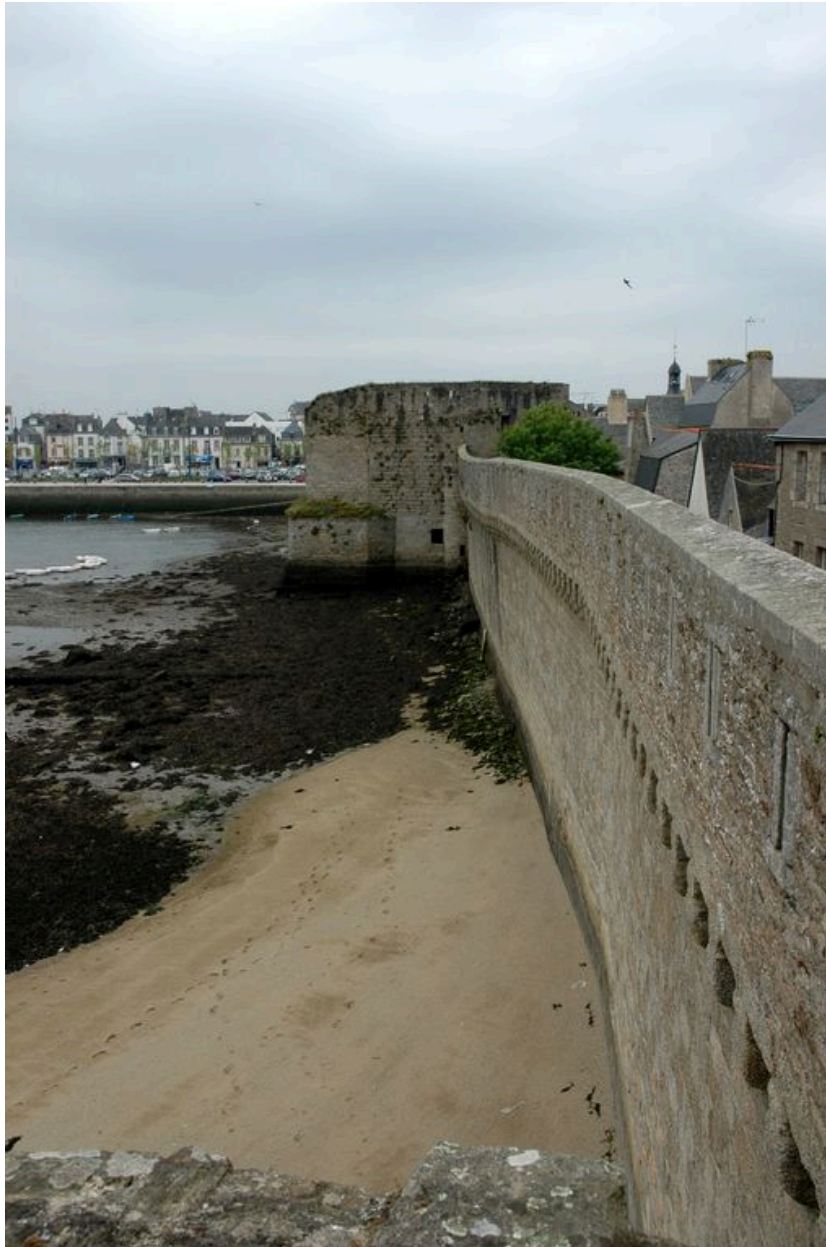
Vue de la ville-close de Concarneau : courtine et tour du Gouverneur depuis la tour de la Fortune
