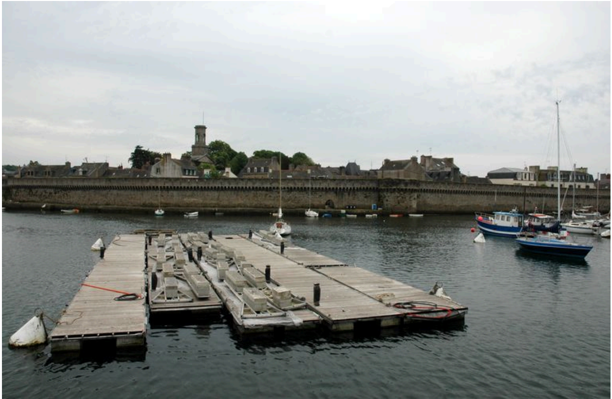
Vue de la ville-close de Concarneau : courtine, tour de la Porte au Vin
