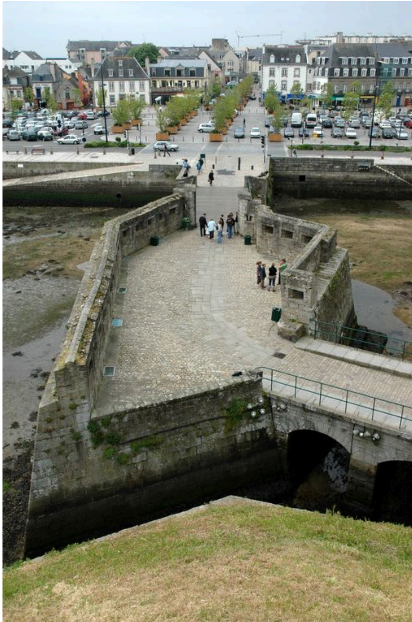
Vue de la ville-close de Concarneau : le ravelin protégé par un parapet crénelé
