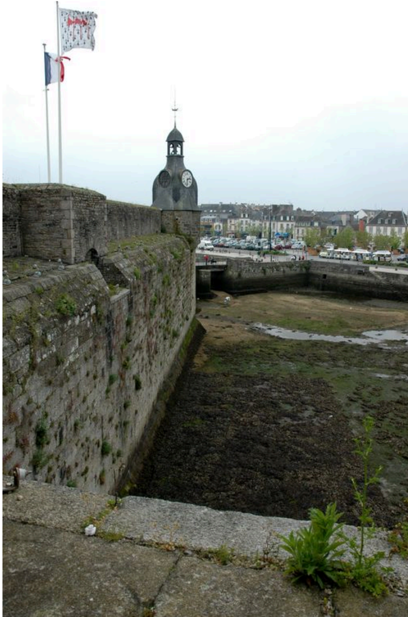
Vue de la ville-close de Concarneau : flanc de la demi-lune et son campanile
