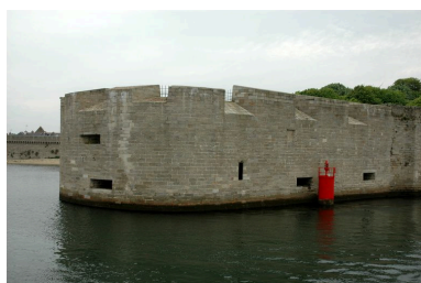
Vue de la ville-close de Concarneau : le Fer à Cheval et ses embrasures plongeantes tournées vers le chenal Phot. Guillaume Lécueillier IVR53_20062907298NUCA
