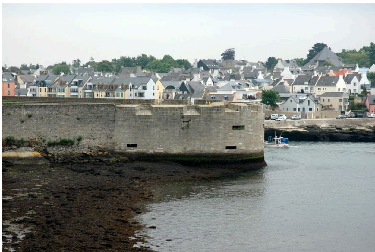
Vue de la ville-close de Concarneau : ouvrage dit le Fer à Cheval percé de canonnières. Le parapet est percé d'embarures plongeantes
