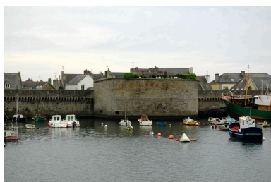
Vue de la ville-close de Concarneau : la tour Neuve Phot. Guillaume Lécueillier IVR53_20062907322NUCA
