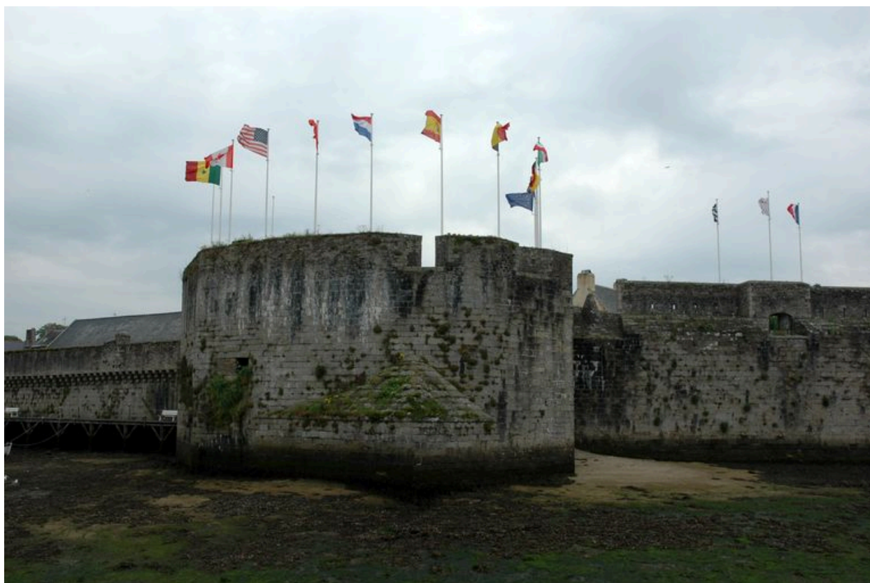
Vue de la ville-close de Concarneau : la tour du Major
