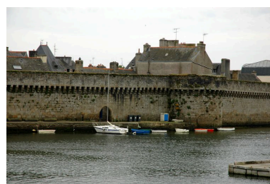
Vue de la ville-close de Concarneau : courtine, tour de la Porte au Vin Phot. Guillaume Lécueillier IVR53_20062907318NUCA
