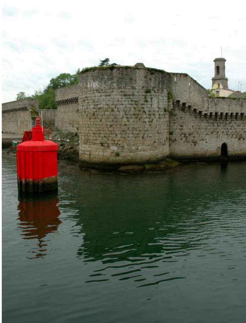
Vue de la ville-close de Concarneau : la tour du Passage et la porte des Larrons
