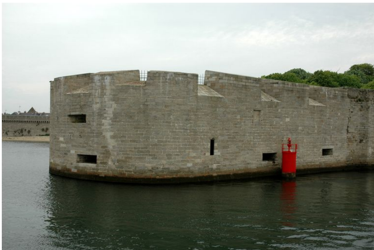
Vue de la ville-close de Concarneau : le Fer à Cheval et ses embrasures plongeantes tournées vers le chenal
