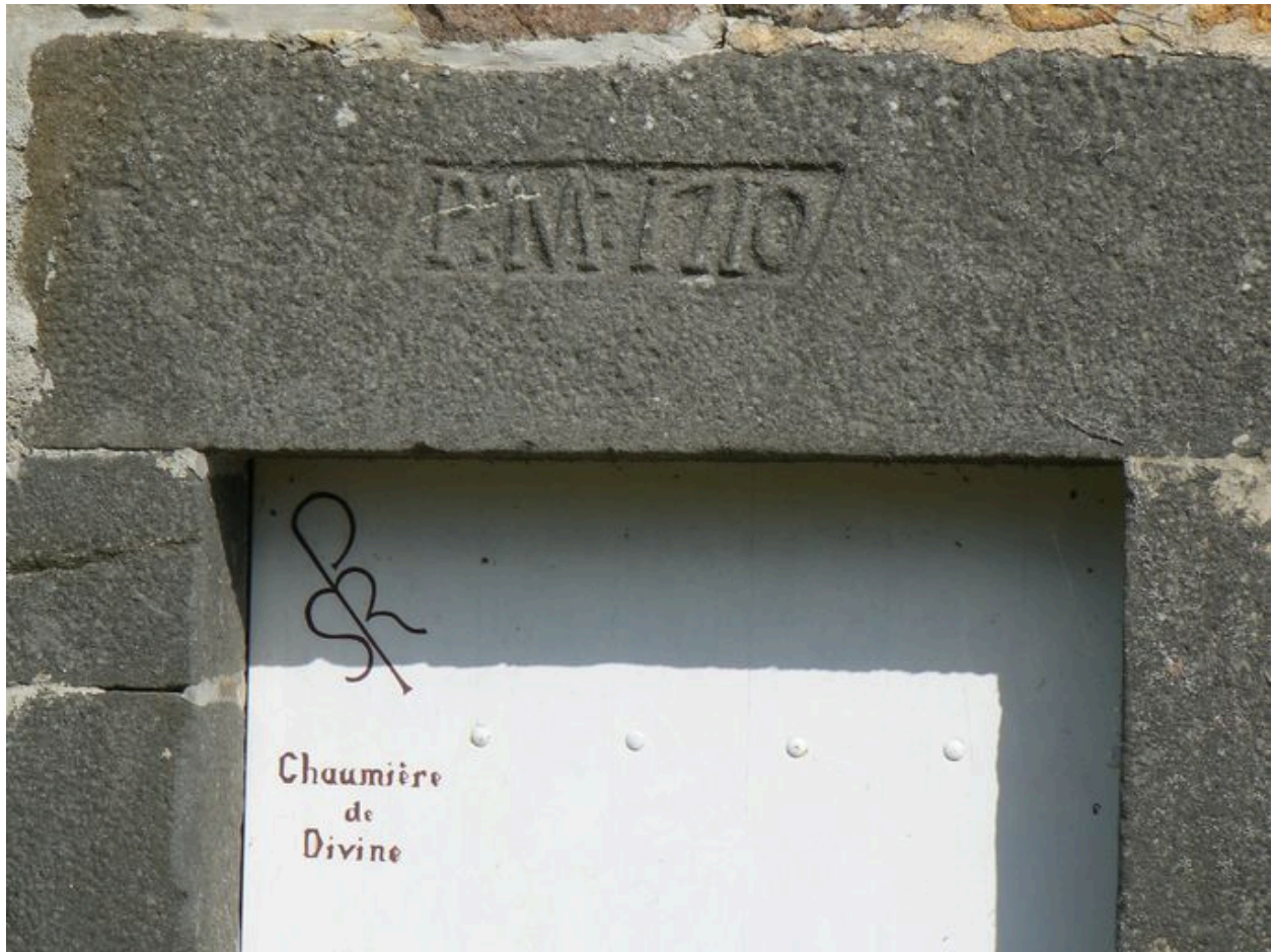
Détail de la porte et du linteau
