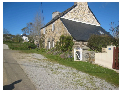
Vue latérale de la Chaumière de Divine Phot. Françoise Péron IVR53_20082908400NUCA
