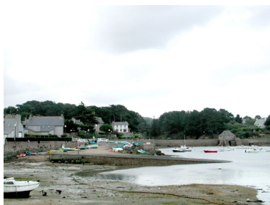
La nouvelle cale de Park ar Biwit pour les vedettes à passagers et les bateaux de fort tonnage Phot. Guy Prigent IVR53_20062207886NUCA
