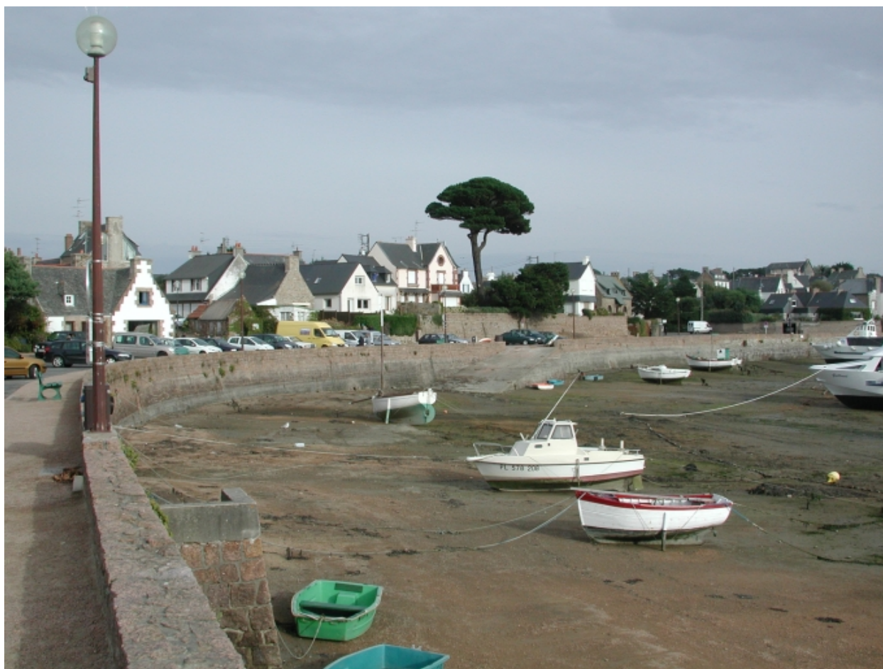
Les nouveaux murs de quais qui joignent la rue appelée quai Bellevue et la grève d'échouage à mare basse
