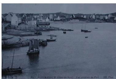
Vue d'ensemble des premiers ouvrages portuaires au 1er quart du 20ème siècle (collection particulière) Phot. Guy Prigent IVR53_20062207682NUCB
