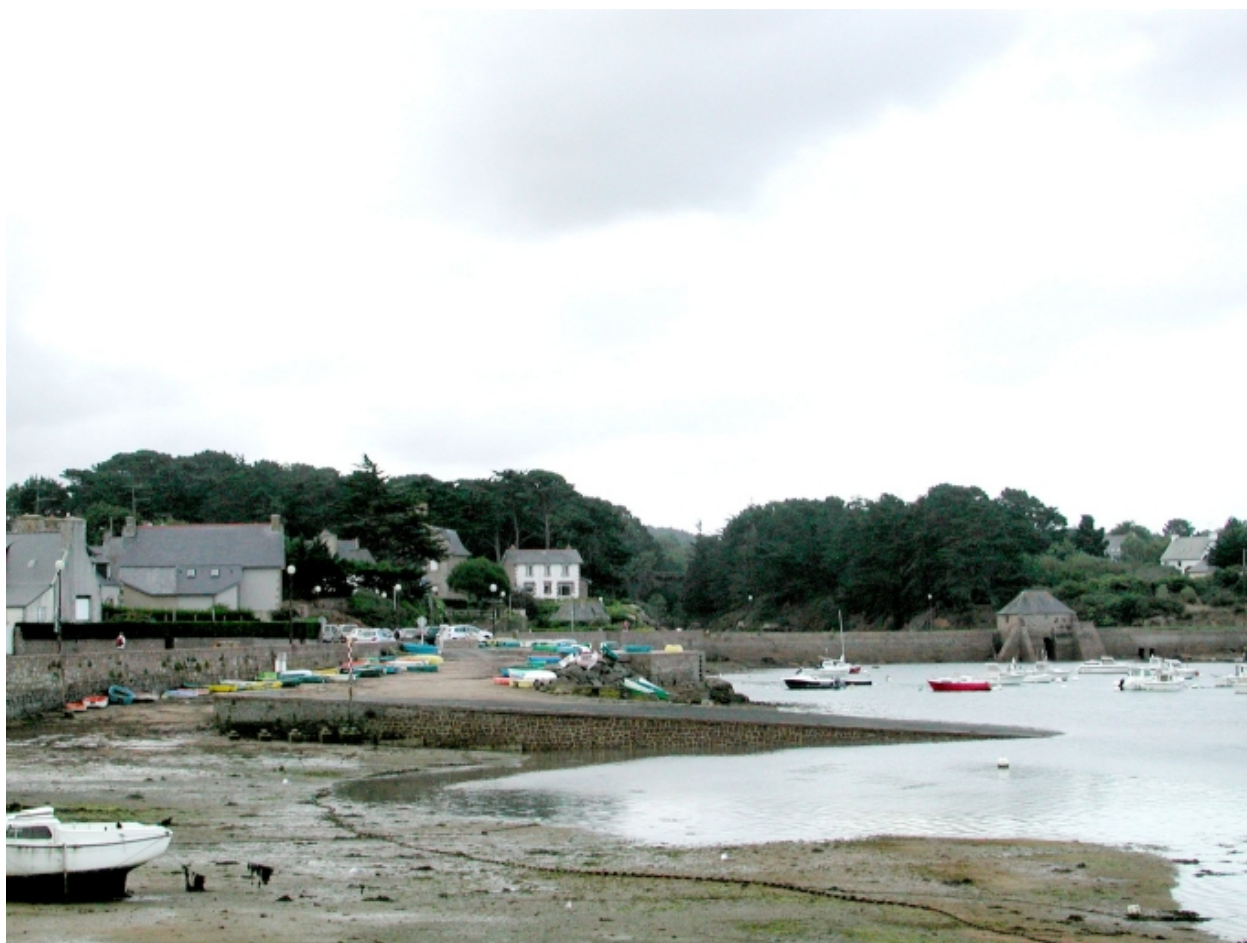
La nouvelle cale de Park ar Biwit pour les vedettes à passagers et les bateaux de fort tonnage
