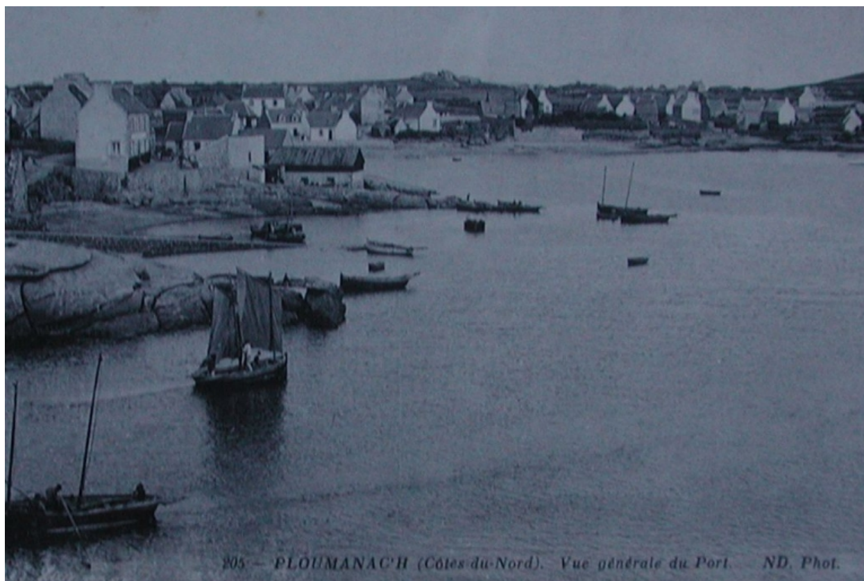
Vue d'ensemble des premiers ouvrages portuaires au 1er quart du 20ème siècle (collection particulière)
