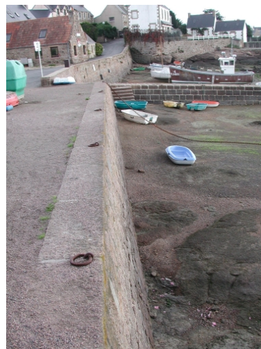
Le mur de quai devant Ty Ruz et les deux cales Phot. Guy Prigent IVR53_20062207810NUCA
