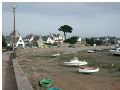
Les nouveaux murs de quais qui joignent la rue appelée quai Bellevue et la grève d'échouage à mare basse Phot. Guy Prigent IVR53_20062207739NUCA
