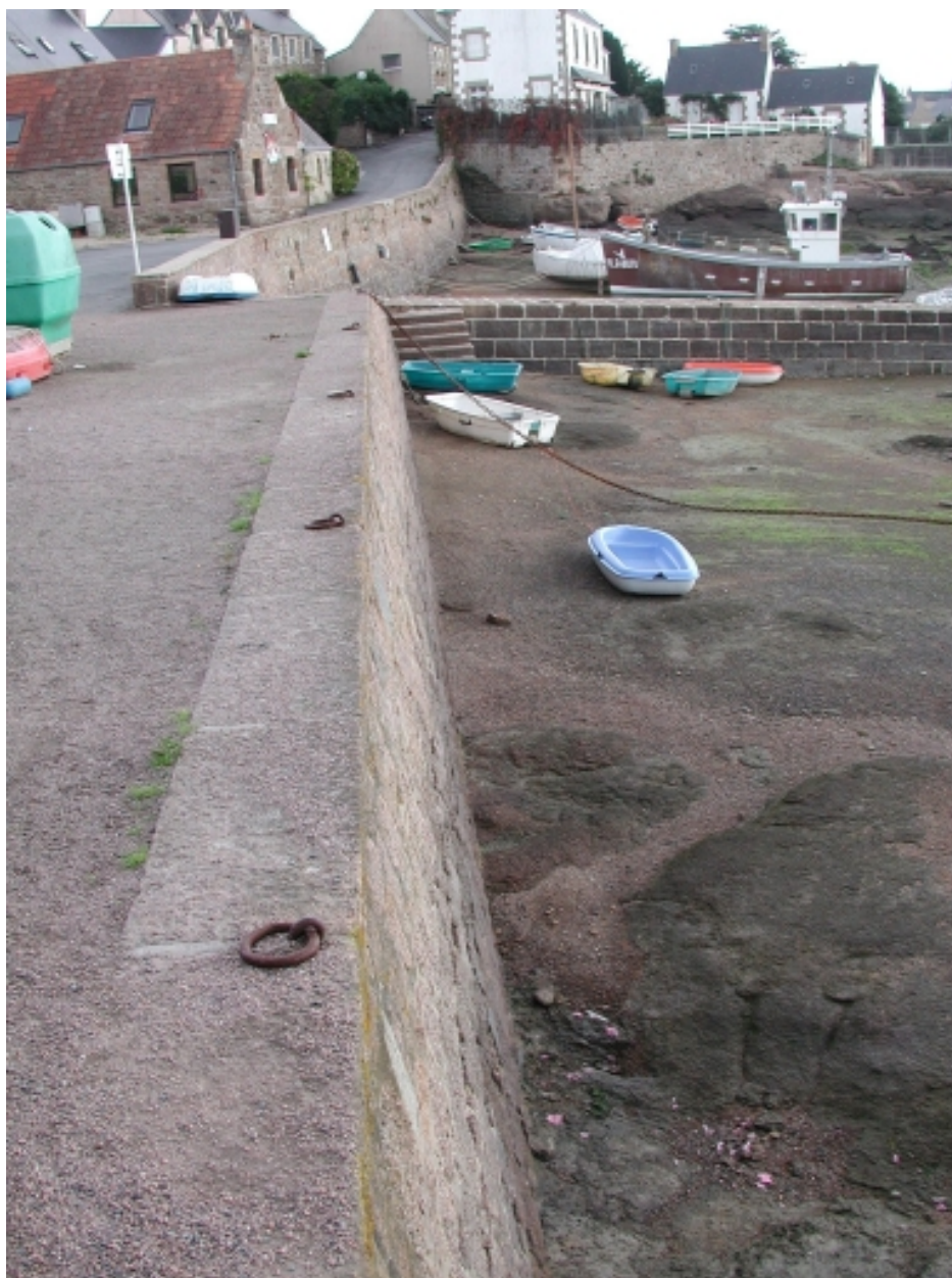
Le mur de quai devant Ty Ruz et les deux cales
