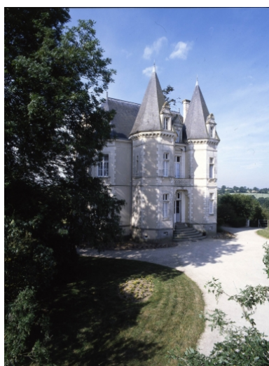
Vue générale nord Phot. Guy Artur, Phot. Norbert Lambart IVR53_19973500703XA
