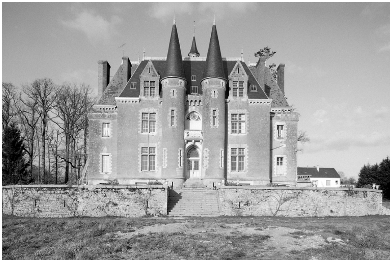
Vue générale, façade principale.
