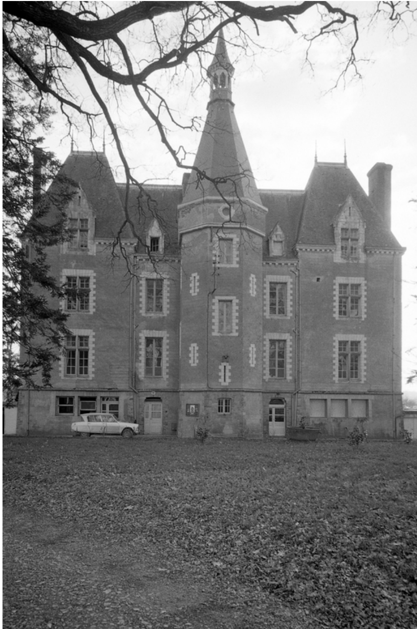
Vue générale, façade postérieure.
