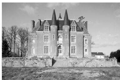
Vue générale, façade principale. Phot. François Dagorn IVR53_19713500187V
