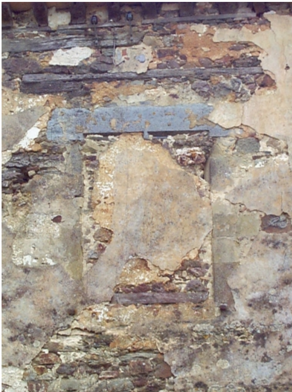
Anciennes baies bouchées dans le mur est du logis subsistant.
