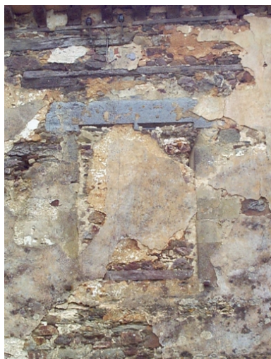
Anciennes baies bouchées dans le mur est du logis subsistant. Phot. Xavier Gilbert IVR53_19983503600NUCA
