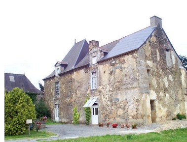
Vestiges du corps de logis. Phot. Xavier Gilbert IVR53_19983503575NUCA
