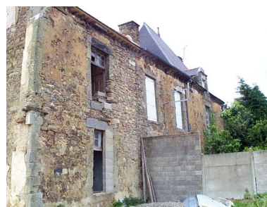
Corps de logis : vue partielle ouest Phot. Xavier Gilbert IVR53_19983503581NUCA
