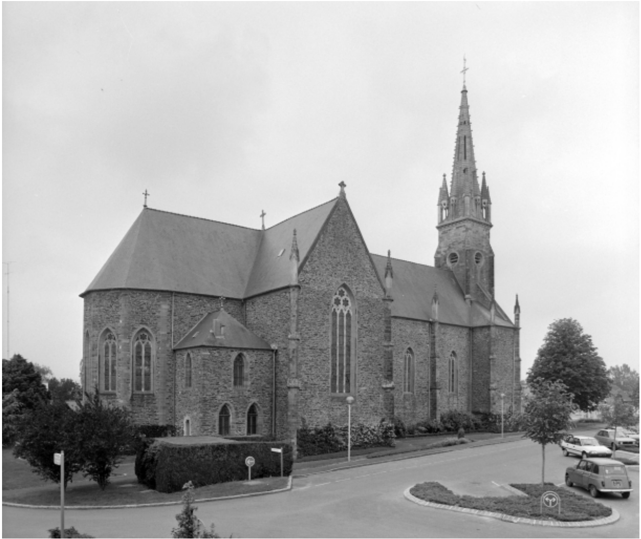
Elévation Nord-Est : vue générale
