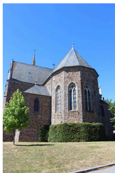
Chevet : vue générale Phot. Déborah De Sousa Figueiredo IVR53_20163505724NUCA
