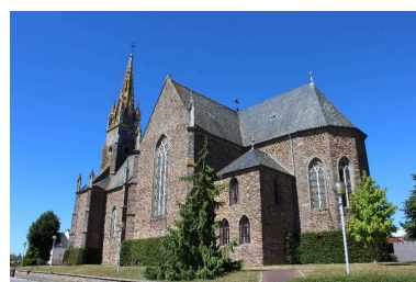
Elévation sud : vue générale Phot. Déborah De Sousa Figueiredo IVR53_20163505721NUCA
