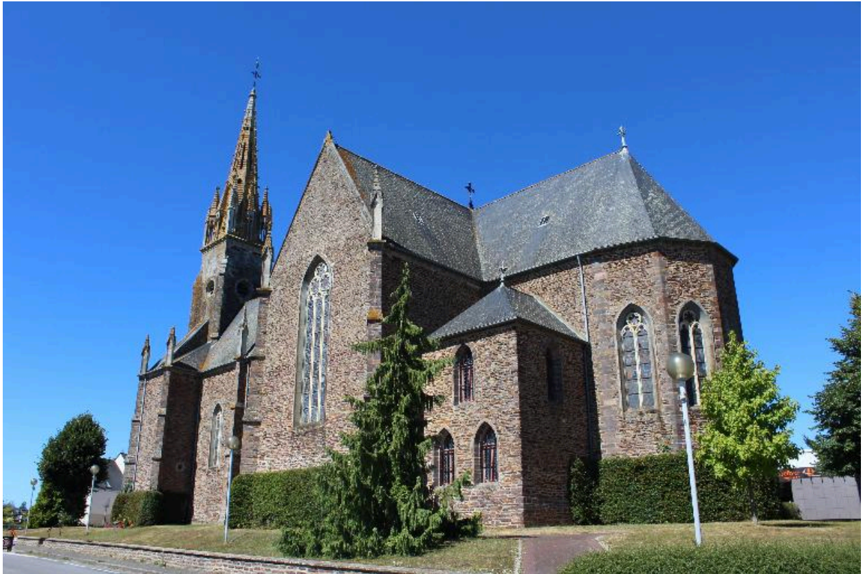
Elévation sud : vue générale
