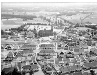
Vue aérienne. Phot. G.A.L.A.T. IVR53_19843501027V
