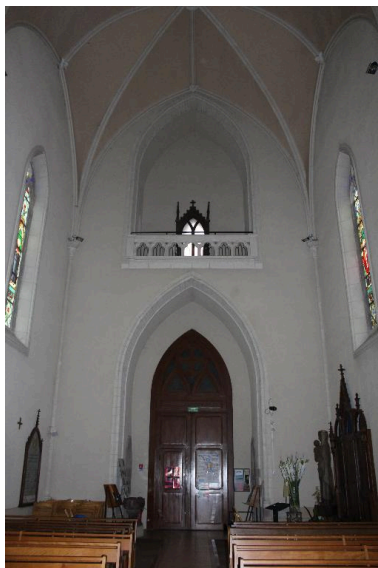
Nef intérieure : vue vers la façade ouest Phot. Déborah De Sousa Figueiredo IVR53_20163505726NUCA
