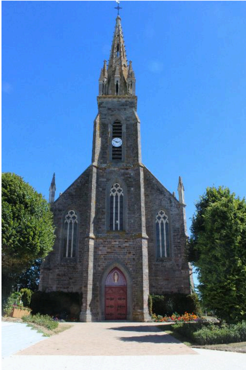
Façade principale : vue générale
