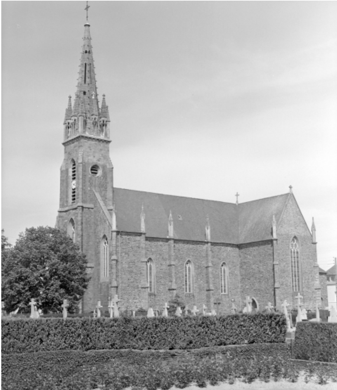
Elévation Sud-Ouest : vue générale
