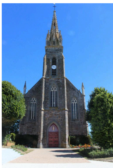
Façade principale : vue générale Phot. Déborah De Sousa Figueiredo IVR53_20163505722NUCA
