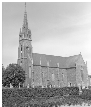
Elévation Sud-Ouest : vue générale Phot. Guy Artur, Phot. Norbert Lambart IVR53_19943500874X
