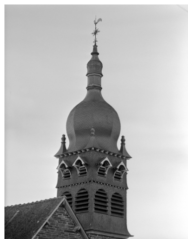
Elévation Nord-Est, Clocher : vue générale Phot. Guy Artur, Phot. Norbert Lambart IVR53_19943500913X
