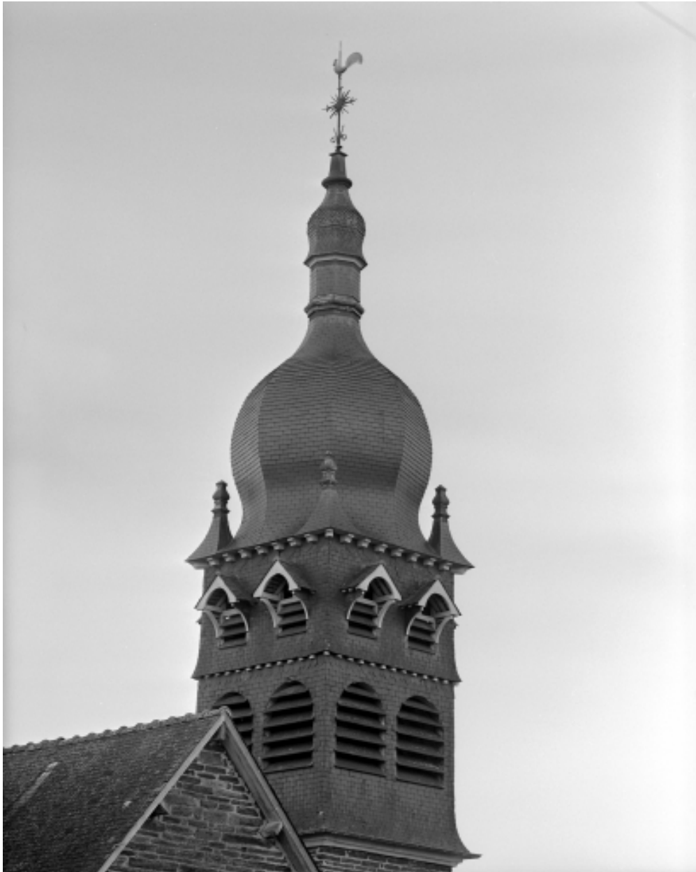
Elévation Nord-Est, Clocher : vue générale
