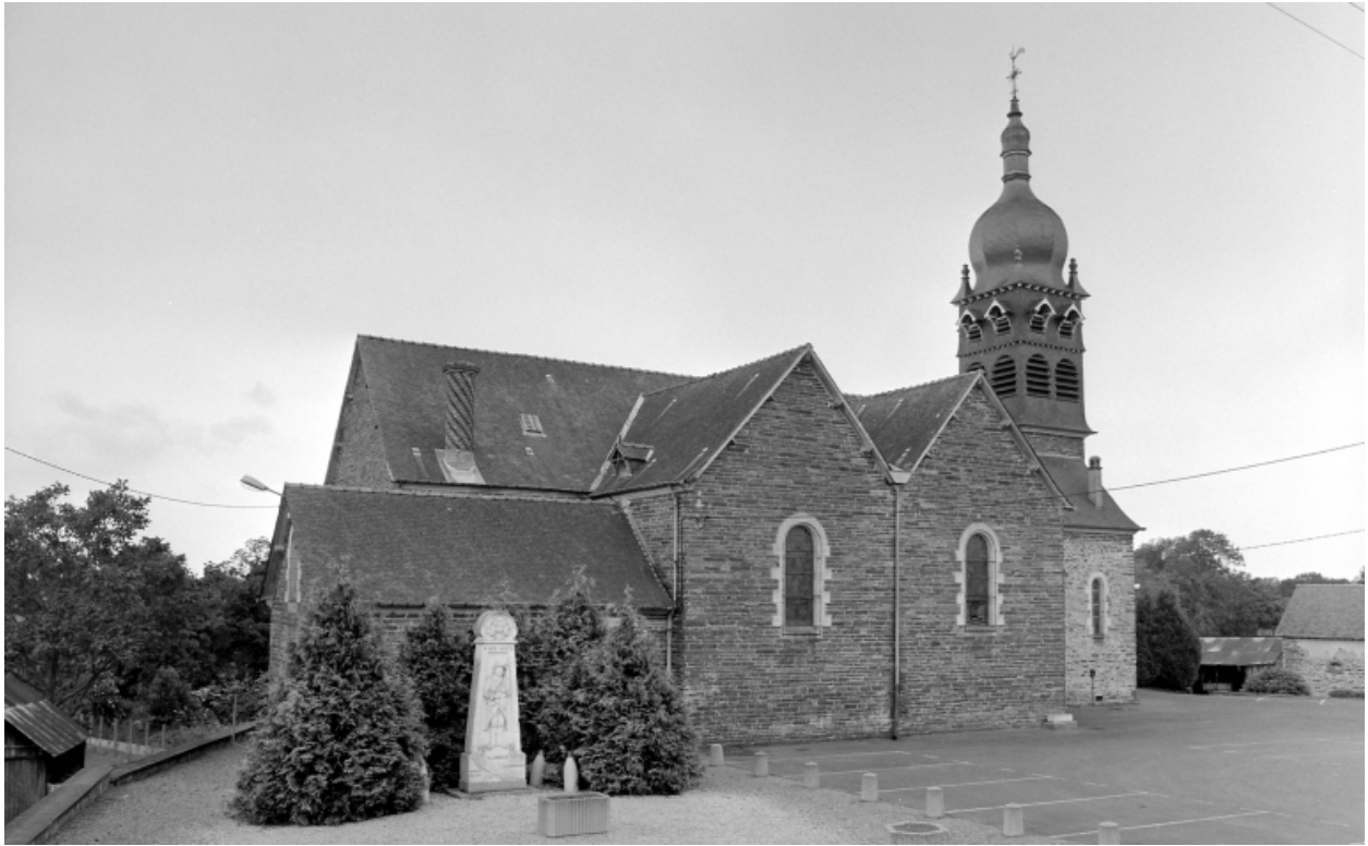
Elévation Nord : vue générale
