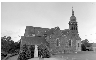
Elévation Nord : vue générale Phot. Guy Artur, Phot. Norbert Lambart IVR53_19943500912X
