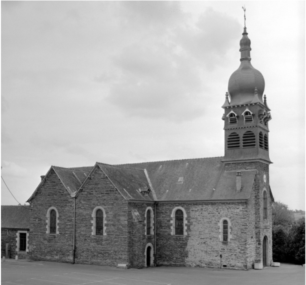
Elévation Nord-Ouest : vue générale
