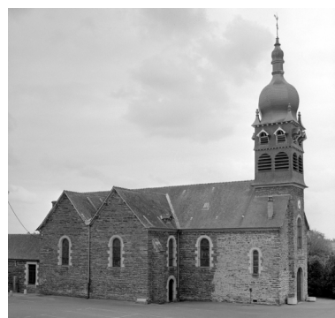
Elévation Nord-Ouest : vue générale Phot. Guy Artur, Phot. Norbert Lambart IVR53_19943500910X
