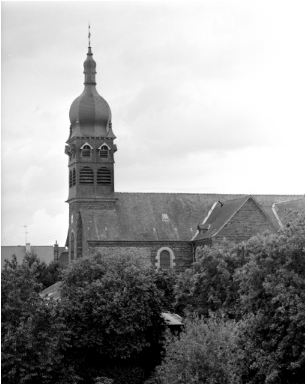
Elévation Sud, partie Ouest : vue générale
