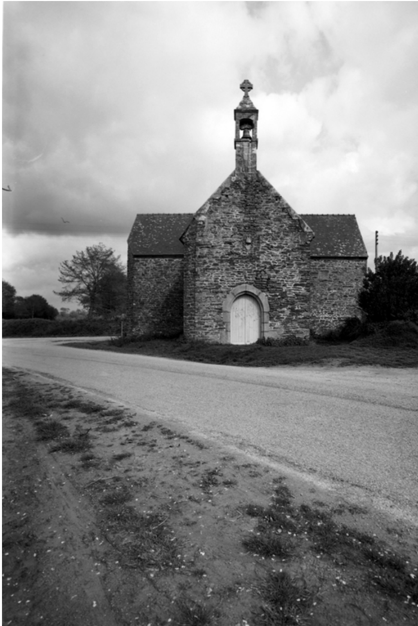
Vue générale, extérieur (ouest)
