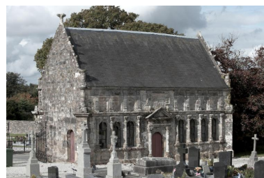
Vue sud-ouest de l'ossuaire Phot. Bernard Bègne IVR53_20162900303NUCA
