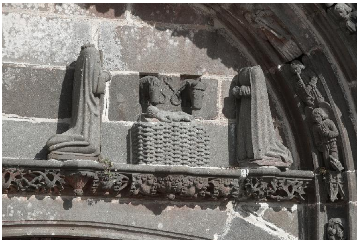
Vue de la nativité sur le porche ouest
