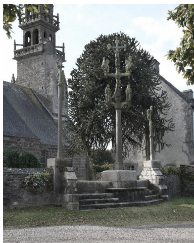
Vue générale du calvaire au nord de l'église Phot. Bernard Bègne IVR53_20162900311NUCA
