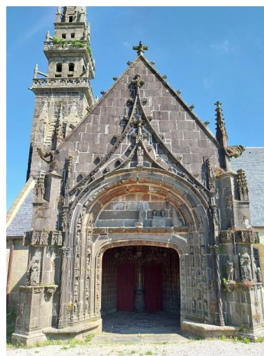
Proche sud, vue de face Phot. Valentine Guillevic IVR53_20252910679NUCA
