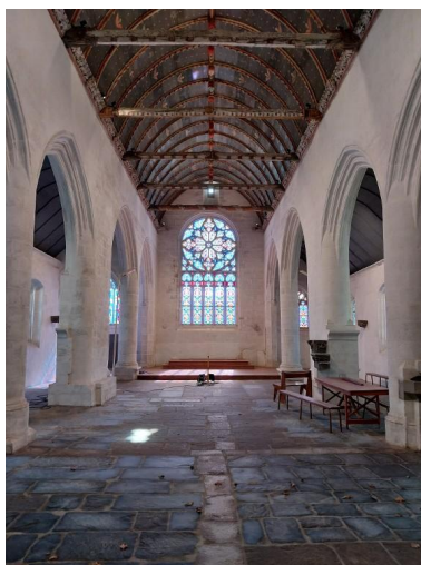
Vue de la nef centrale et du chœur depuis l'est, pendant les travaux de restauration Phot. Valentine Guillevic IVR53_20252910677NUCA
