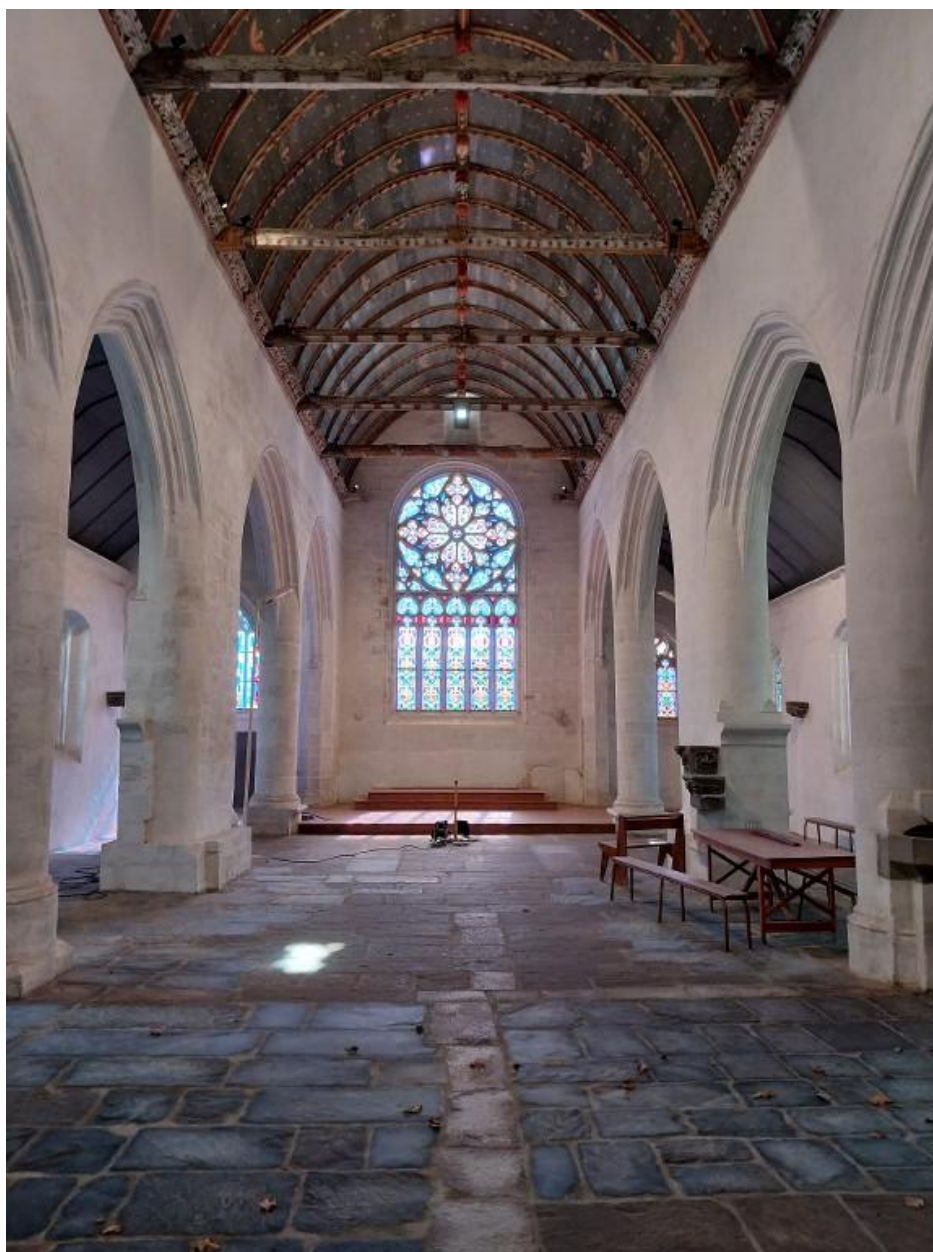
Vue de la nef centrale et du chœur depuis l'est, pendant les travaux de restauration
