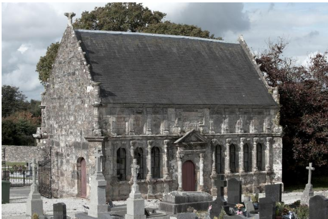
Vue sud-ouest de l'ossuaire
