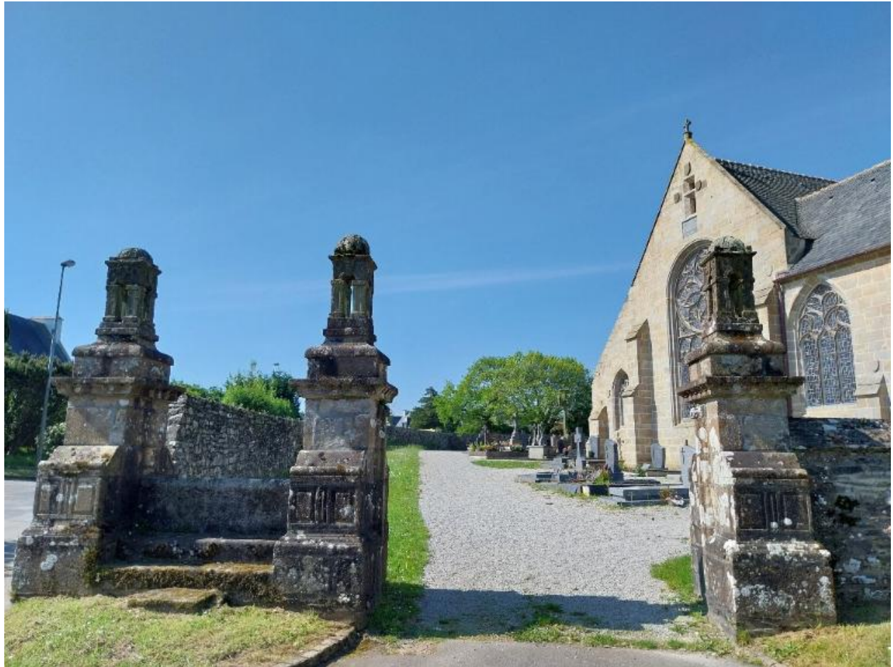
Entrée à piliers et échaliers, au nord-est, vue depuis l'extérieur de l'enclos
