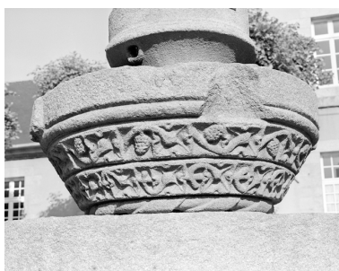
Vue de détail (état en 1984)
