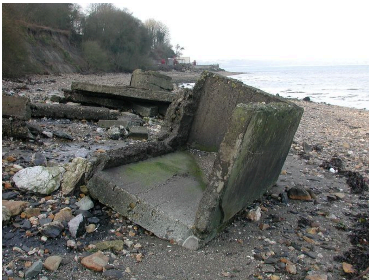
Vue des vestiges disloqués sur l'estran de l'une des quatre cuves pour canon antiaérien de 4 cm (état en 2002)
