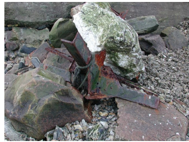
Vue d'un hérisson tchèque, obstacle anti-char statique en acier (état en 2002). Il est réutilisé pour la défense contre la mer des installations ostréicoles Phot. Guillaume Lécueillier IVR53_20022901683NUCA
