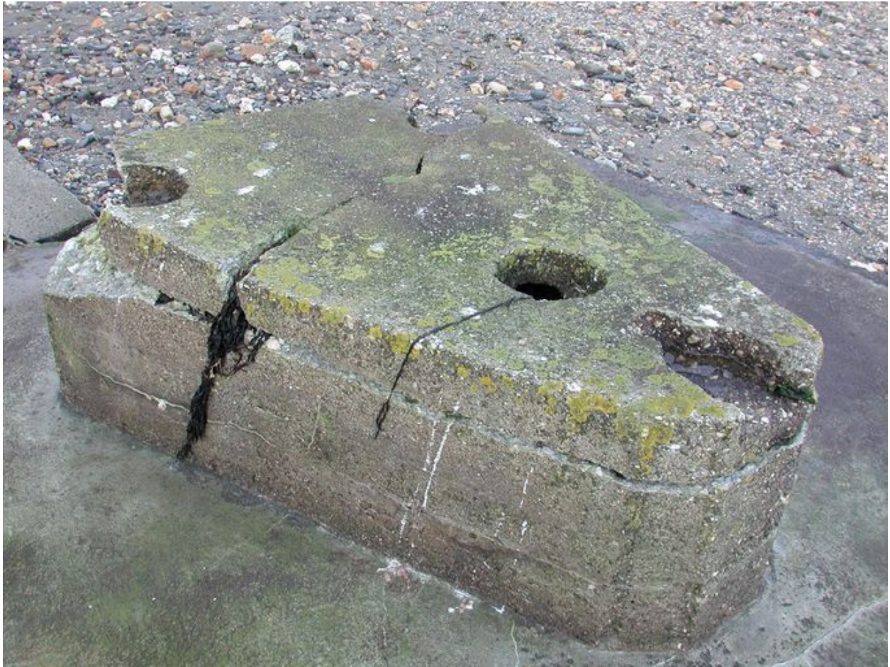
Vue des vestiges disloqués sur l'estran de l'une des quatre cuves pour canon antiaérien de 4 cm : soubassement de forme triangulaire servant de support à l'affût (état en 2002)
