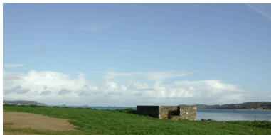
Vue de l'une des cuves pour canon antiaérien de 4 cm (état en 2002) Phot. Guillaume Lécueillier IVR53_20022901466NUCA
