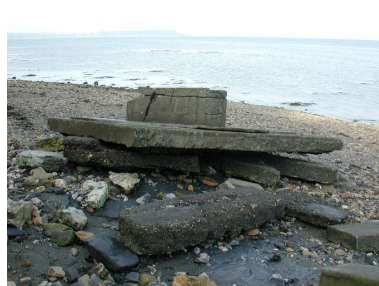
Vue des vestiges disloqués sur l'estran de l'une des quatre cuves pour canon antiaérien de 4 cm (état en 2002) Phot. Guillaume Lécueillier IVR53_20022901681NUCA
