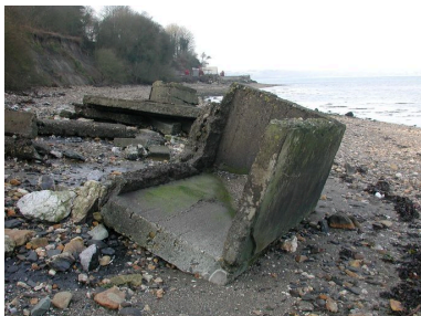
Vue des vestiges disloqués sur l'estran de l'une des quatre cuves pour canon antiaérien de 4 cm (état en 2002) Phot. Guillaume Lécueillier IVR53_20022901677NUCA
