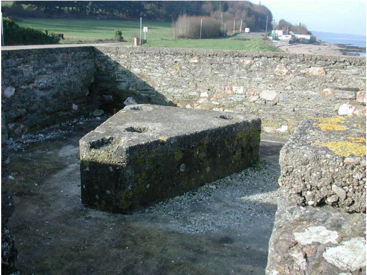
Vue de l'une des cuves pour canon antiaérien de 4 cm : soubassement de forme triangulaire servant de support à l'affût (état en 2002)
