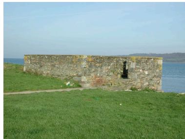
Vue de l'une des cuves pour canon antiaérien de 4 cm (état en 2002) Phot. Guillaume Lécueillier IVR53_20022901672NUCA
