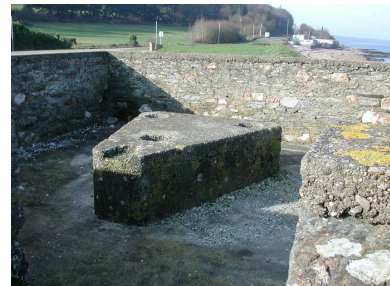
Vue de l'une des cuves pour canon antiaérien de 4 cm : soubassement de forme triangulaire servant de support à l'affût (état en 2002) Phot. Guillaume Lécueillier IVR53_20022901673NUCA
