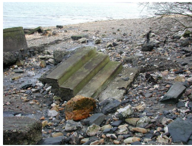
Vue des vestiges disloqués sur l'estran de l'une des quatre cuves pour canon antiaérien de 4 cm : escalier d'accès (état en 2002) Phot. Guillaume Lécueillier IVR53_20022901679NUCA
