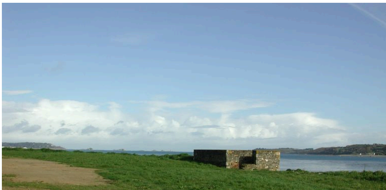
Vue de l'une des cuves pour canon antiaérien de 4 cm (état en 2002)
