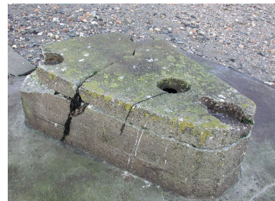
Vue des vestiges disloqués sur l'estran de l'une des quatre cuves pour canon antiaérien de 4 cm : soubassement de forme triangulaire servant de support à l'affût (état en 2002) Phot. Guillaume Lécueillier IVR53_20022901678NUCA
