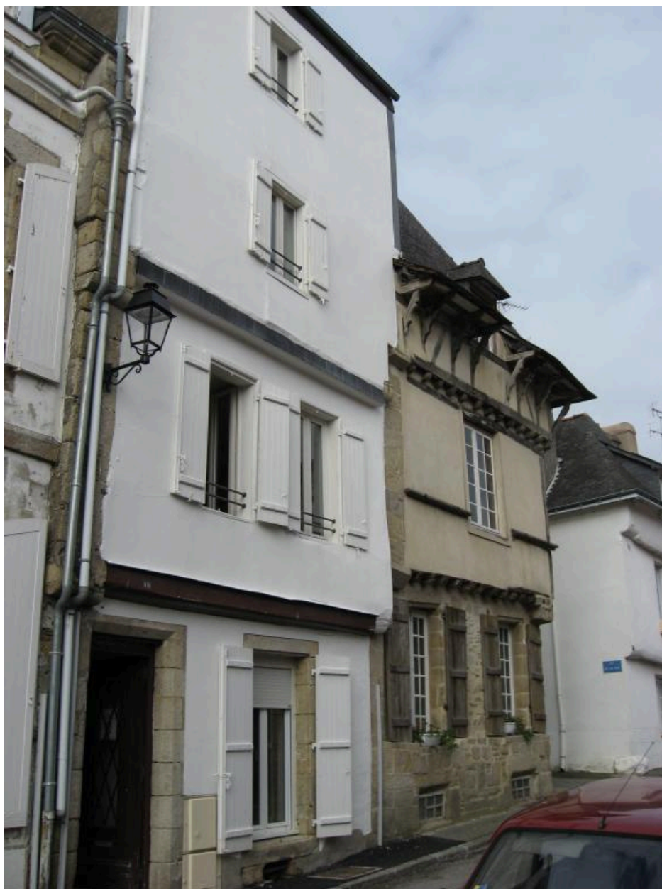
Vue générale, façade sur rue
