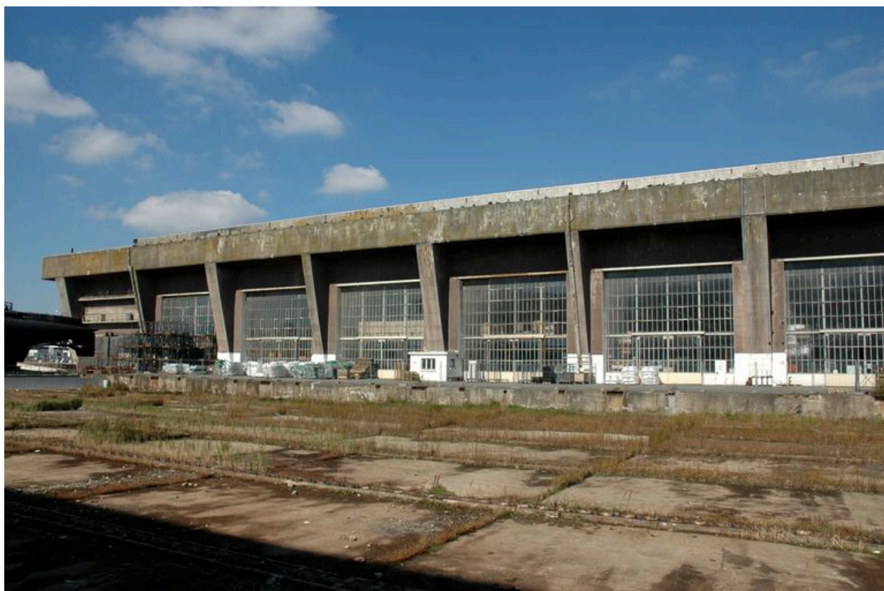
Vue du front avant : contreforts et dalle de couverture (2005). L'édifice compte huit alvéoles dont celle servant d'abri au chariot de translation des sous-marins (abri surmonté par la caserne dites des 1000)
