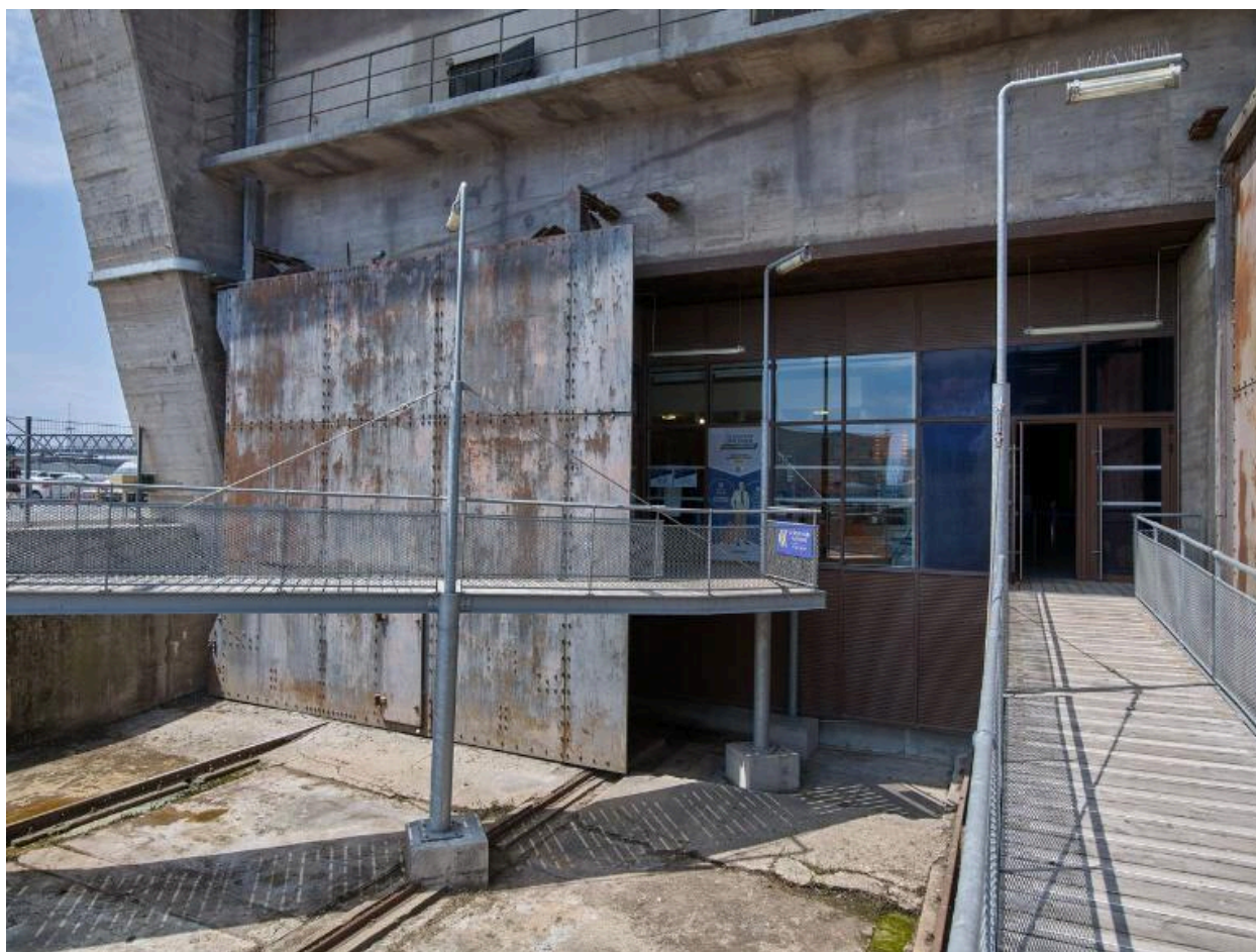
Vue du front avant : entrée de l'alvéole "K6a", portes blindées et passerelles du musée (2021)
