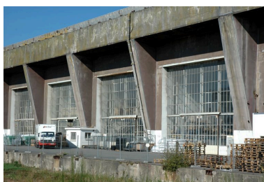
Vue de détail du front avant : contreforts et dalle de couverture (2005) Phot. Guillaume Lécueillier IVR53_20055603550NUCA
