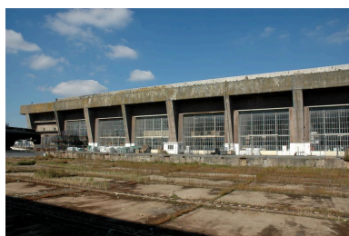
Vue du front avant : contreforts et dalle de couverture (2005). L'édifice compte huit alvéoles dont celle servant d'abri au chariot de translation des sous-marins (abri surmonté par la caserne dites des 1000) Phot. Guillaume Lécueillier IVR53_20055603559NUCA
