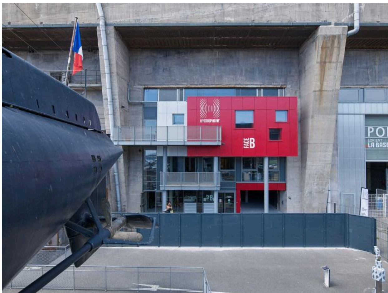
Vue de l'entrée ouest de l'alvéole "K6" abritant l'Hydrophone (2021). Cet équipement est dédié aux musiques actuelles)
