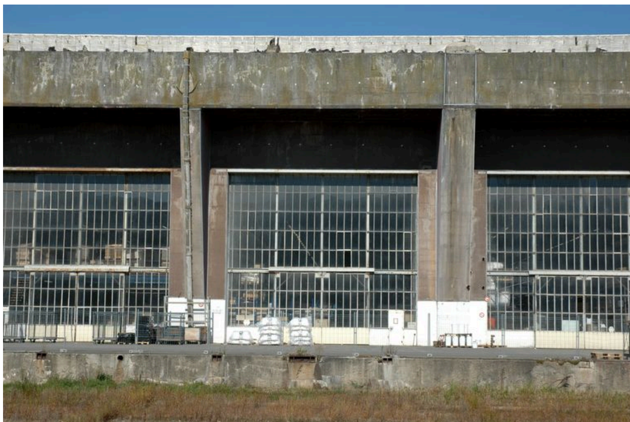
Vue du front avant : alvéoles (2005)
