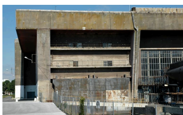
Vue de l'angle sud-ouest : contreforts et dalle de couverture (2005). La première alvéole nommé "K6a" sert d'abri au chariot de translation des sous-marins. Les quatre entrées/sorties situées au premier étage correspondent à la caserne dite des 1000 Phot. Guillaume Lécueillier IVR53_20055603555NUCA
