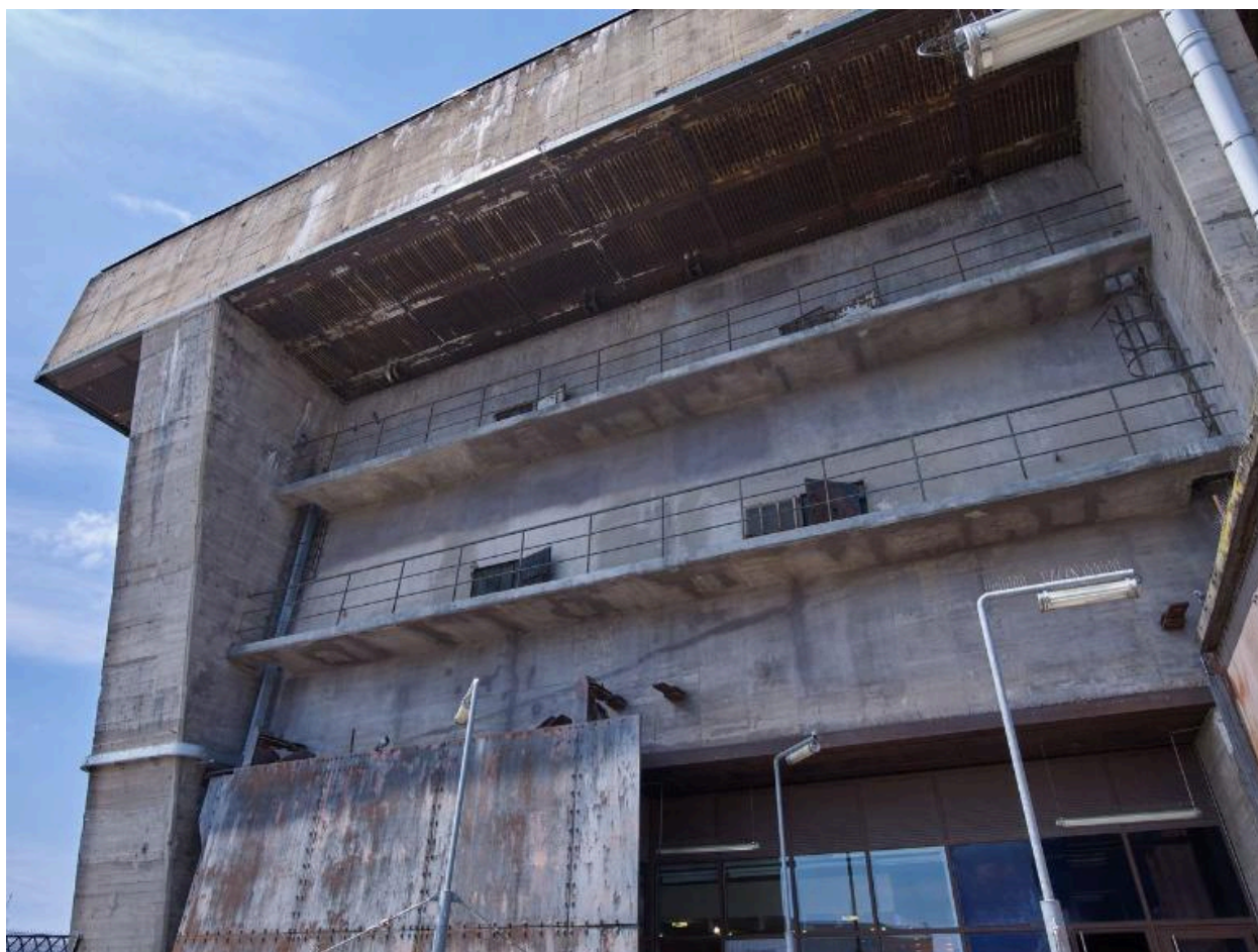
Vue du front avant : étage de l'alvéole "K6a", caserne dite des 1000 (2021)
