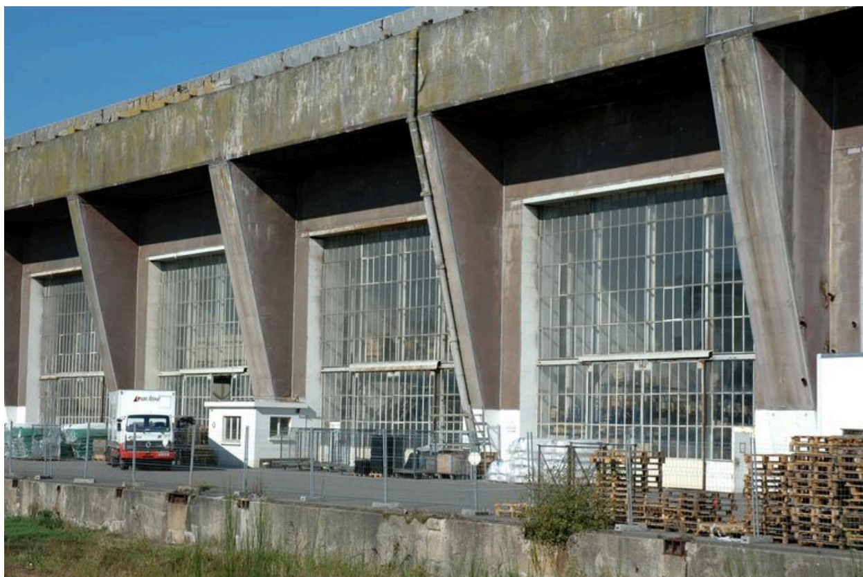
Vue de détail du front avant : contreforts et dalle de couverture (2005)
