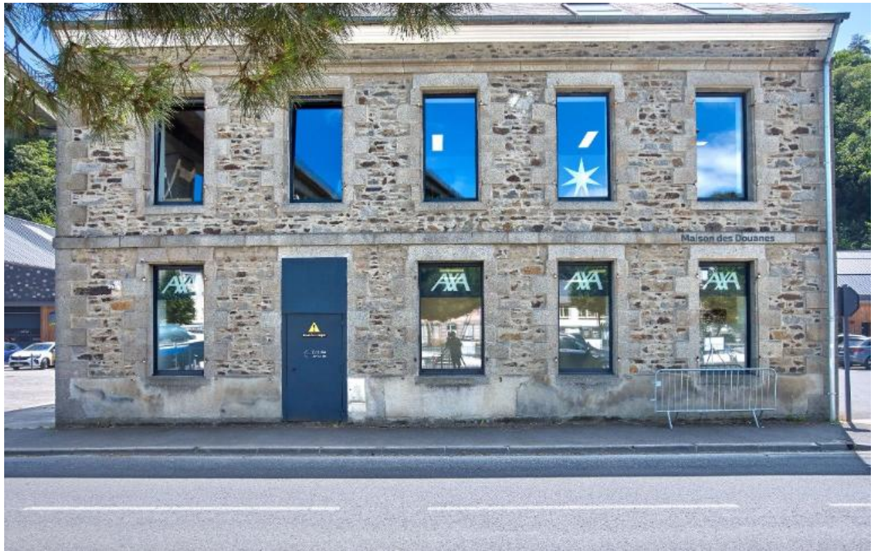
L'ancienne maison des douanes
