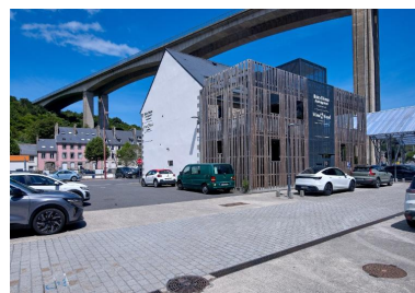
Création architecturale suite au projet de réhabilitation Phot. Bernard Bègne IVR53_20262200631NUCA
