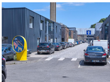
Création architecturale suite au projet de réhabilitation Phot. Bernard Bègne IVR53_20262200630NUCA
