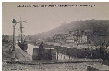
Carte postale, Le Légue, quais côté Saint-Brieuc, Cantonnement du 155e de Ligne, coll. E. Hamonic Autr. Emile Hamonic, Phot. Auteur inconnu IVR53_20262210072NUCB
