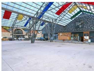
La charpente en métal reprend la forme des bâtiments détruits ; elle prend appui sur ceux conservés Phot. Bernard Bègne IVR53_20262200644NUCA
