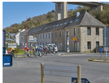
Alignement de bâtis construits à partir de 1847 Phot. Bernard Bègne IVR53_20262200267NUCA
