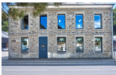
L'ancienne maison des douanes Phot. Bernard Bègne IVR53_20262200632NUCA
