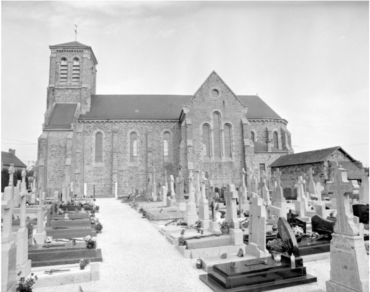
Elévation sud, vue générale.
