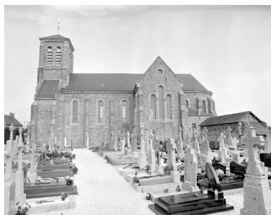
Elévation sud, vue générale. Phot. Guy Artur, Phot. Norbert Lambart IVR53_19873500271X
