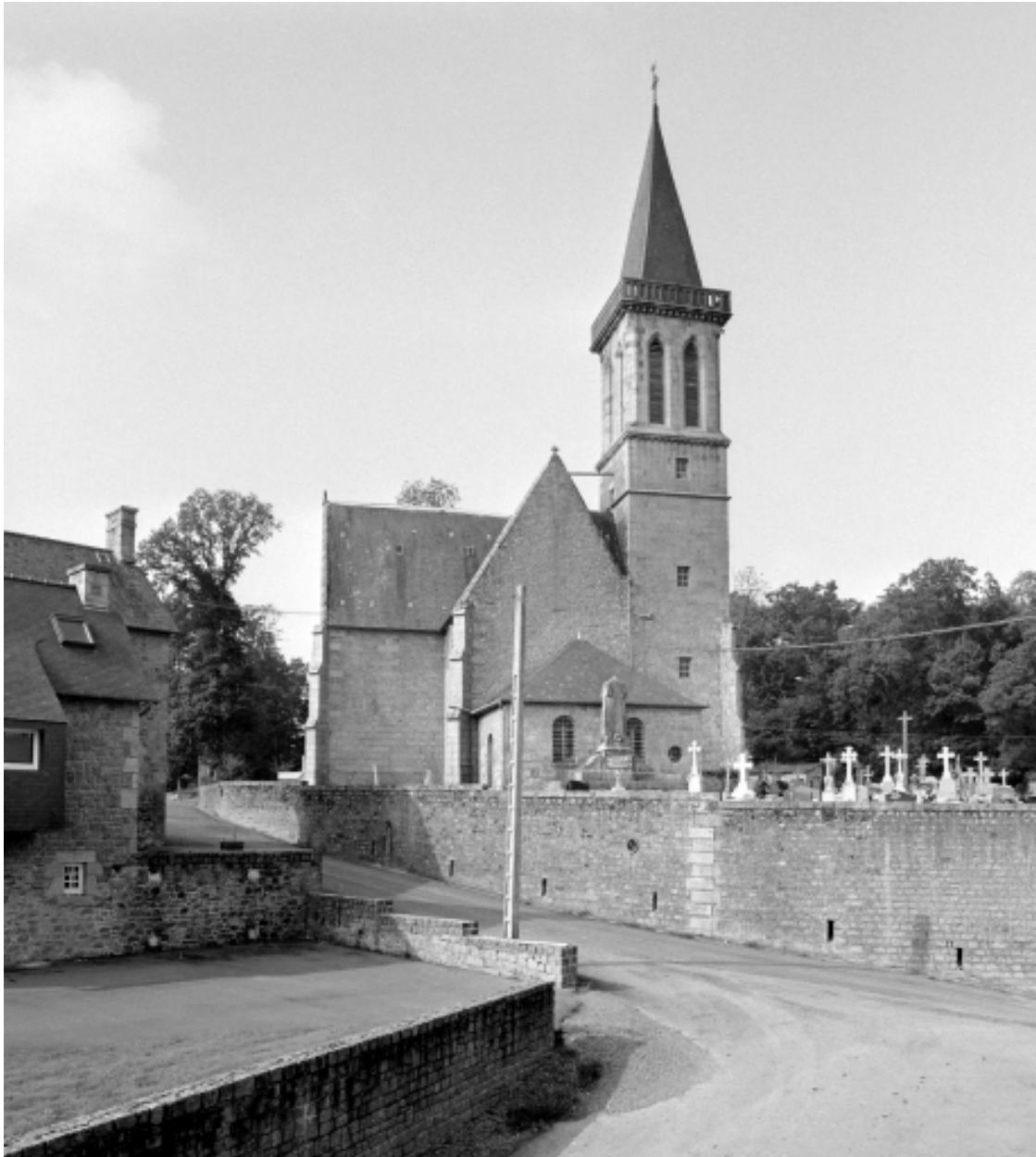
Elévation Est : vue générale
