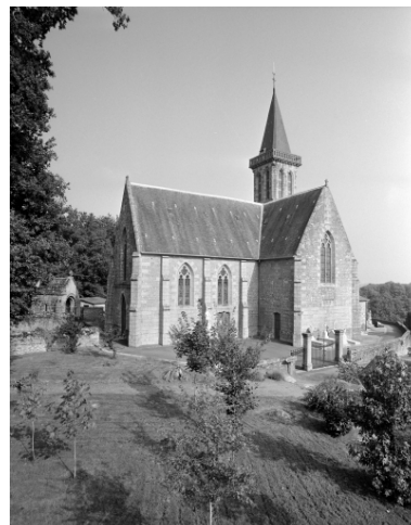
Elévation Sud-Ouest : vue générale Phot. Guy Artur, Phot. Norbert Lambart IVR53_19943501925X
