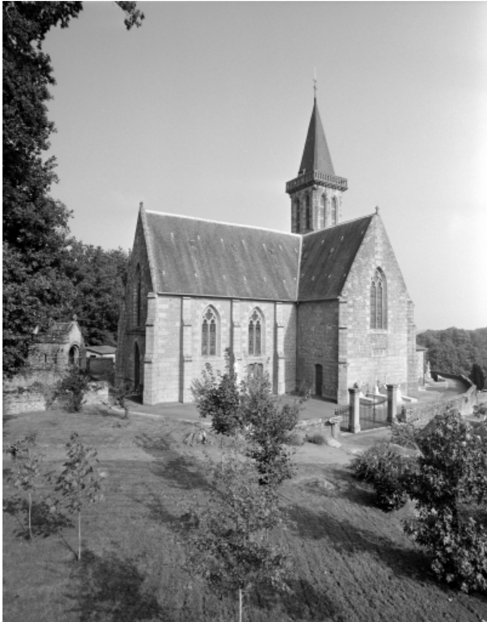
Elévation Sud-Ouest : vue générale
