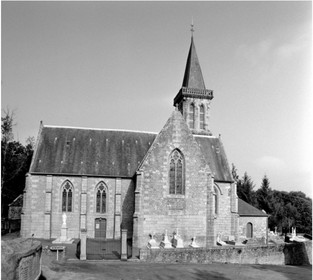
Elévation Sud : vue générale
