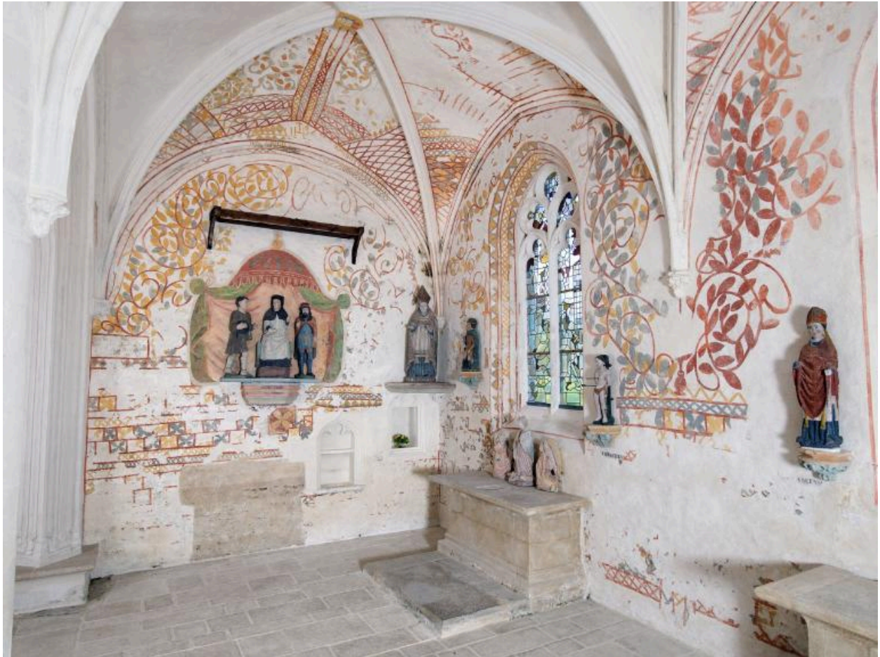
Vue de la chapelle nord après restauration de ses peintures
