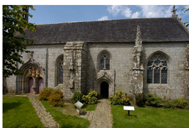
Vue frontale de l'élévation sud Phot. Norbert Lambart IVR53_20072900178NUCA
