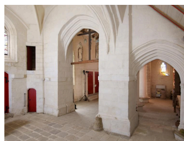
Piliers carrés supportant le clocher d'origine et portes d'accès au jubé disparu Phot. Bernard Bègne IVR53_20192900316NUCA
