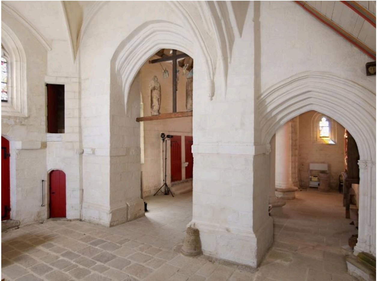
Piliers carrés supportant le clocher d'origine et portes d'accès au jubé disparu
