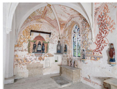
Vue de la chapelle nord après restauration de ses peintures Phot. Bernard Bègne IVR53_20192900306NUCA
