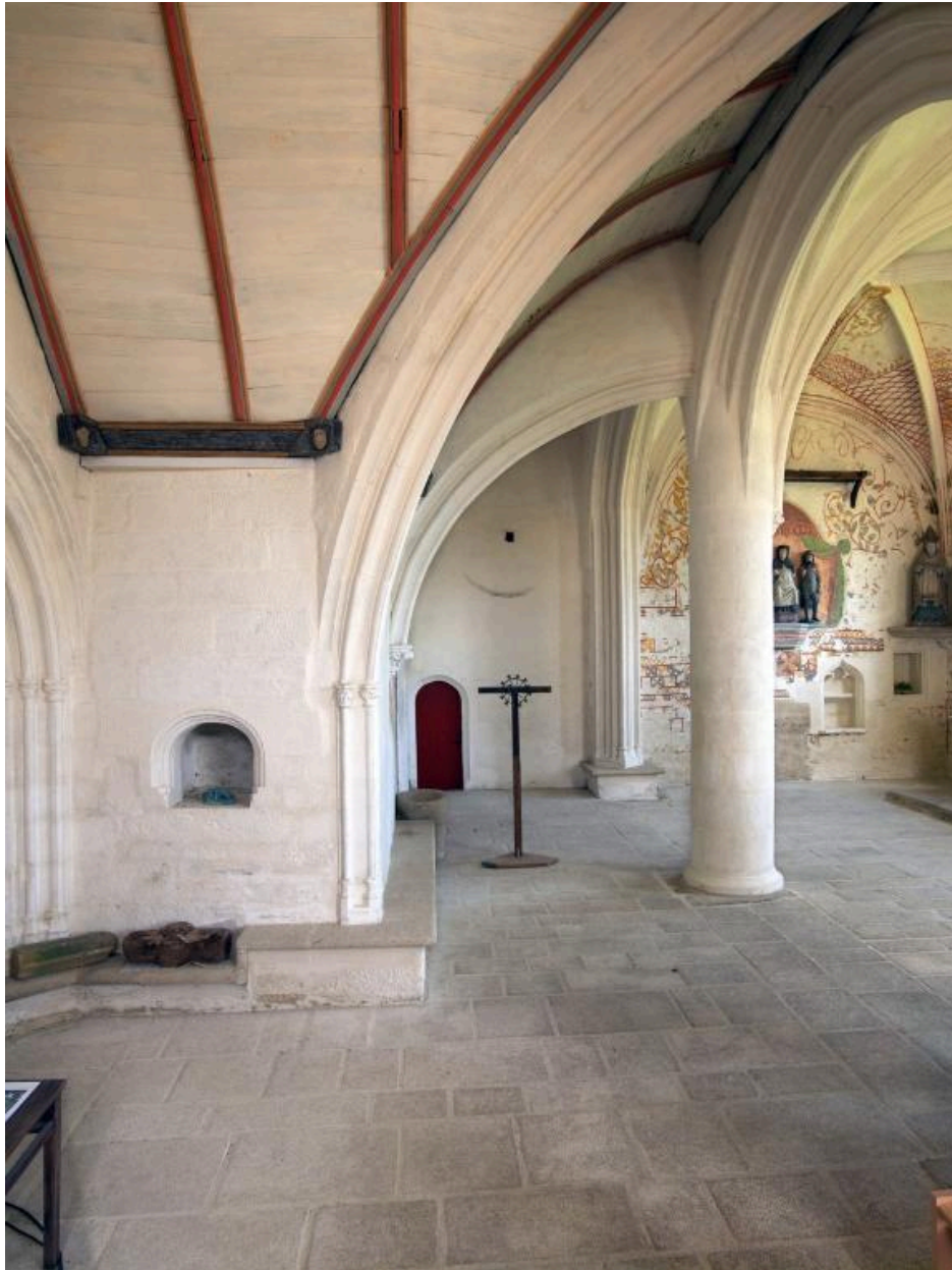
Raccord entre le bas coté de la nef et la chapelle nord, après restauration
