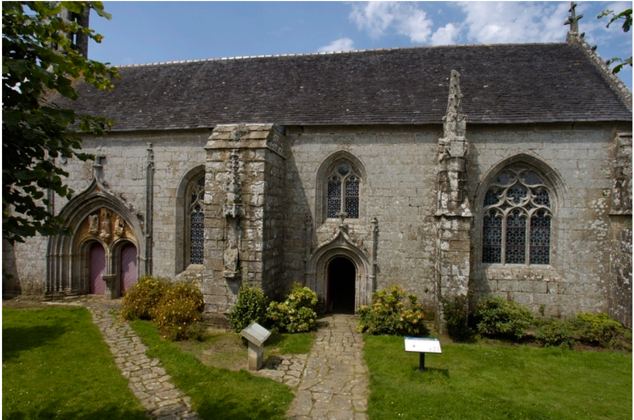
Vue frontale de l'élévation sud
