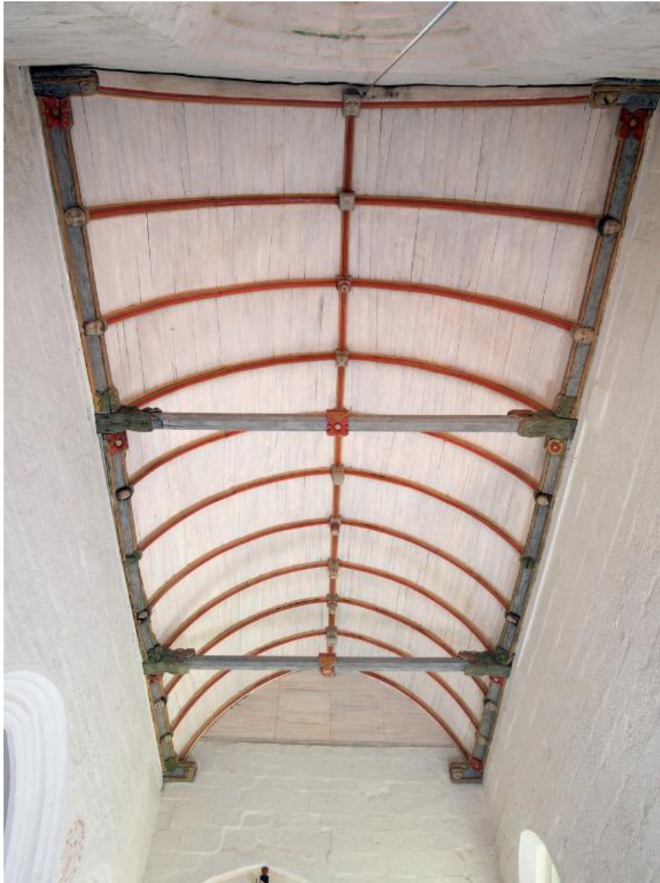
Charpente de la nef après restauration
