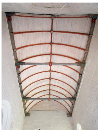
Charpente de la nef après restauration Phot. Bernard Bègne IVR53_20192900301NUCA
