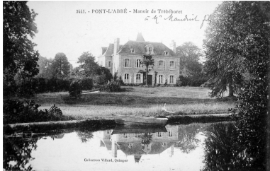
Vue de la façade postérieure Phot. Elise Lauranceau IVR53_20042905574NUCB
