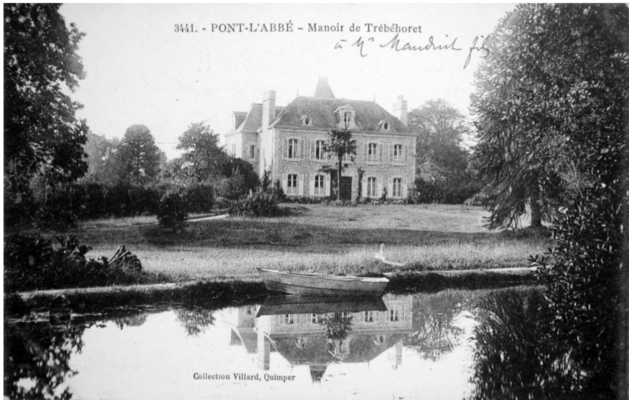
Vue de la façade postérieure
