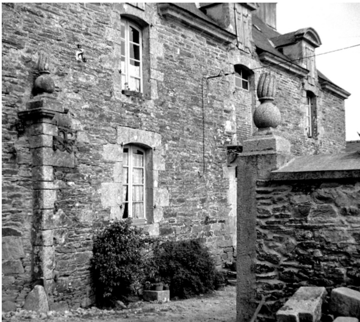
Portail d'entrée. Etat en 1969
