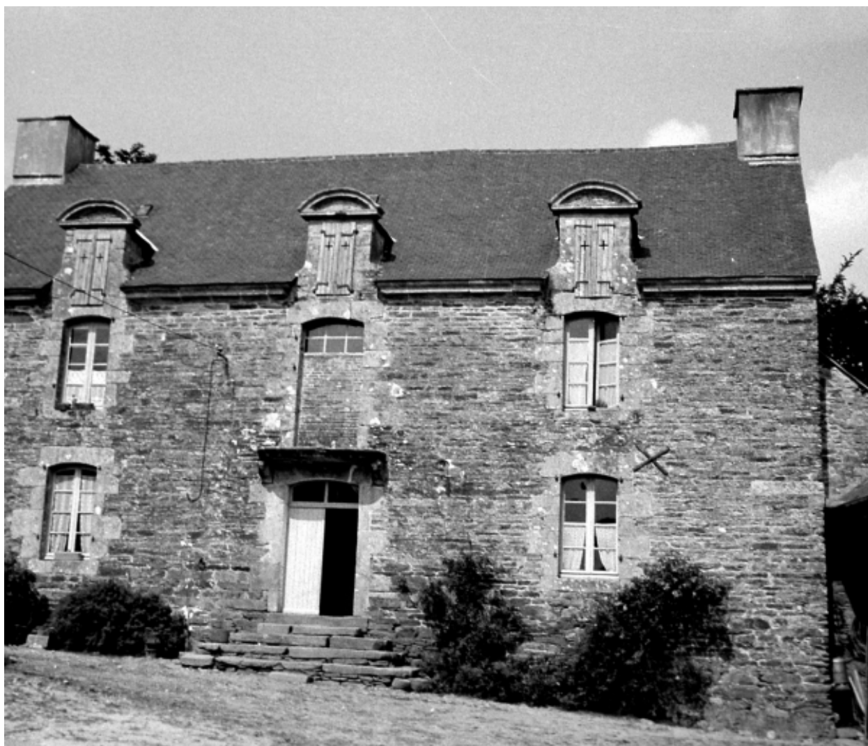
Elévation sud. Etat en 1969
