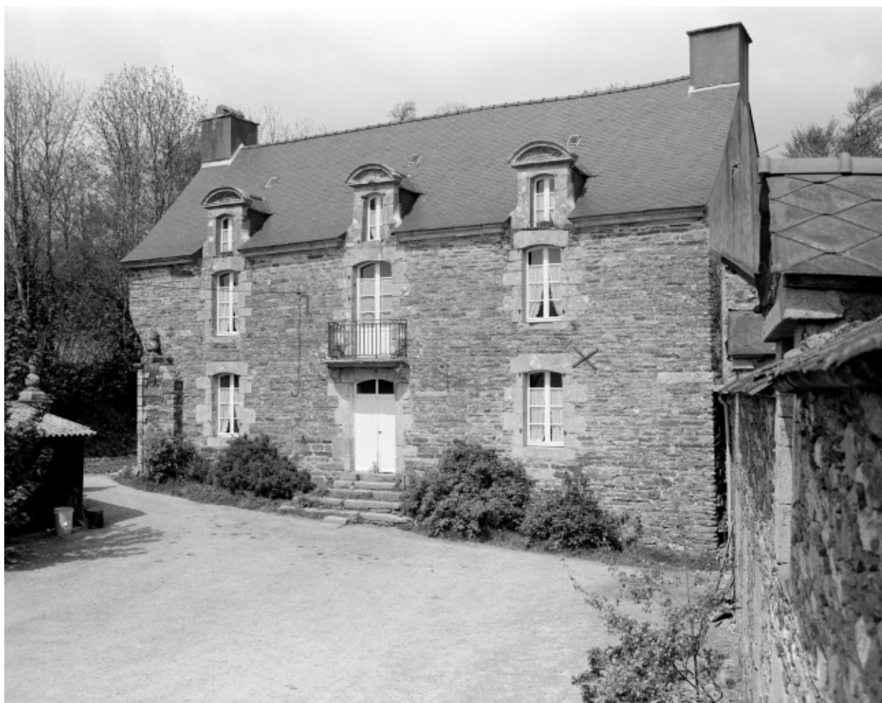
Vue générale sud. Etat en 1996
