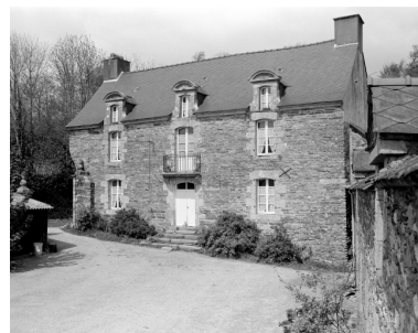
Vue générale sud. Etat en 1996 Phot. Bernard Bègne IVR53_19962200445X
