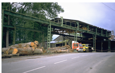
Vue générale nord-est : atelier et pont roulant. Phot. Marina Gasnier IVR53_19993502742ZA
