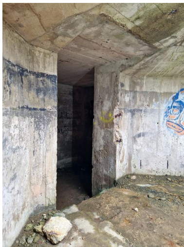
Vue intérieure : accès à l'escalier desservant le poste d'observation et de tir. Les murs sont tagués Phot. Guillaume Lécueillier IVR53_20242911182NUCA
