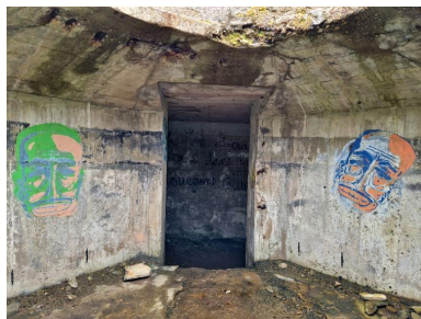
Vue intérieure : accès à l'escalier desservant le poste d'observation et de tir. Les murs sont tagués Phot. Guillaume Lécueillier IVR53_20242911183NUCA
