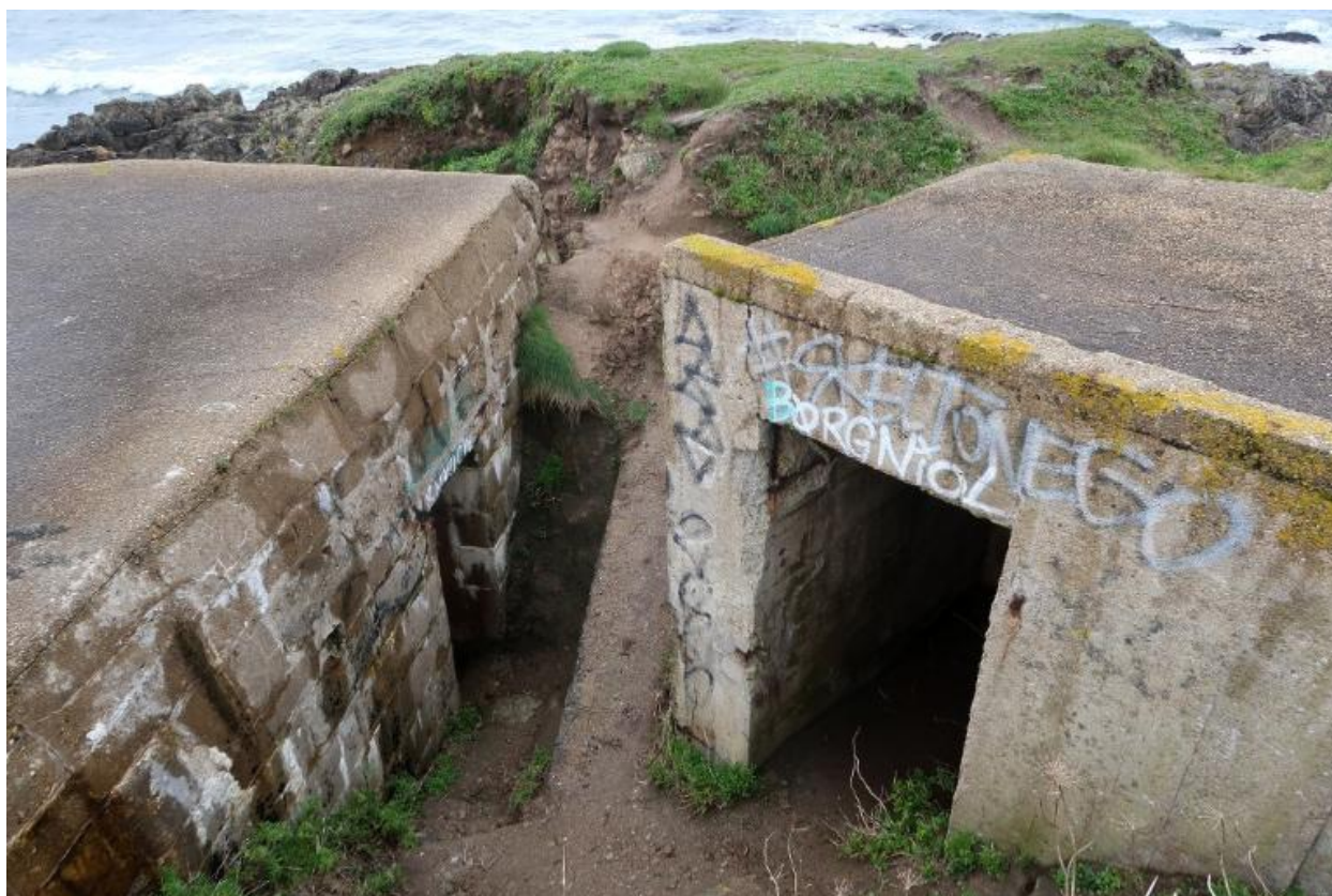
Vue de l'entrée. A gauche, l'une des trois entrées du bunker - abri
