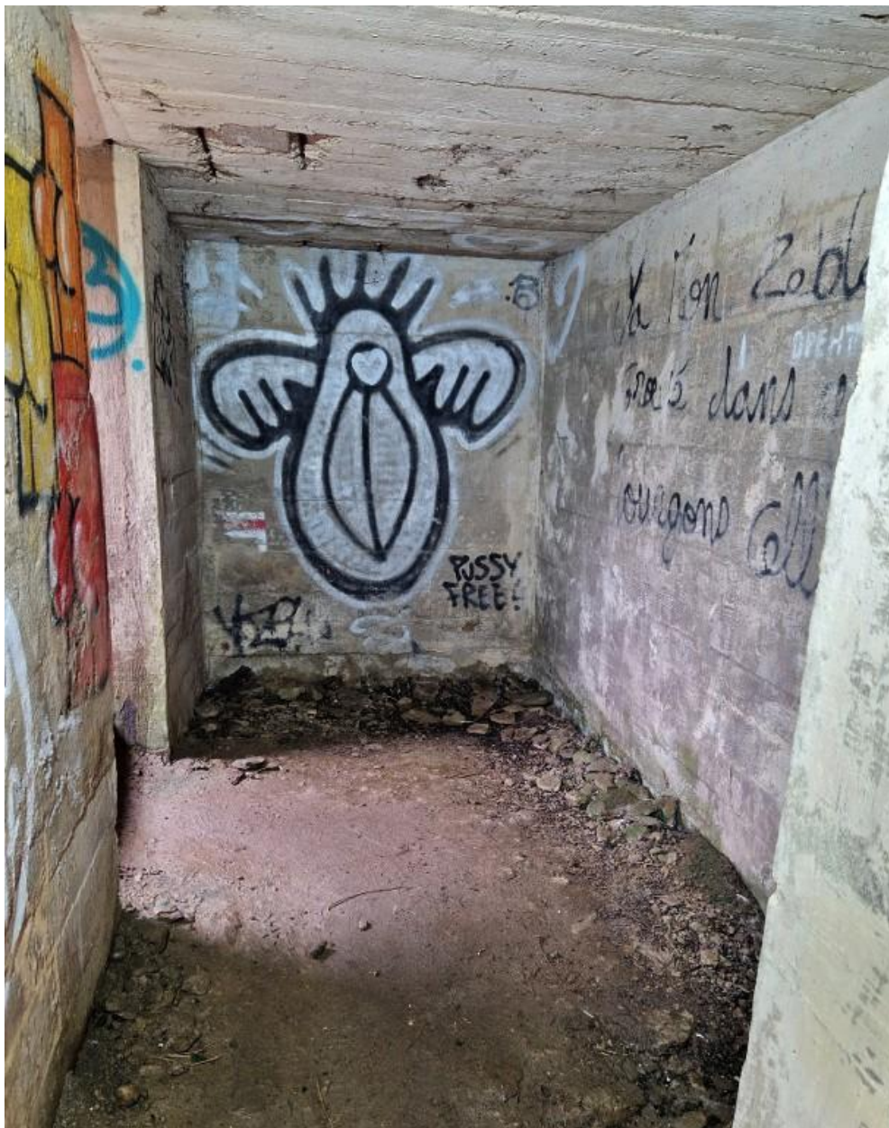
Vue intérieure : vestibule faisant magasin de munitions ; à gauche, l'escalier desservant le poste d'observation et de tir
