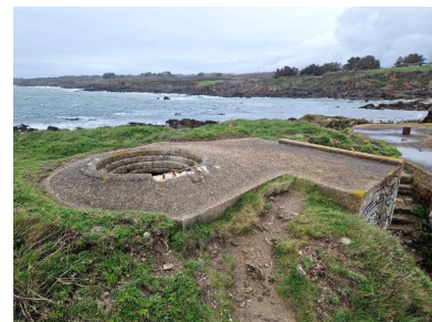
Vue générale Phot. Guillaume Lécueillier IVR53_20242911172NUCA
