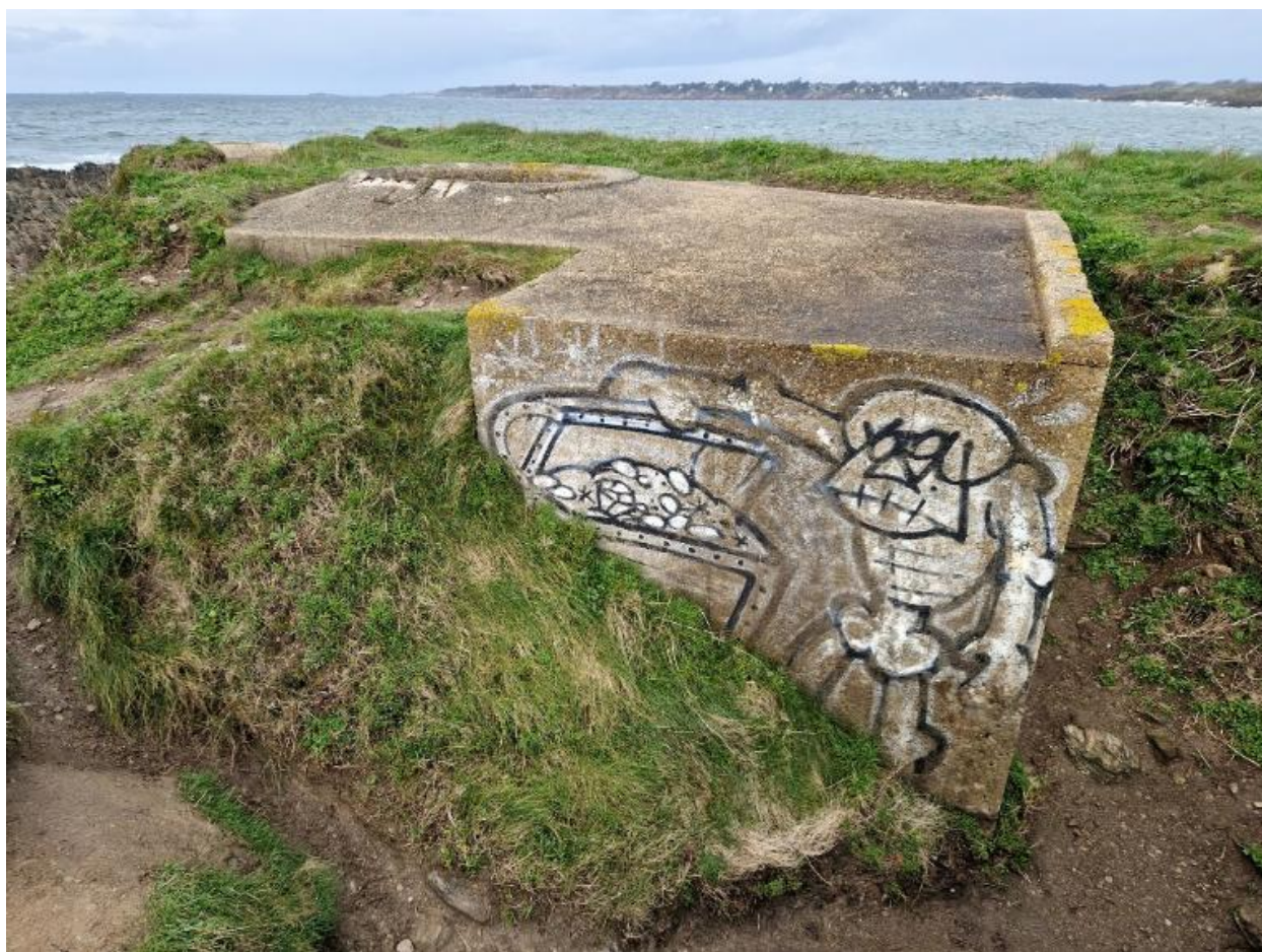
Vue générale. Le bunker est tagué
