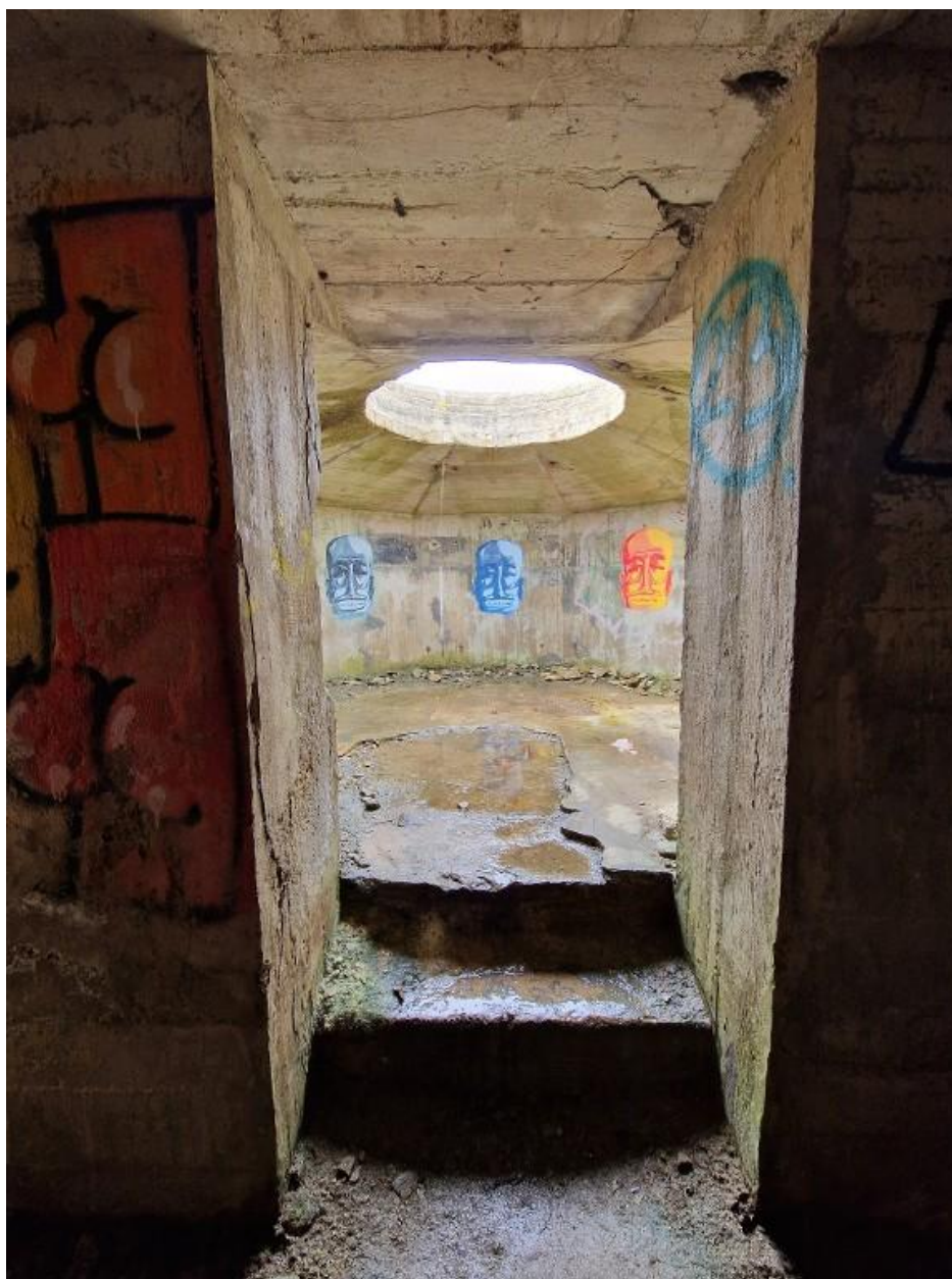
Vue intérieure : escalier desservant le poste d'observation et de tir
