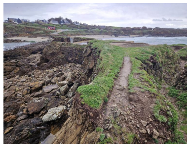
Vue de situation depuis l'extrémité ouest de l'îlot : le bunker est implanté en son centre, il est enterré dans le sol. À gauche, la maçonnerie de moellon cache le bunker - abri Phot. Guillaume Lécueillier IVR53_20242911171NUCA
