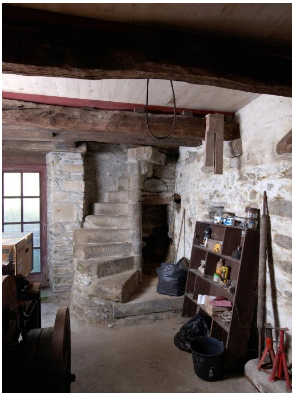
Tour d'escalier. Vue générale prise du sous-sol
