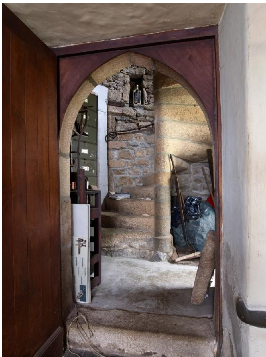
Tour d'escalier. Vue intérieure prise du rez-de-chaussée
