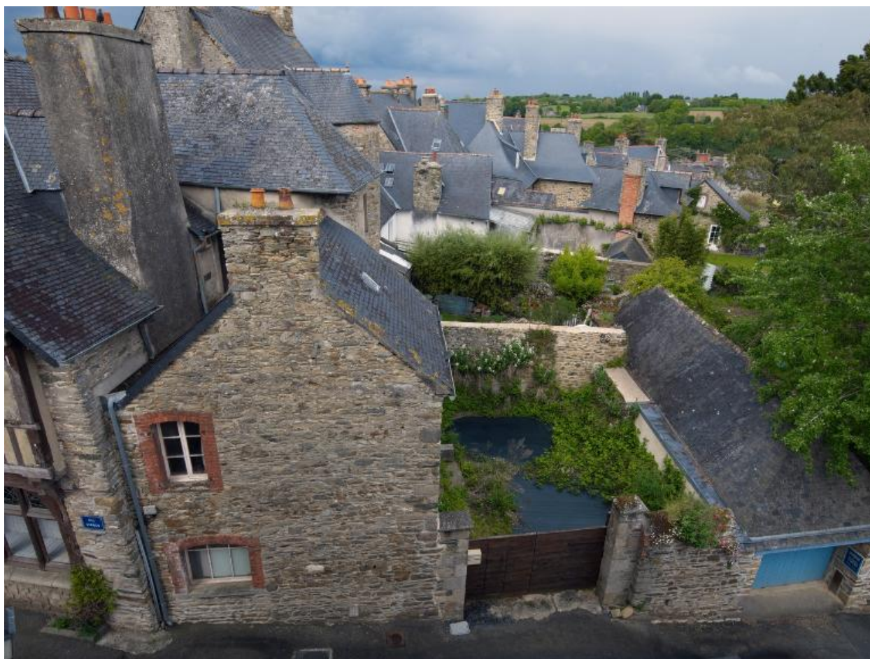
Vue générale ouest prise de la rue Stanco. Arrières des maisons et jardins
