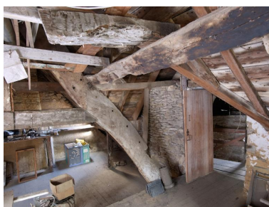
Combles. Vue partielle de la charpente Phot. Bernard Bègne IVR53_20172200573NUCA
