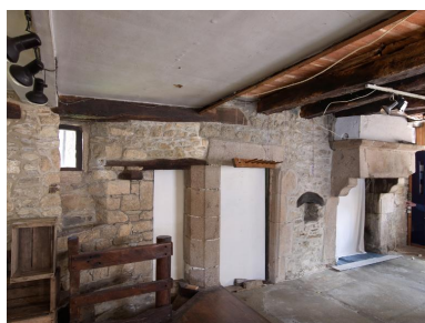
Rez-de-chaussée. Mur gouttereau sud. Portes jumelées ouvrant sur la tour d'escalier et cheminée de la pièce avant Phot. Bernard Bègne IVR53_20172200564NUCA
