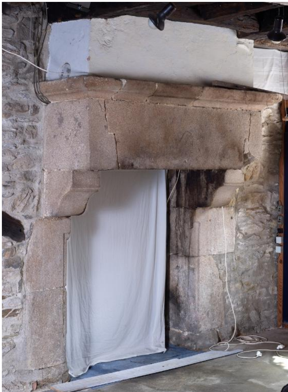
Rez-de-chaussée. Mur gouttereau sud. Cheminée correspondant à la pièce avant d'origine
