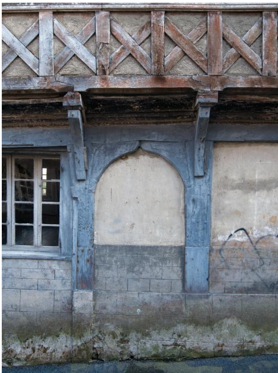
Façade nord. Détail de la porte centrale bouchée
