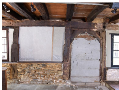
Rez-de-chaussée. Mur gouttereau nord. Porte centrale et poteau d'huisserie Phot. Bernard Bègne IVR53_20172200567NUCA
