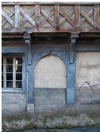
Façade nord. Détail de la porte centrale bouchée Phot. Bernard Bègne IVR53_20172200578NUCA
