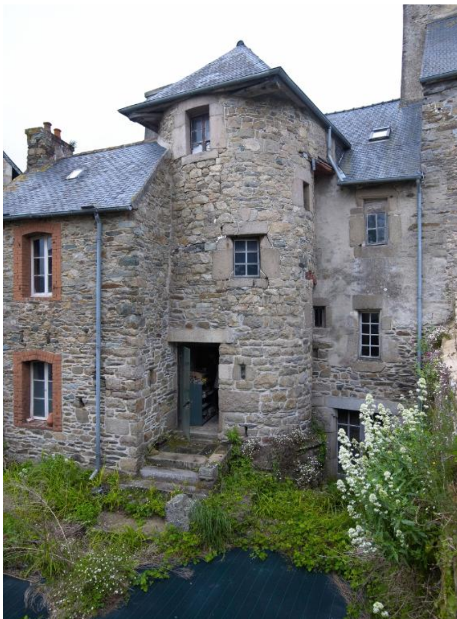
Façade arrière. Vue générale sud
