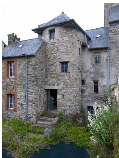
Façade arrière. Vue générale sud Phot. Bernard Bègne IVR53_20172200631NUCA
