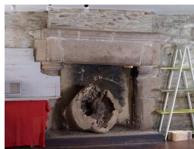
Rez-de-chaussée. Pignon est. Cheminée correspondant à la pièce arrière d'origine Phot. Bernard Bègne IVR53_20172200565NUCA
