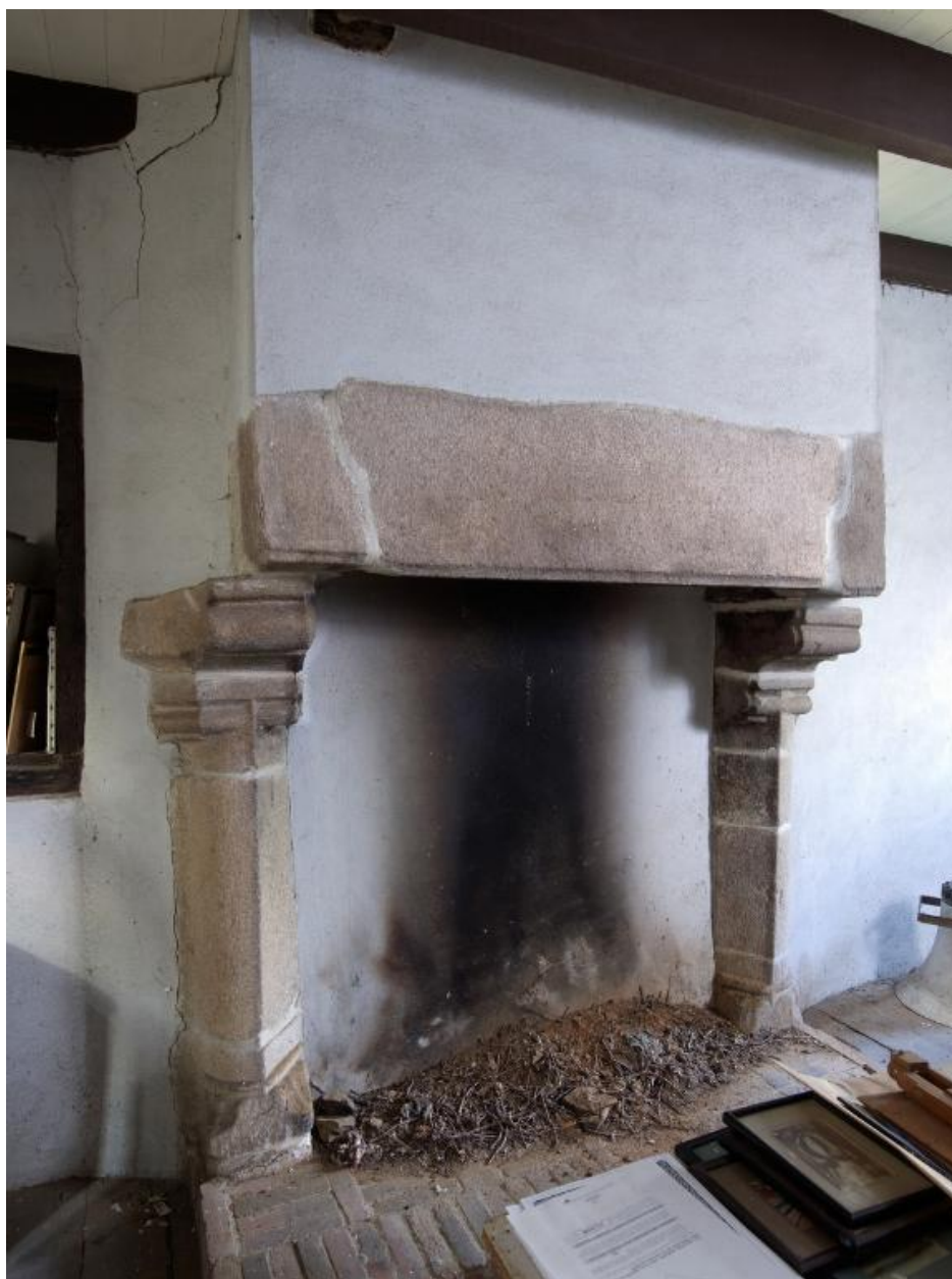
Premier étage. Chambre n°2. Cheminée du pignon est. Vue générale
