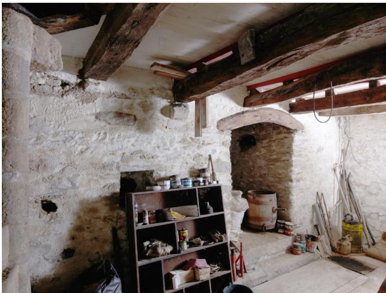
Sous-sol avec renforcement. Vue générale
