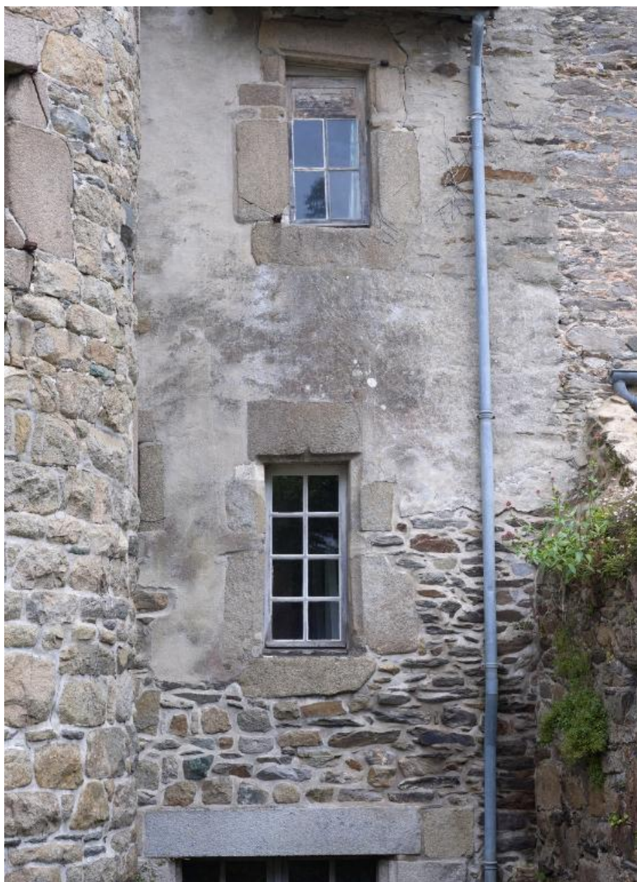
Façade arrière. Détail des baies du rez-de-chaussée et de l'étage
