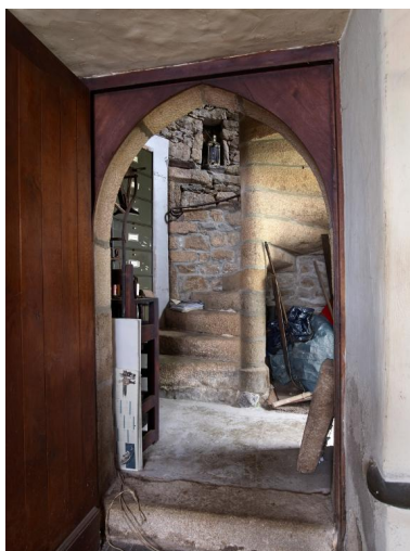
Tour d'escalier. Vue intérieure prise du rez-de-chaussée Phot. Bernard Bègne IVR53_20172200636NUCA
