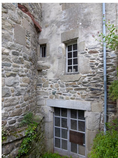
Façade arrière. Détail des baies du sous-sol et du rez-de-chaussée Phot. Bernard Bègne IVR53_20172200633NUCA
