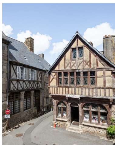
Vue générale sud-ouest Phot. Delia Gaulin-Crespel IVR53_20202200286NUCA
