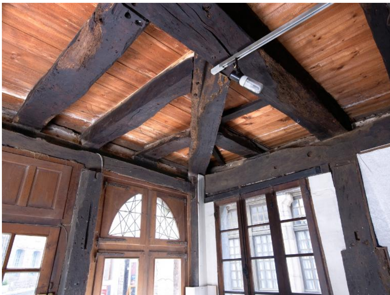
Rez-de-chaussée. Plafond. Détail de la poutraison d'angle avec le coyer
