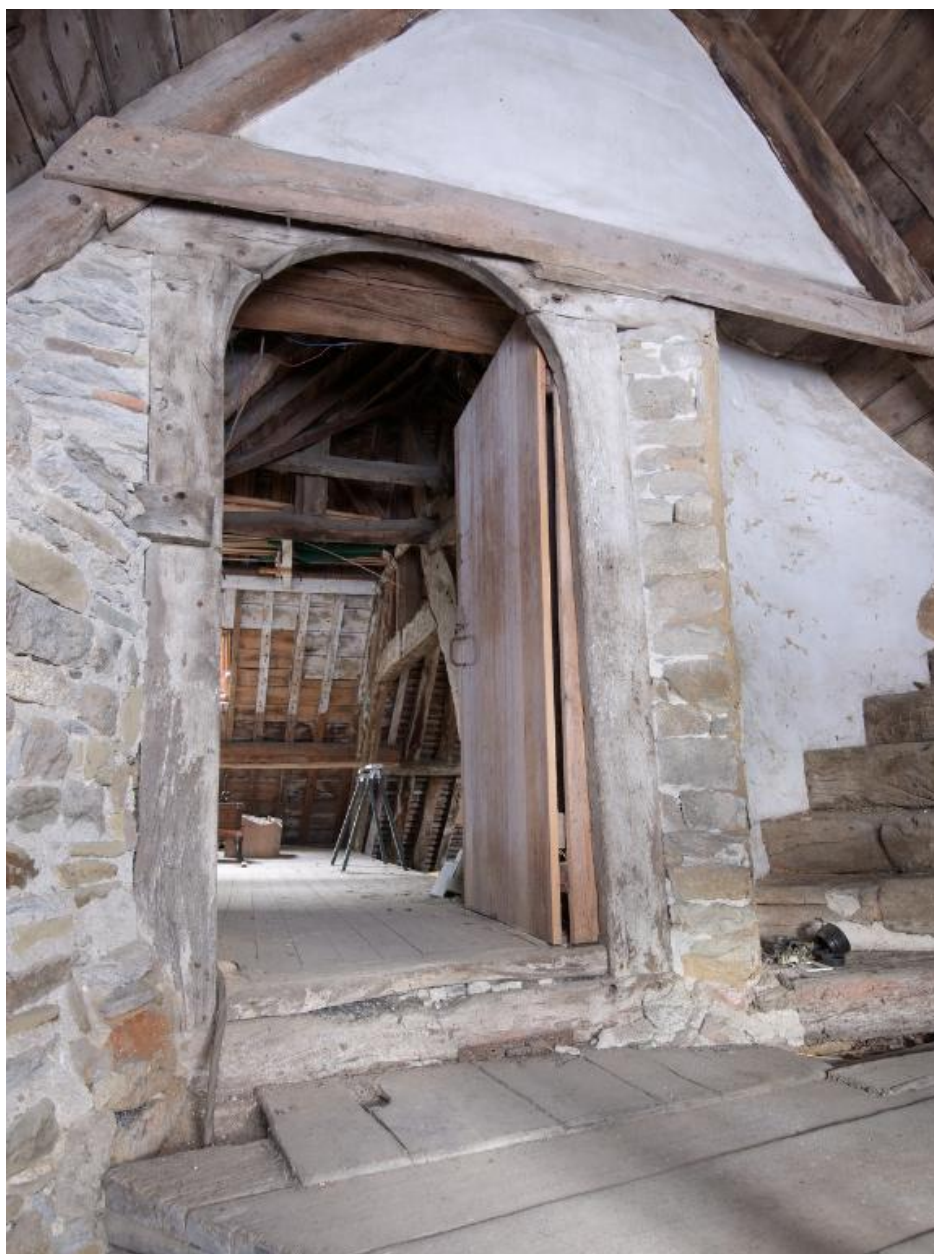
Tour d'escalier. Vue intérieure prise en haut de la tour. Détail de la porte palière ouvrant sur les combles
