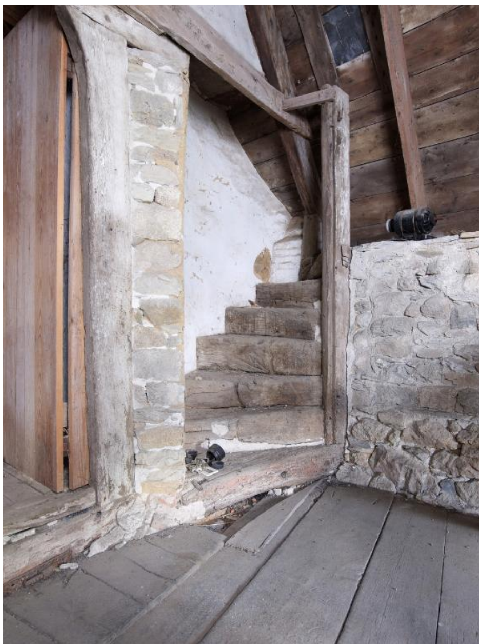
Tour d'escalier. Vue intérieure prise en haut de la tour. Détail de l'escalier en vis secondaire menant à la pièce haute disparue
