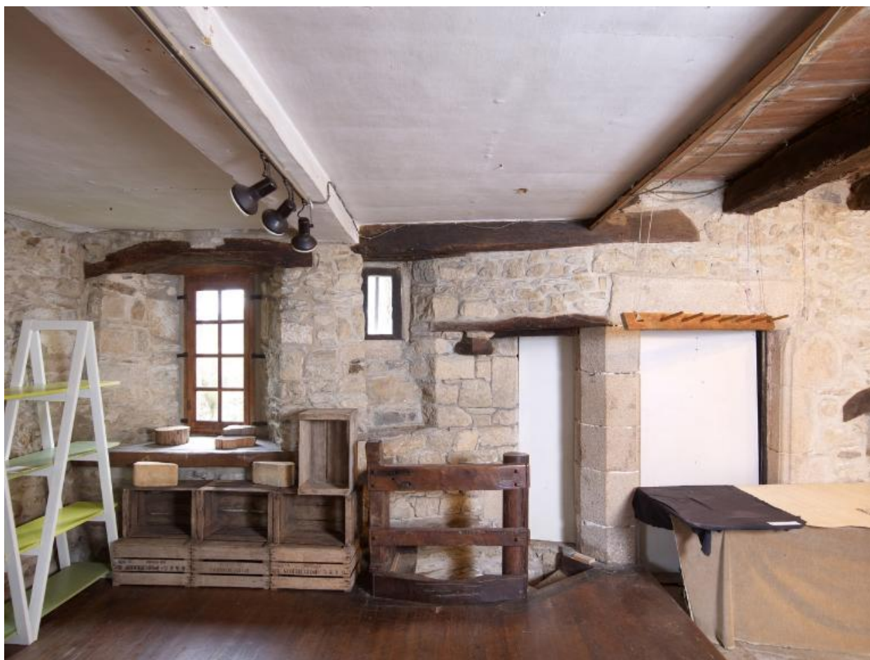
Rez-de-chaussée. Mur gouttereau sud. Portes jumelées ouvrant sur la tour d'escalier correspondant à la partition d'origine en deux pièces
