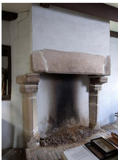
Premier étage. Chambre n°2. Cheminée du pignon est. Vue générale Phot. Bernard Bègne IVR53_20172200572NUCA
