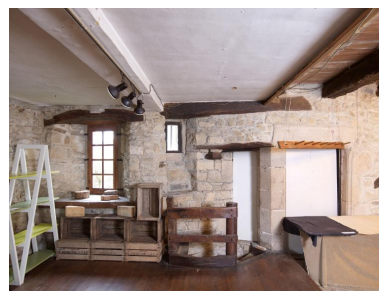
Rez-de-chaussée. Mur gouttereau sud. Portes jumelées ouvrant sur la tour d'escalier correspondant à la partition d'origine en deux pièces Phot. Bernard Bègne IVR53_20172200629NUCA
