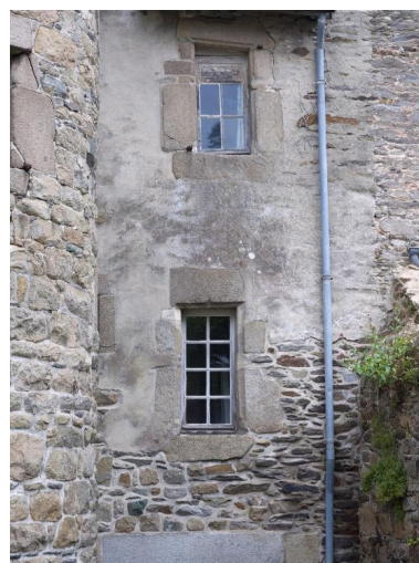
Façade arrière. Détail des baies du rez-de-chaussée et de l'étage Phot. Bernard Bègne
