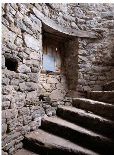
Tour d'escalier. Vue intérieure. Détail d'un jour et d'une niche à lumière Phot. Bernard Bègne IVR53_20172200639NUCA
