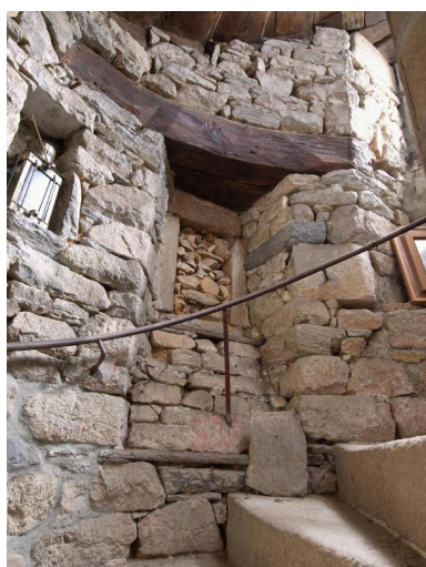
Tour d'escalier. Vue intérieure. Détail d'un jour bouché Phot. Bernard Bègne IVR53_20172200637NUCA
