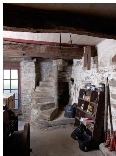
Tour d'escalier. Vue générale prise du sous-sol Phot. Bernard Bègne IVR53_20172200569NUCA
