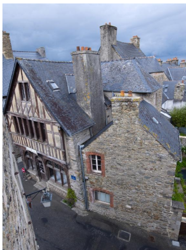
Vue générale sud-ouest Phot. Bernard Bègne IVR53_20172200652NUCA
