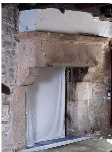
Rez-de-chaussée. Mur gouttereau sud. Cheminée correspondant à la pièce avant d'origine Phot. Bernard Bègne IVR53_20172200566NUCA
