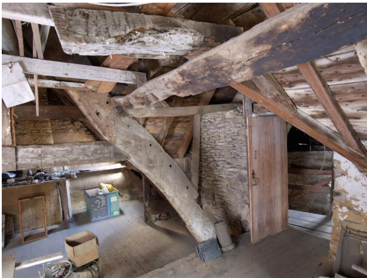
Combles. Vue partielle de la charpente
