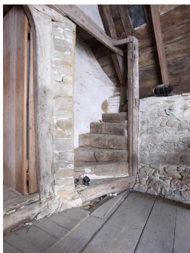
Tour d'escalier. Vue intérieure prise en haut de la tour. Détail de l'escalier en vis secondaire menant à la pièce haute disparue Phot. Bernard Bègne IVR53_20172200574NUCA
