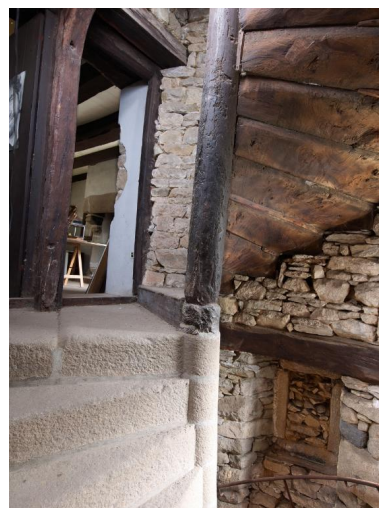
Tour d'escalier. Vue intérieure. Transition entre la partie en pierre et la partie en bois de la vis Phot. Bernard Bègne IVR53_20172200638NUCA
