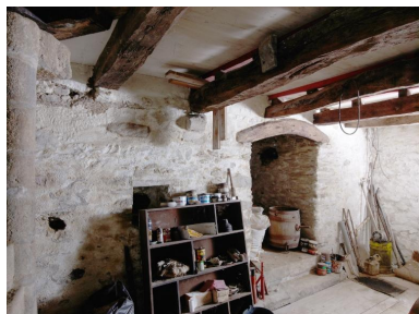
Sous-sol avec renforcement. Vue générale Phot. Bernard Bègne IVR53_20172200570NUCA
