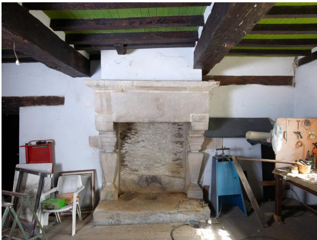
Premier étage. Chambre n°1. Cheminée sur mur gouttereau sud. Vue générale
