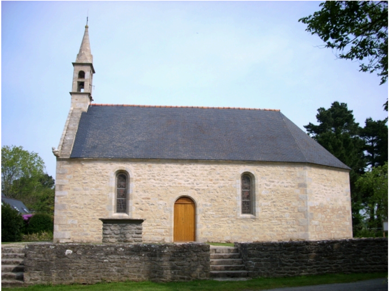
Plomeur, chapelle Saint-Côme et Saint-Damien : élévation sud
