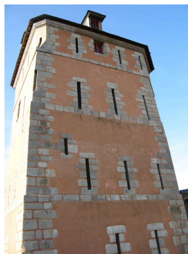
Face est de la Tour Vauban Phot. Guillaume Marie IVR53_20082908259NUCA
