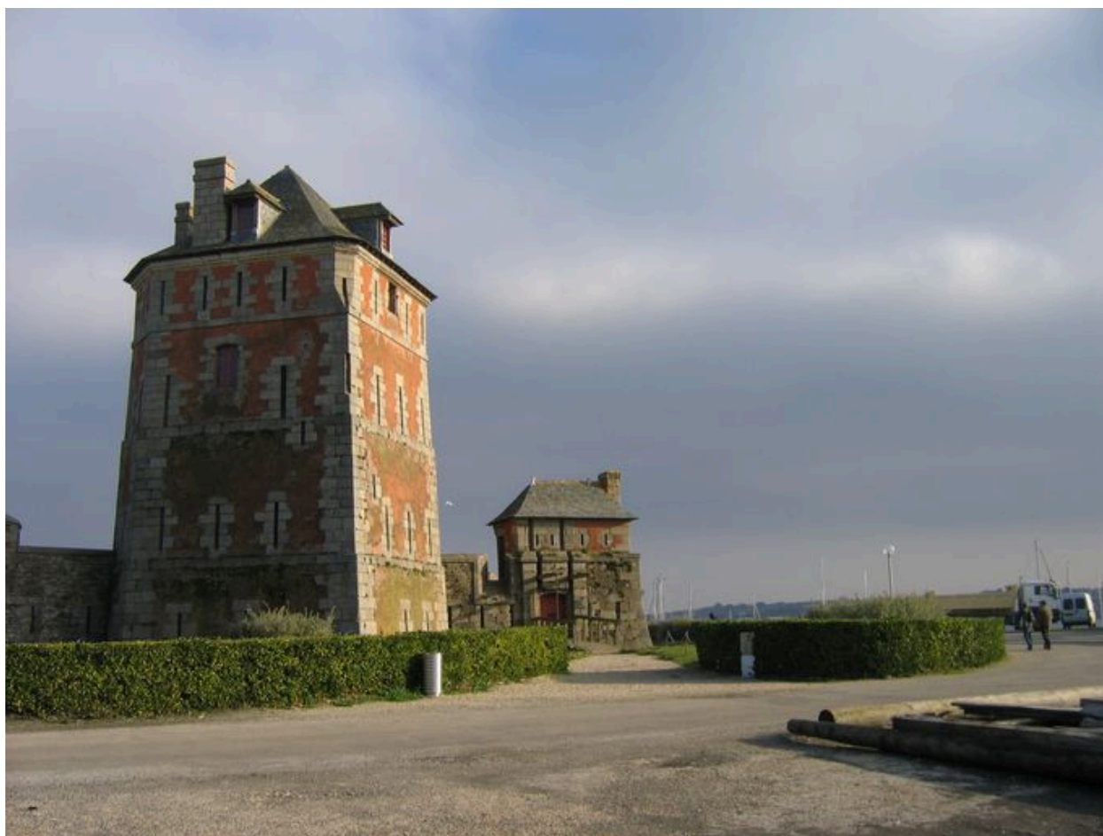
Vue de la Tour Vauban avant restauration
