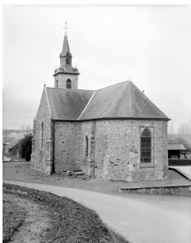
Etat en 1994, élévation Est : vue générale Phot. Guy Artur, Phot. Norbert Lambart IVR53_19943500723X
