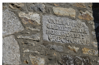
Façade Sud, détail, inscription Phot. Norbert Lambart IVR53_20063500536NUCA
