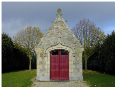
Vue générale sud Phot. Xavier Gilbert IVR53_20023517961NUCA
