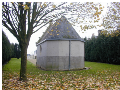
Vue générale nord-est Phot. Xavier Gilbert IVR53_20023517963NUCA
