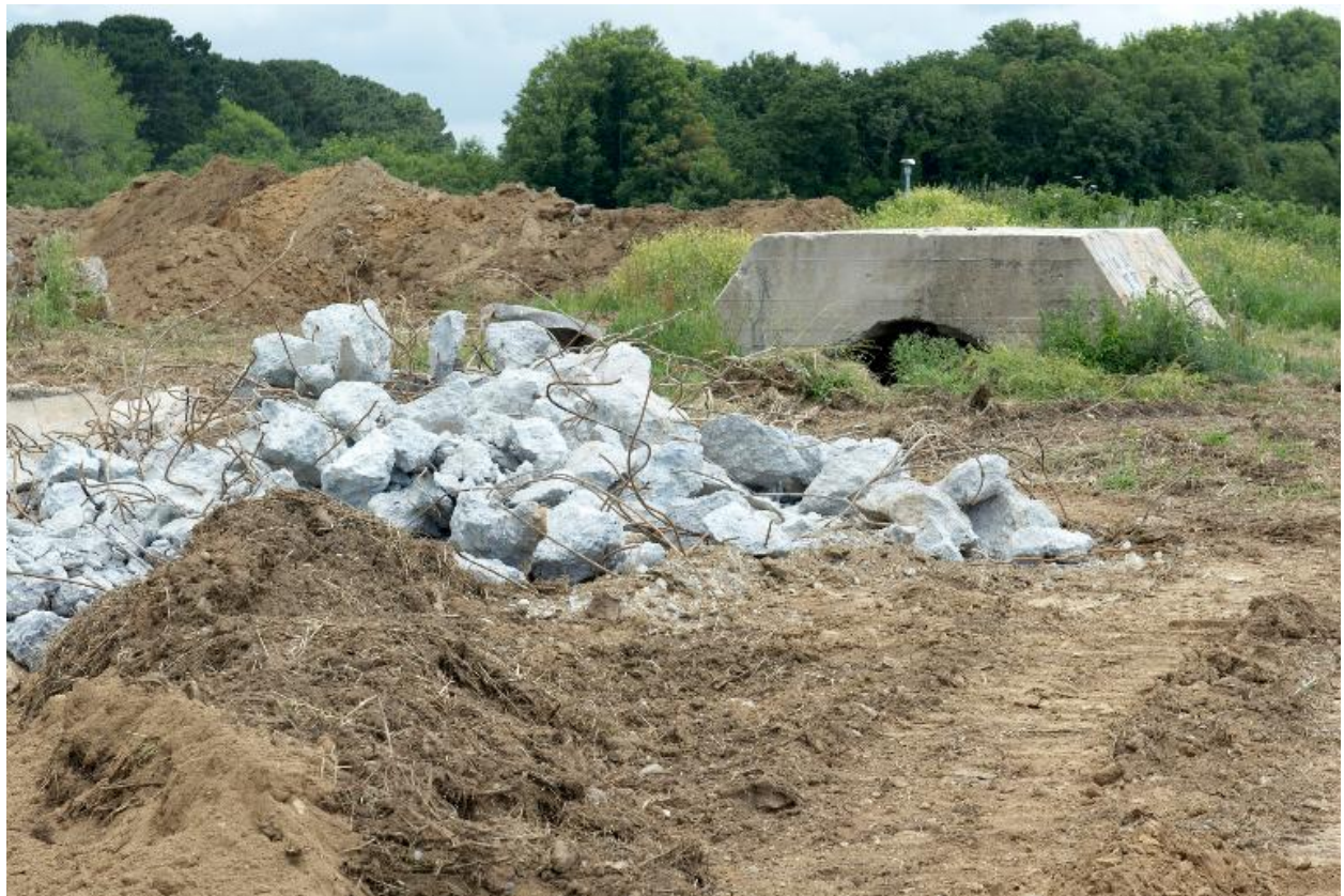
Résultat de la déconstruction d'un bunker après le tri : morceaux de béton. A l'arrière plan, bunker de type tôle métro (Heinrich Wellblech)
