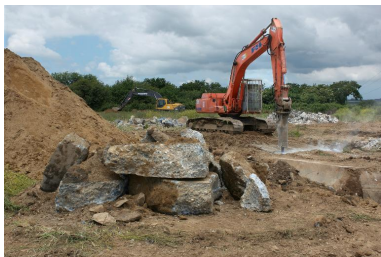
Déconstruction d'un bunker de type 502
