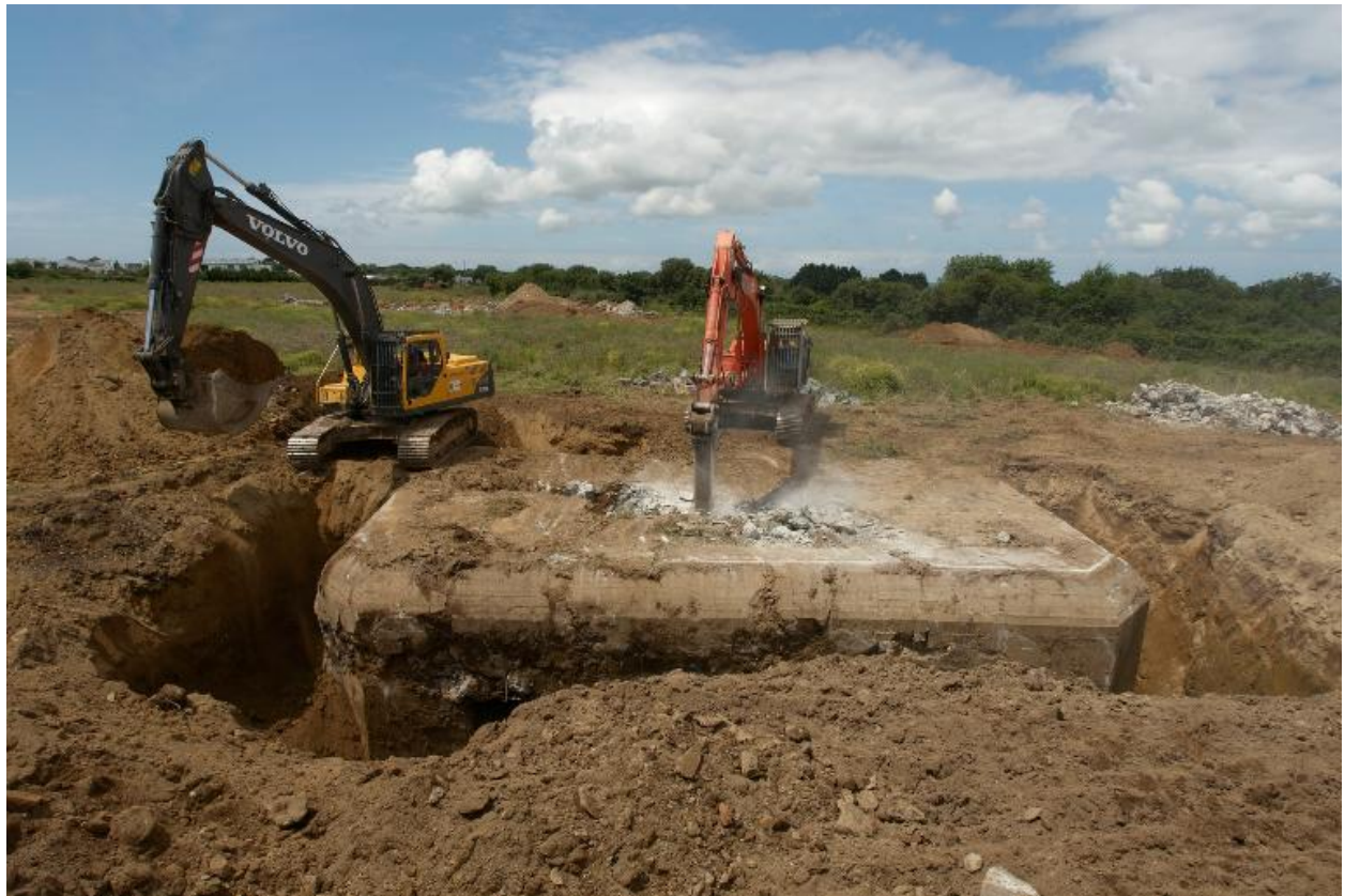
Déconstruction d'un bunker de type 502
