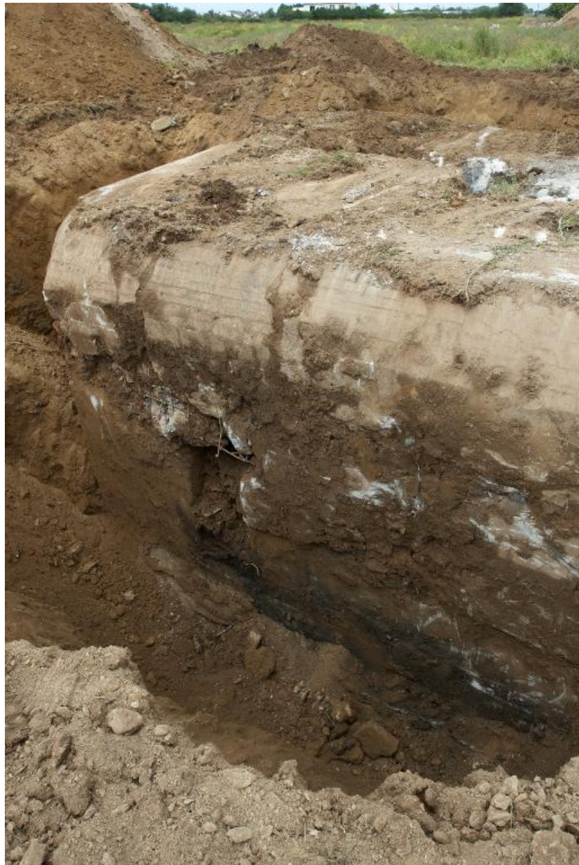
Déconstruction d'un bunker de type 502
