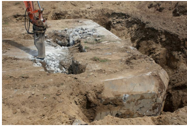
Déconstruction d'un bunker de type 502 Phot. Bernard Bègne IVR53_20122901036NUCA
