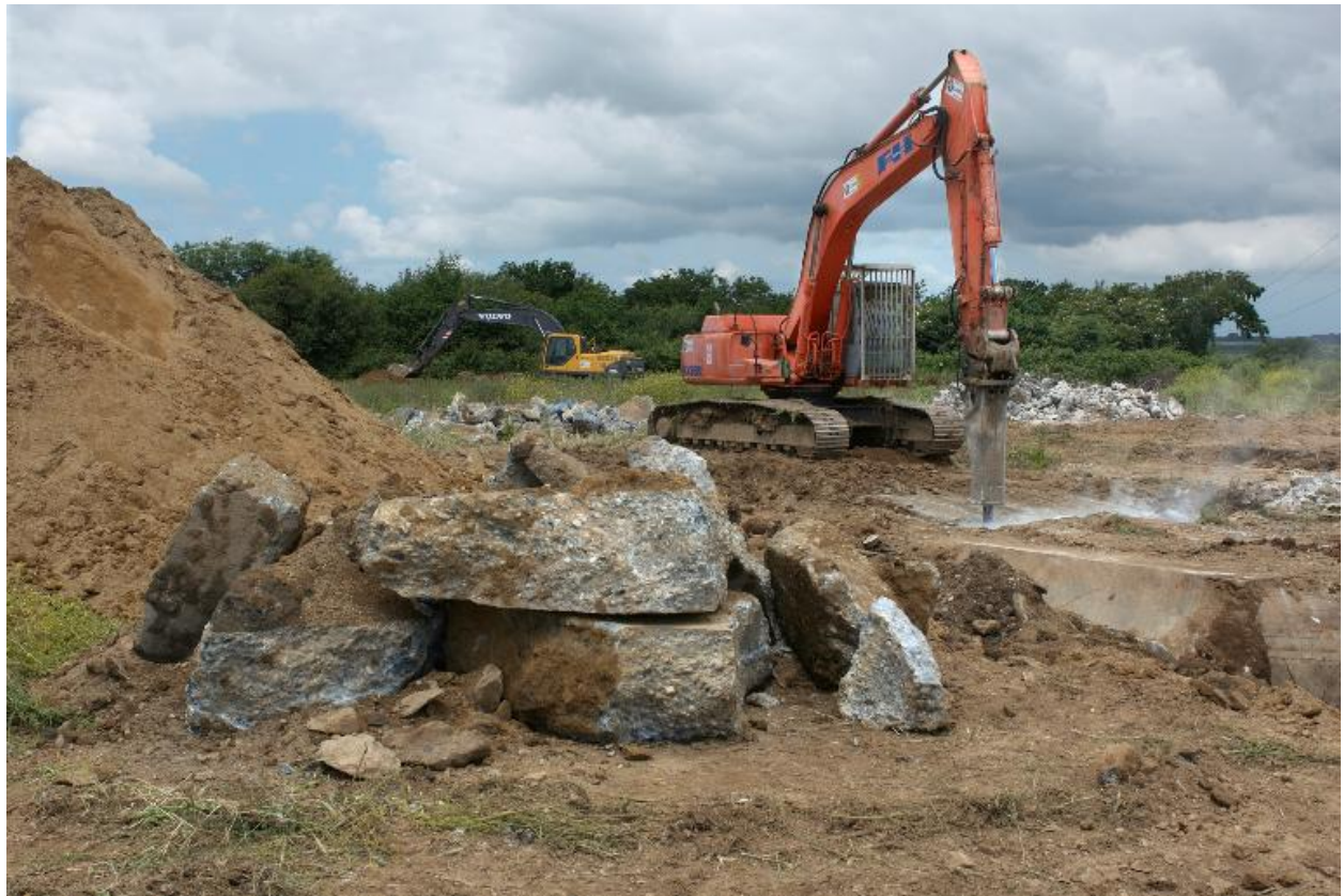
Déconstruction d'un bunker de type 502
