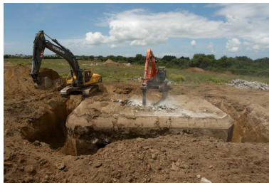
Déconstruction d'un bunker de type 502 Phot. Bernard Bègne IVR53_20122901040NUCA
