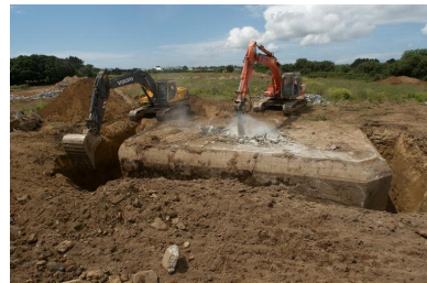
Déconstruction d'un bunker de type 502 Phot. Bernard Bègne IVR53_20122901041NUCA
