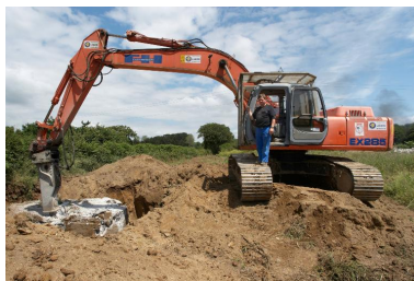
Déconstruction d'un petit bunker - poste d'observation et de tir dit Tobruk-Stand de type 61a. Le conducteur pose pour le photographe Phot. Bernard Bègne IVR53_20122901047NUCA
