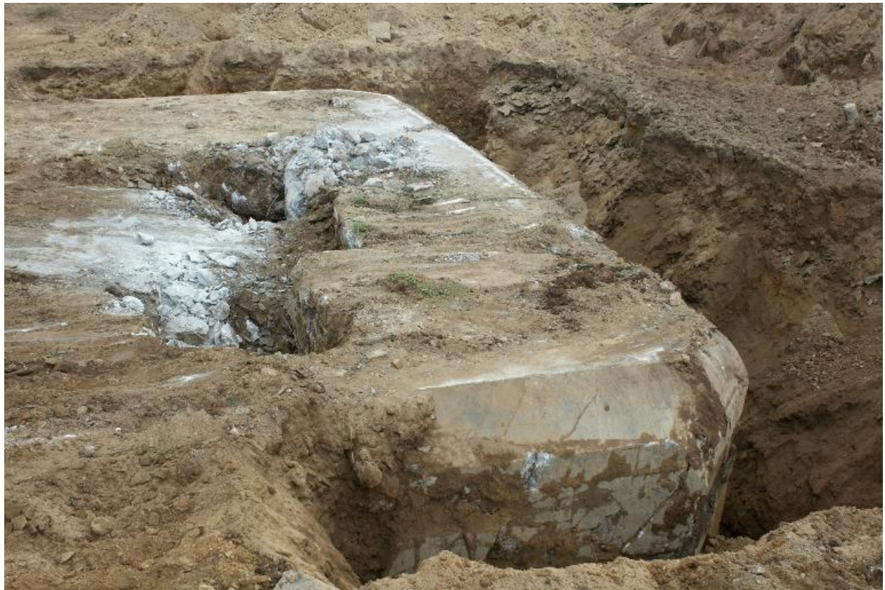
Déconstruction d'un bunker de type 502
