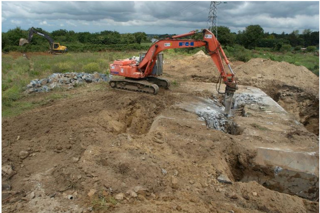
Déconstruction d'un bunker de type 502
