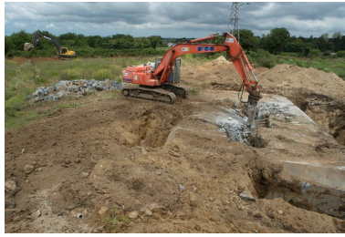
Déconstruction d'un bunker de type 502 Phot. Bernard Bègne IVR53_20122901037NUCA
