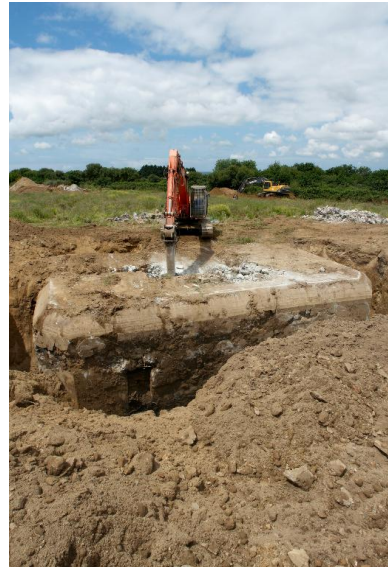
Déconstruction d'un bunker de type 502 Phot. Bernard Bègne IVR53_20122901038NUCA
