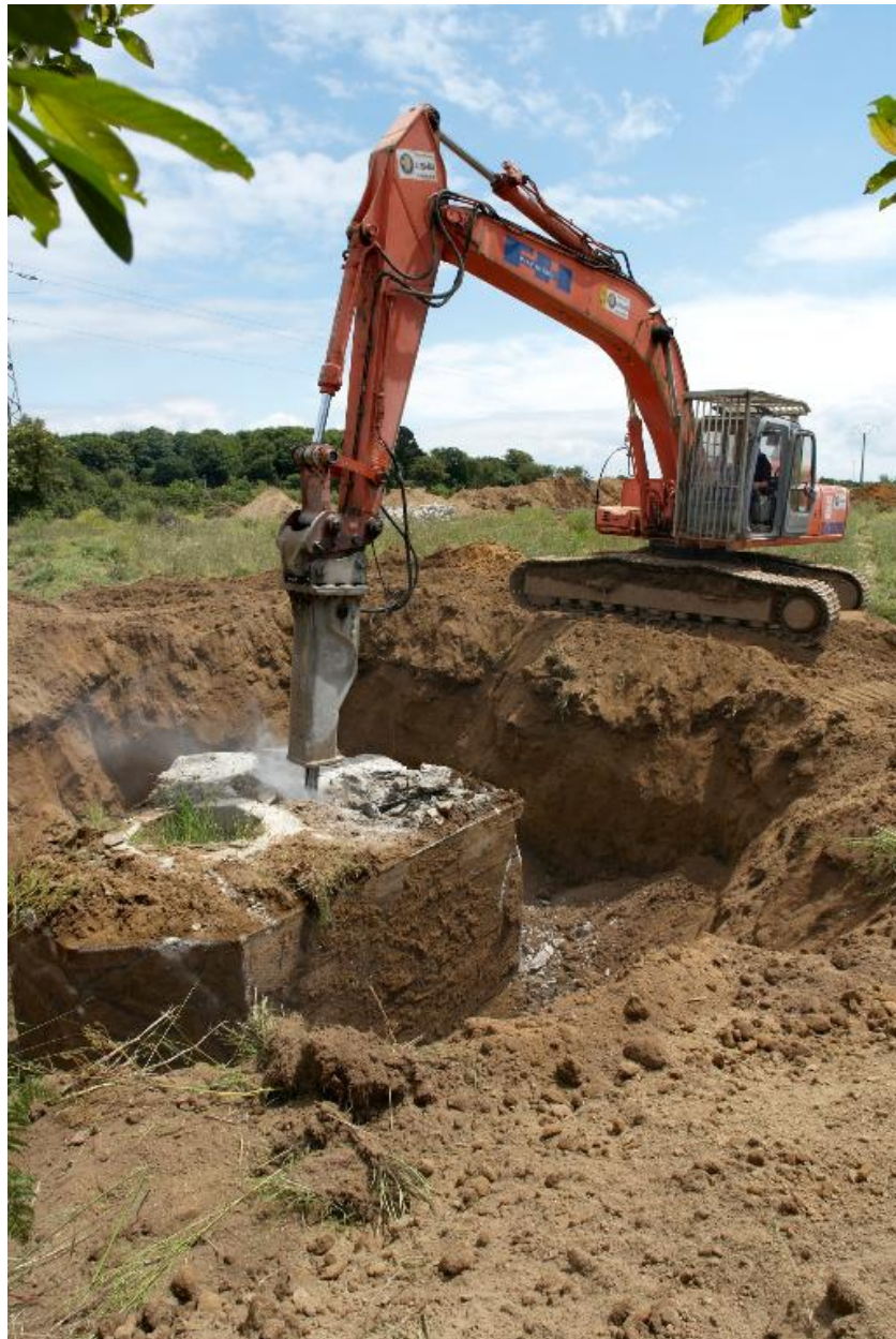
Déconstruction d'un petit bunker - poste d'observation et de tir dit Tobruk-Stand de type 61a. Le conducteur pose pour le photographe
