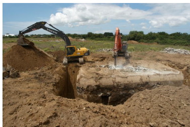
Déconstruction d'un bunker de type 502 Phot. Bernard Bègne IVR53_20122901043NUCA
