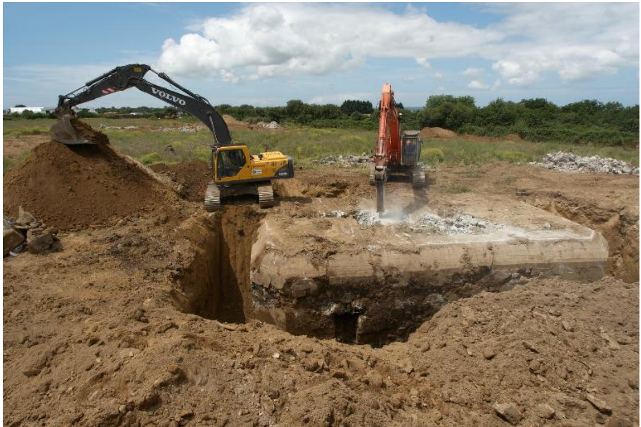
Déconstruction d'un bunker de type 502
