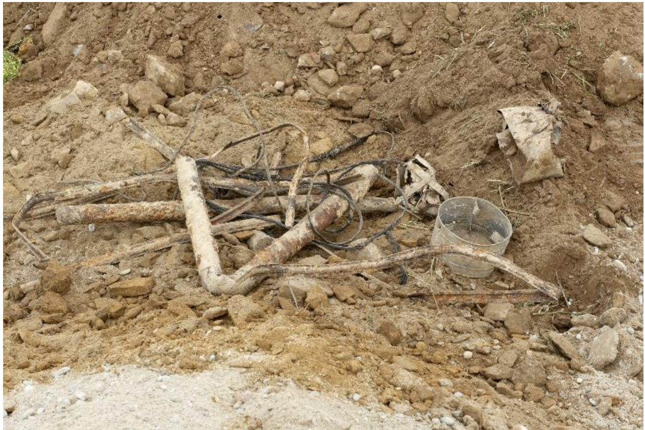
Vestiges métalliques (tuyaux et câbles...) découverts lors de la déconstruction des bunkers
