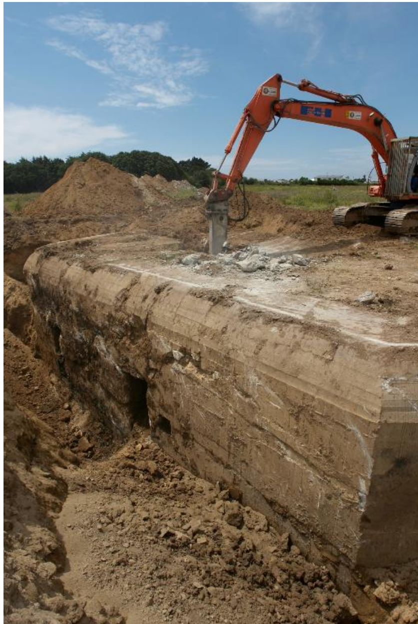
Déconstruction d'un bunker de type 502
