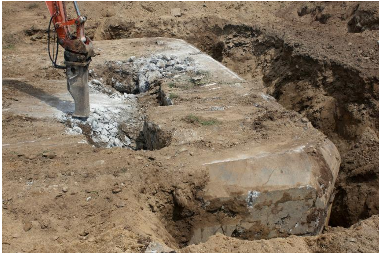
Déconstruction d'un bunker de type 502
