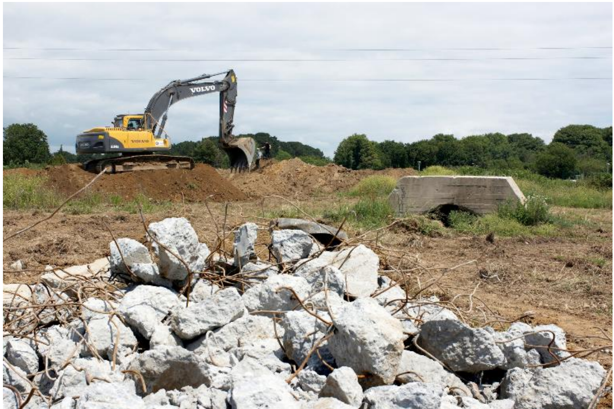
Déconstruction des bunkers. Au premier plan, des morceaux de béton avant le tri. Au second plan, bunker de type tôle métro (Wellblech)
