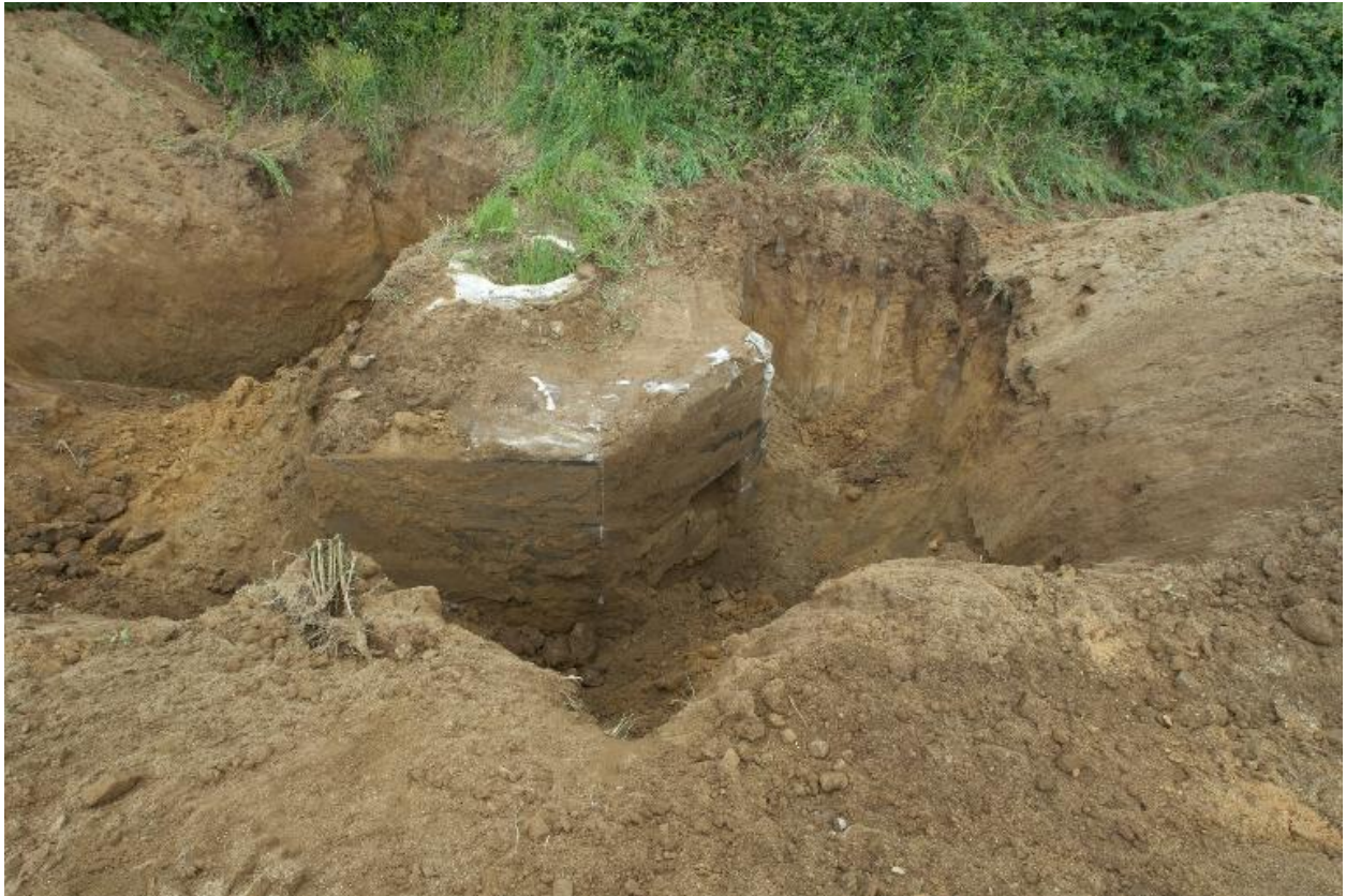
Dégagement de la terre avant la déconstruction d'un petit bunker - poste d'observation et de tir dit Tobruk-Stand de type 61a
