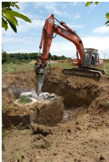
Déconstruction d'un petit bunker - poste d'observation et de tir dit Tobruk-Stand de type 61a. Le conducteur pose pour le photographe Phot. Bernard Bègne IVR53_20122901046NUCA
