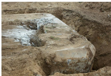
Déconstruction d'un bunker de type 502 Phot. Bernard Bègne IVR53_20122901010NUCA
