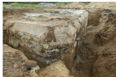
Déconstruction d'un bunker de type 502 Phot. Bernard Bègne IVR53_20122901016NUCA
