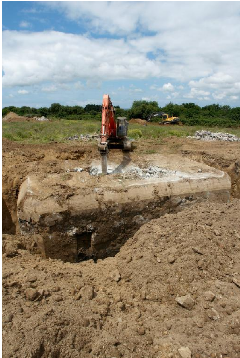
Déconstruction d'un bunker de type 502
