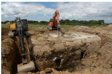
Déconstruction d'un bunker de type 502 Phot. Bernard Bègne IVR53_20122901042NUCA
