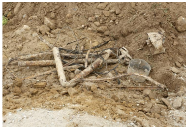
Vestiges métalliques (tuyaux et câbles...) découverts lors de la déconstruction des bunkers Phot. Bernard Bègne IVR53_20122901011NUCA
