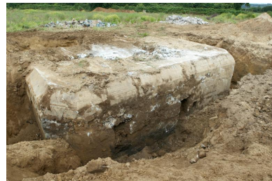
Déconstruction d'un bunker de type 502 Phot. Bernard Bègne IVR53_20122901017NUCA
