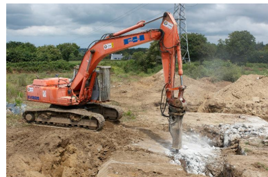
Déconstruction d'un bunker de type 502
