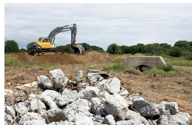
Déconstruction des bunkers. Au premier plan, des morceaux de béton avant le tri. Au second plan, bunker de type tôle métro (Wellblech) Phot. Bernard Bègne IVR53_20122901045NUCA
