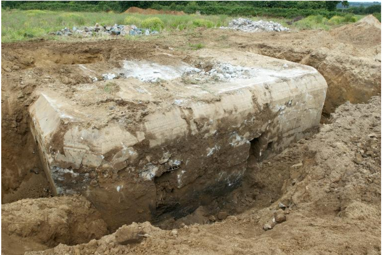
Déconstruction d'un bunker de type 502
