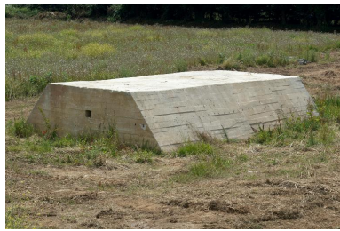
Bunker de type tôle métro (Heinrich Wellblech) Phot. Bernard Bègne IVR53_20122901044NUCA
