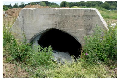
Bunker de type tôle métro (Heinrich Wellblech) Phot. Bernard Bègne IVR53_20122901032NUCA
