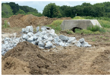
Résultat de la déconstruction d'un bunker après le tri : morceaux de béton. A l'arrière plan, bunker de type tôle métro (Heinrich Wellblech) Phot. Bernard Bègne IVR53_20122901031NUCA
