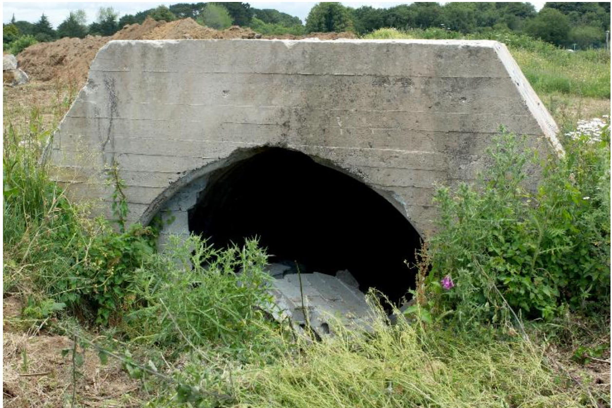
Bunker de type tôle métro (Heinrich Wellblech)
