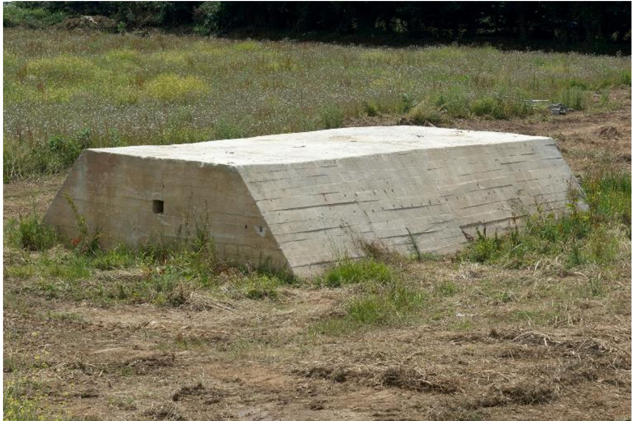
Bunker de type tôle métro (Heinrich Wellblech)
