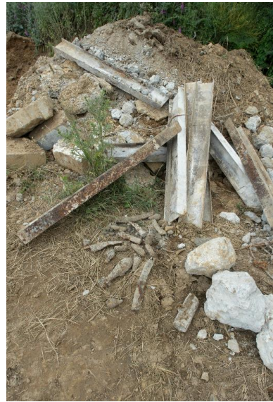
Vestiges métalliques et matériels pyrotechniques (projectiles de différents types...) découverts lors de la déconstruction des bunkers Phot. Bernard Bègne IVR53_20122901023NUCA
