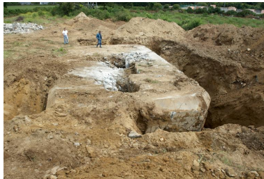
Déconstruction d'un bunker de type 502 Phot. Bernard Bègne IVR53_20122901021NUCA
