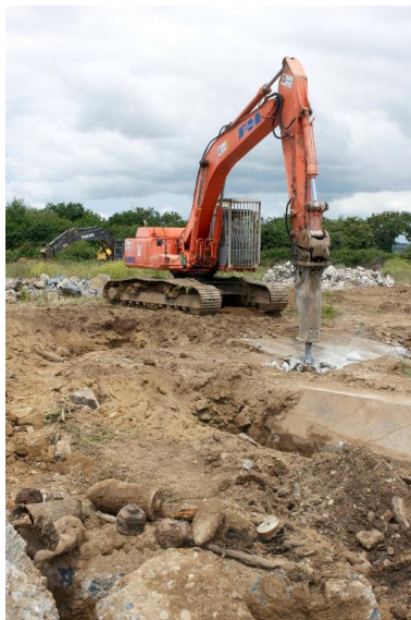
Déconstruction d'un bunker de type 502. Au premier plan, objets et matériels pyrotechniques (cartouches de masque à gaz, étuis, projectiles de différents types...)
