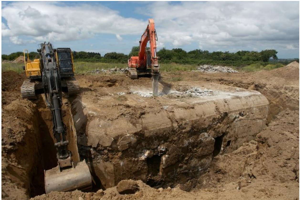
Déconstruction d'un bunker de type 502
