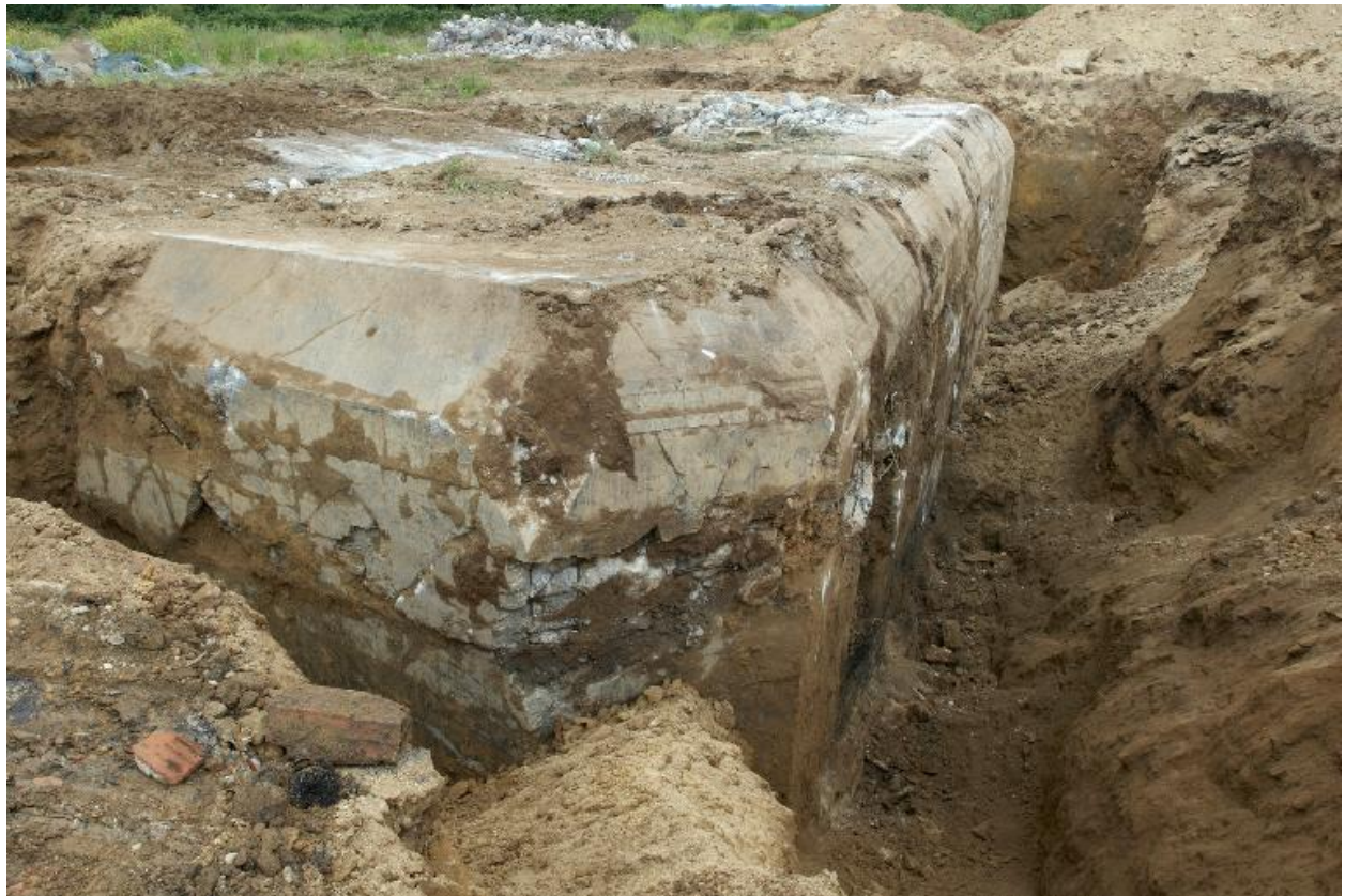
Déconstruction d'un bunker de type 502
