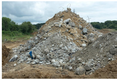
Résultat de la déconstruction d'un bunker avant le tri : éclats de béton et morceaux de fer à béton Phot. Bernard Bègne IVR53_20122901028NUCA
