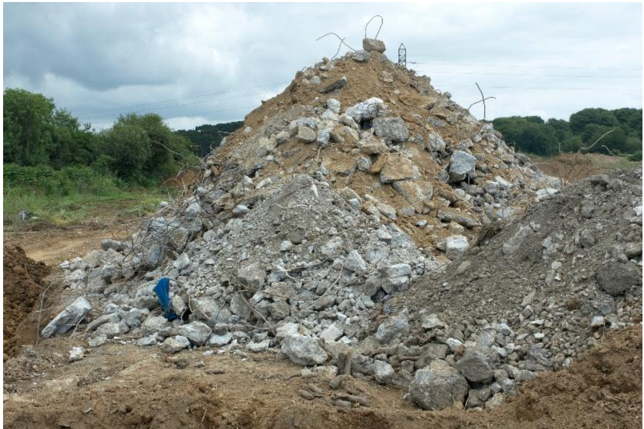
Résultat de la déconstruction d'un bunker avant le tri : éclats de béton et morceaux de fer à béton
