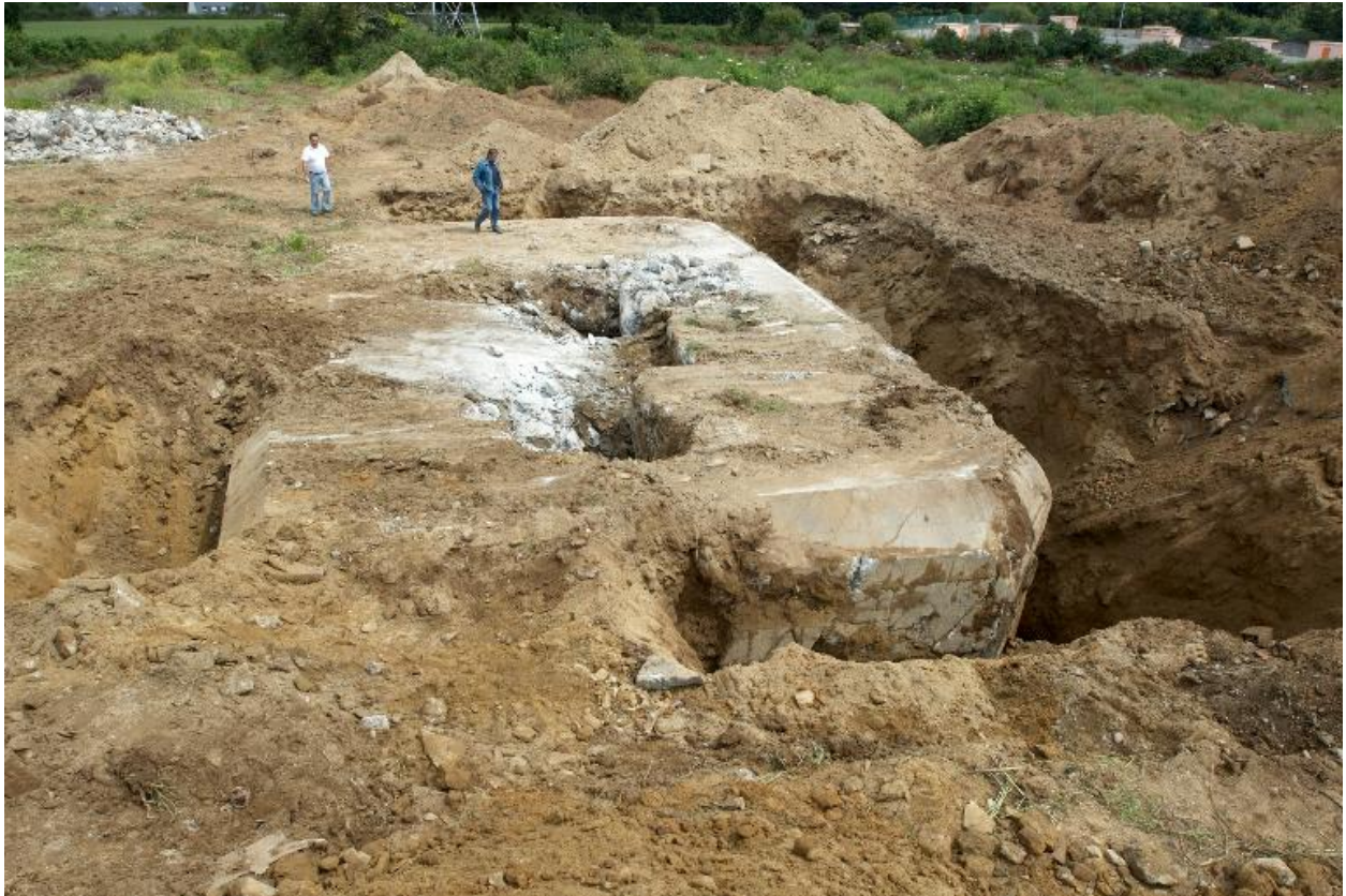
Déconstruction d'un bunker de type 502
