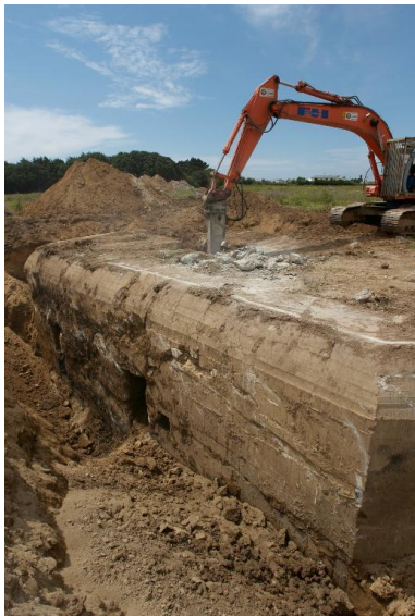
Déconstruction d'un bunker de type 502 Phot. Bernard Bègne IVR53_20122901039NUCA
