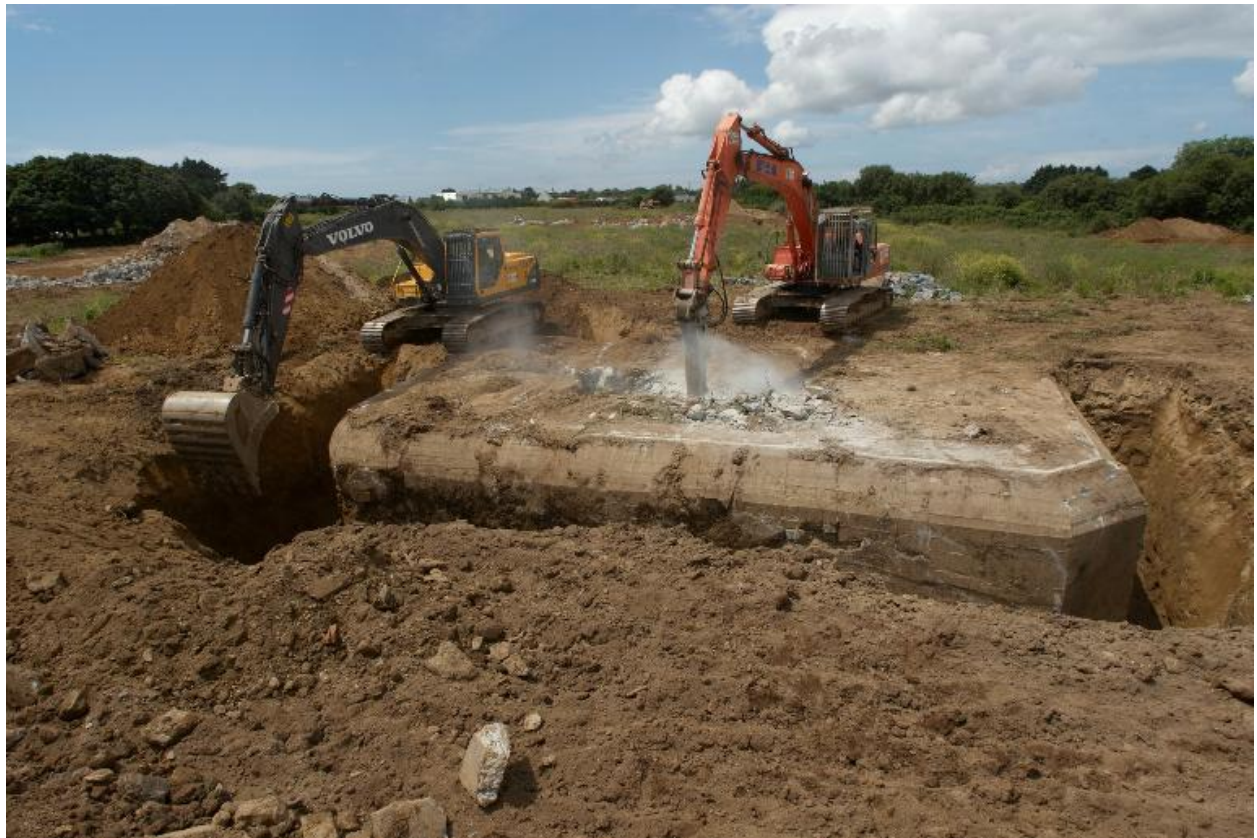
Déconstruction d'un bunker de type 502
