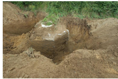
Dégagement de la terre avant la déconstruction d'un petit bunker - poste d'observation et de tir dit Tobruk-Stand de type 61a Phot. Bernard Bègne IVR53_20122901022NUCA
