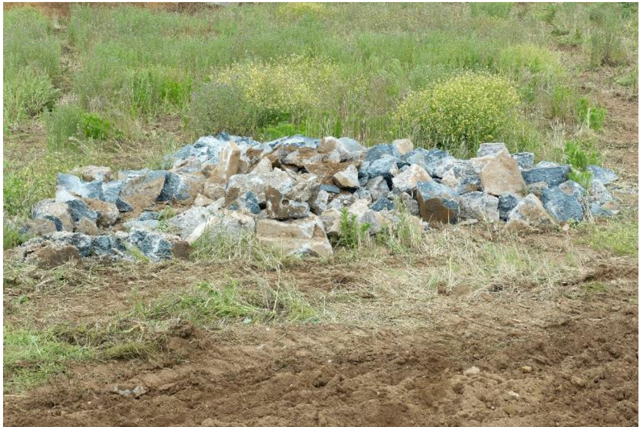
Résultat de la déconstruction d'un bunker après le tri : morceaux de béton
