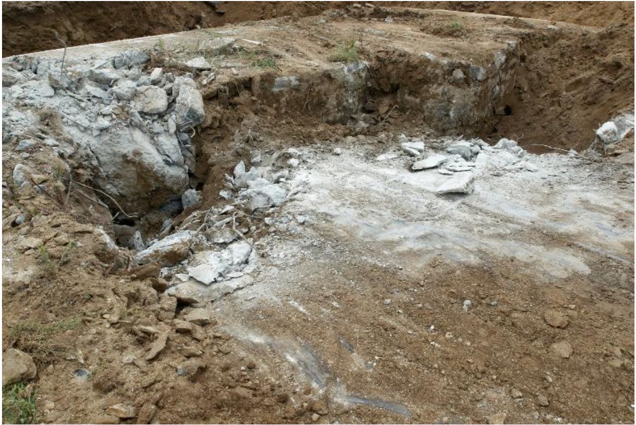
Déconstruction d'un bunker de type 502
