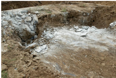
Déconstruction d'un bunker de type 502 Phot. Bernard Bègne IVR53_20122901019NUCA
