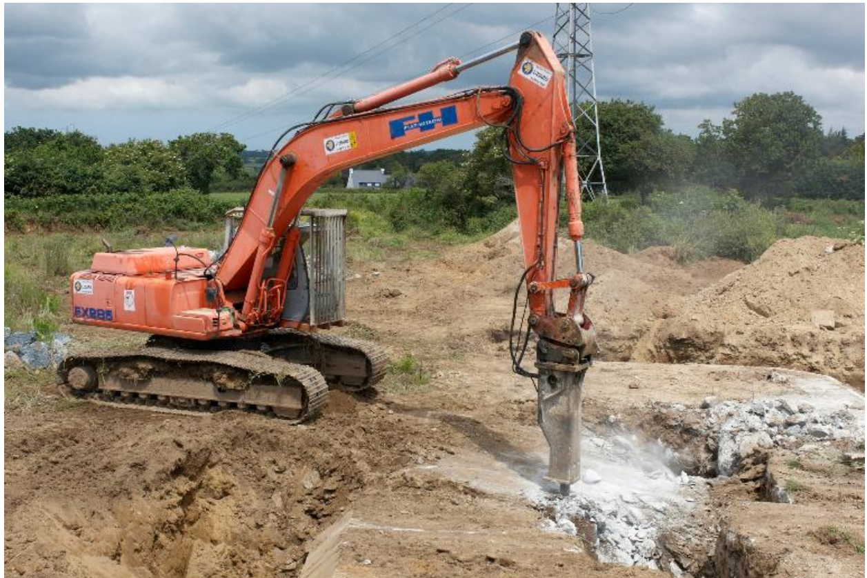
Déconstruction d'un bunker de type 502
