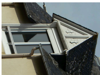
Lucarne pendante avec hermines sur le fronton Phot. Johan Vincent IVR53_20072909074NUCA
