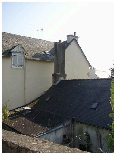
Façade arrière de la Villa 19 boulevard de la Laïta Phot. Johan Vincent IVR53_20062908697NUCA
