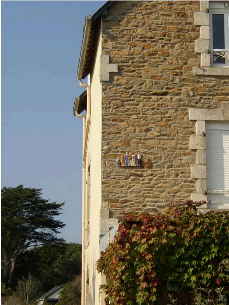
Elément décoratif du pignon formant façade
