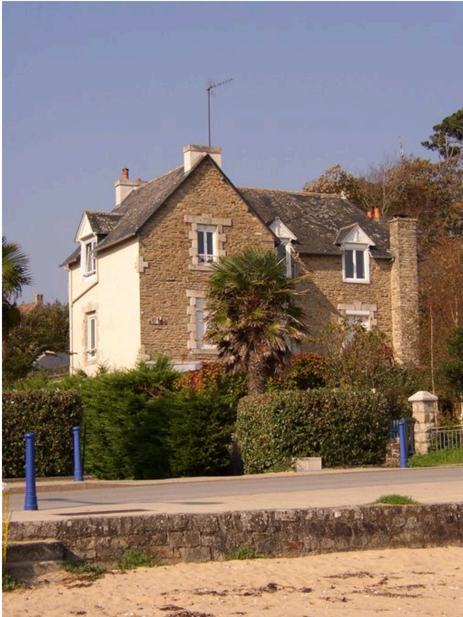
Vue générale de la villa 19 boulevard de la Laïta
