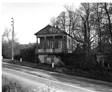
Le tempietto : vue générale nord-ouest Phot. Guy Artur, Phot. Norbert Lambart IVR53_19753500374X
