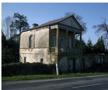
Le tempietto : vue générale nord-est Phot. Guy Artur, Phot. Norbert Lambart IVR53_20003500795XA
