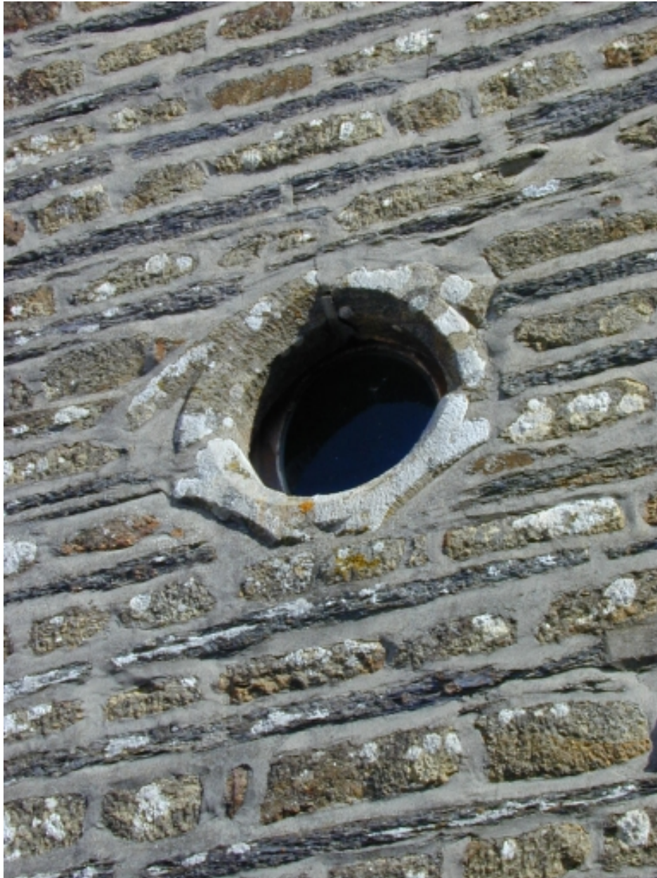
Mur sud, détail, oculus formé de remploi de fenestragés anciens
