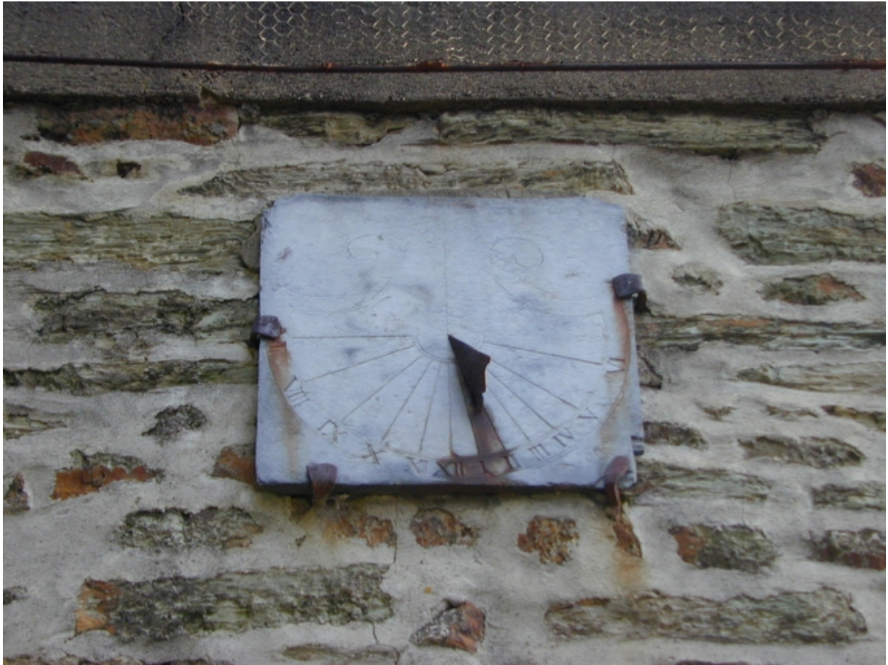
Cadran solaire au bras sud du transept
