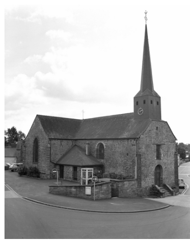
Vue générale nord-ouest Phot. Guy Artur, Phot. Norbert Lambart IVR53_20003503312X
