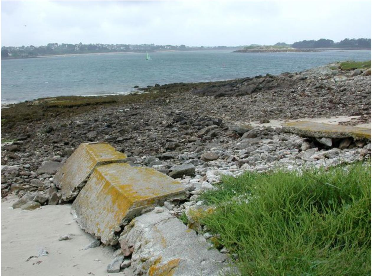
Vue de la cale faisant slipway qui permettait la mise à l'eau des hydravions (état en 2002). Elle est ruiniforme
