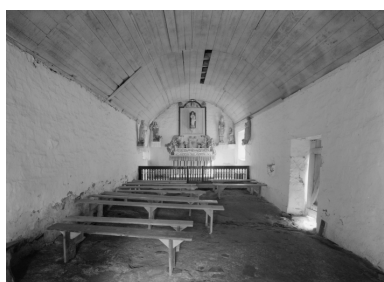
Poullaouen, chapelle Notre-Dame-du-Paradis : vue générale vers l'est, état en 1965 Phot. Auteur inconnu IVR53_19652900529V
