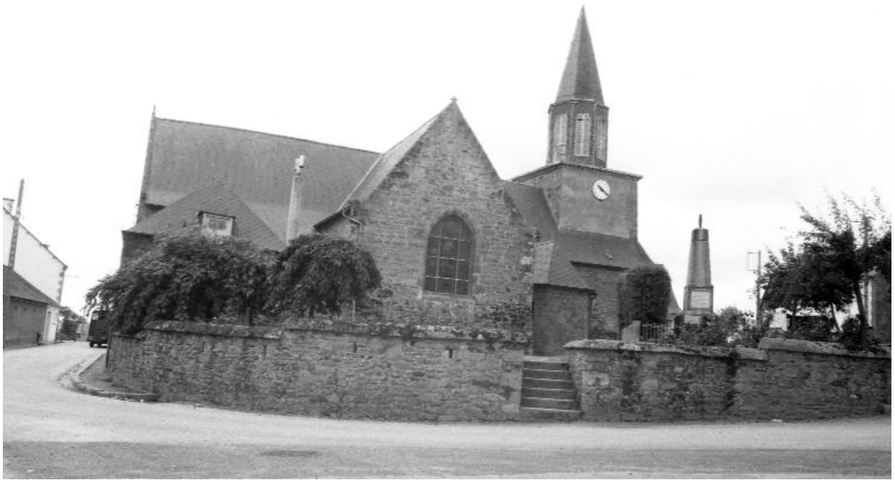
Vue d'ensemble de la façade nord
