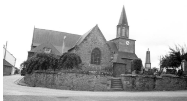
Vue d'ensemble de la façade nord
