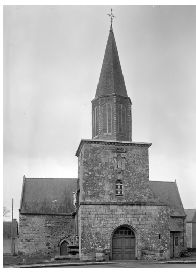
Vue d'ensemble de la façade ouest Phot. Brachet IVR53_19665601145V
