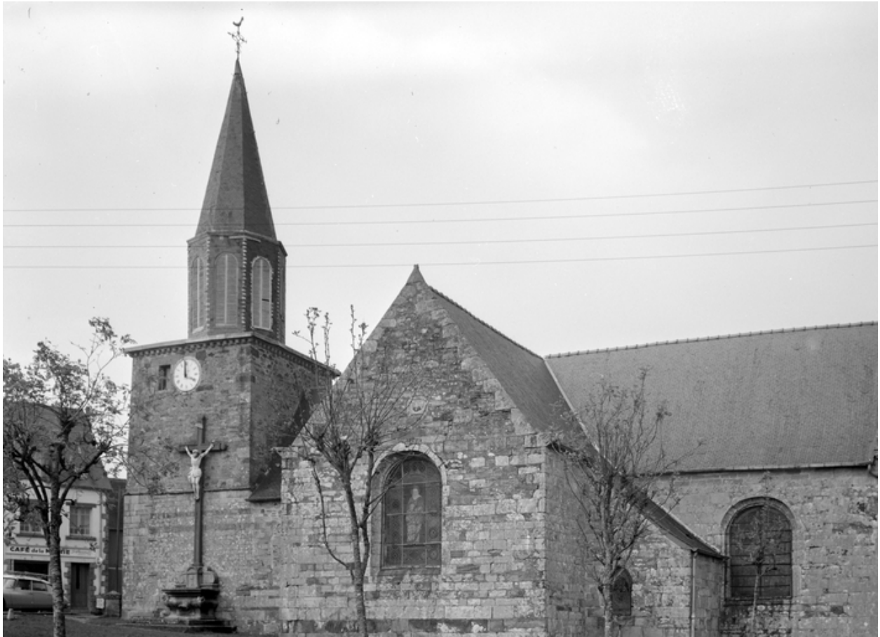
Vue d'ensemble de la façade nord
