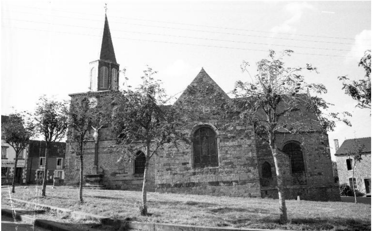
Vue d'ensemble de la façade sud
