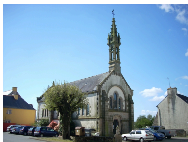
Querrien, chapelle Saint-Joseph : vue générale nord-ouest Phot. Gwénaél Fauchille IVR53_20082905705NUCA
