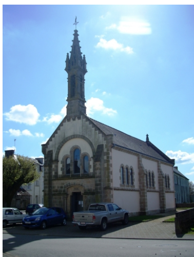
Querrien, chapelle Saint-Joseph : vue générale sud-ouest Phot. Gwénaél Fauchille IVR53_20082905706NUCA
