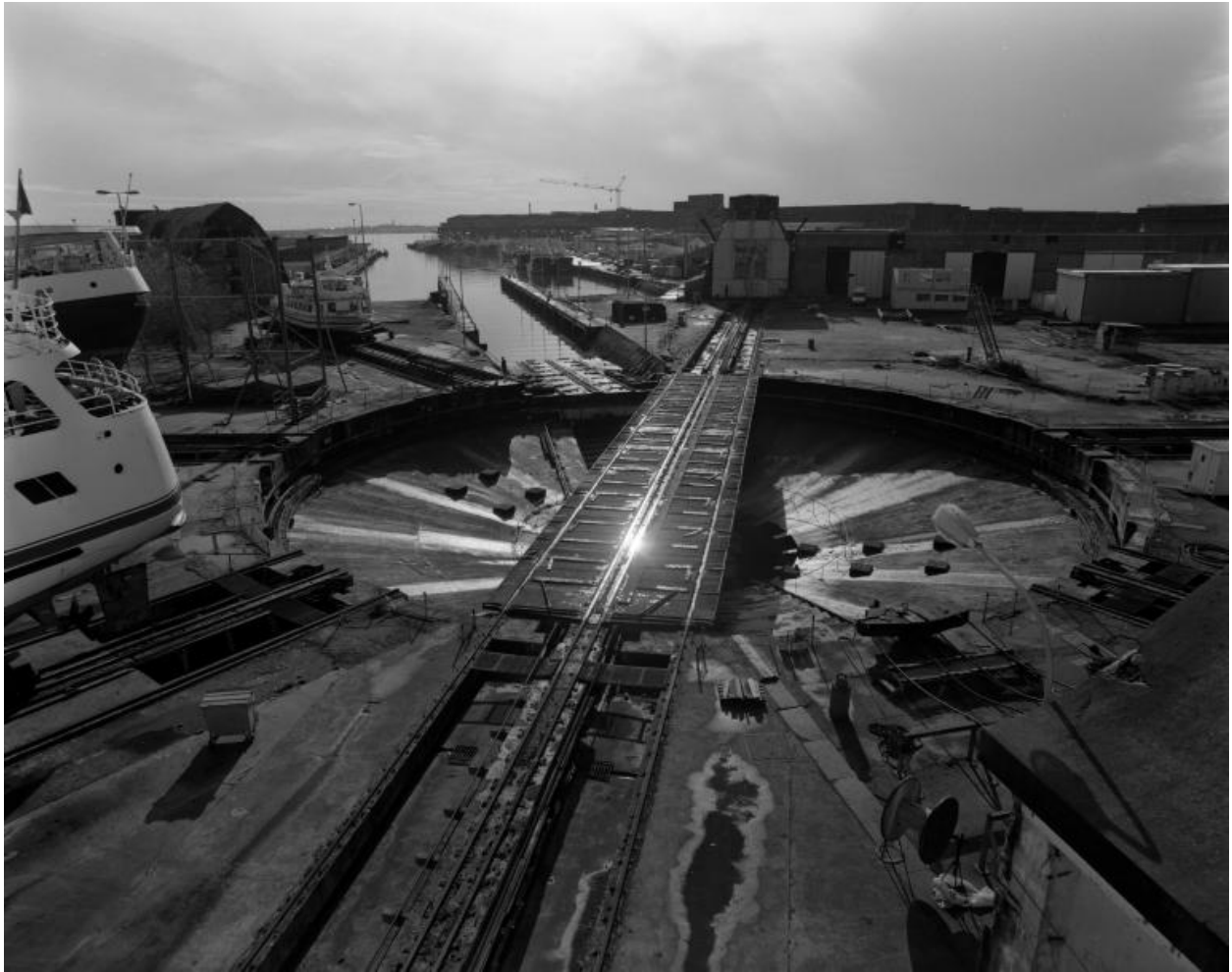
Vue générale de l'aire de réparation navale en 2000. Au centre, le slipway avec son pont basculant et tournant. De part et d'autre de la cale du slipway, les deux dom-bunkers
