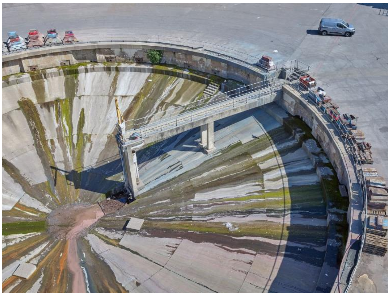
Vue de la fosse du slipway depuis le sommet de l'élévateur à bateaux
