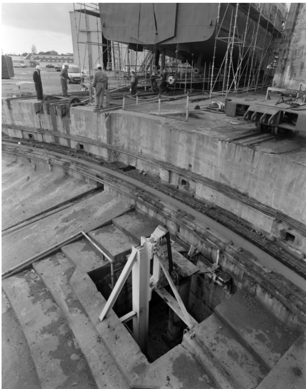
Vue de détail du pont basculant et tournant en 2000 : vérins, levage nord (?)
