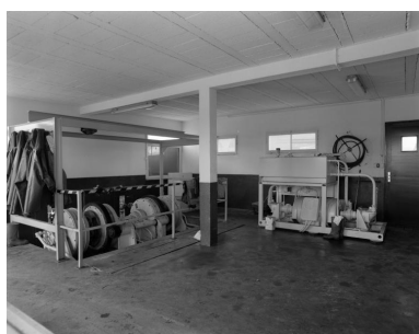
Vue du treuil de hissage de la quatrième ligne de réparation en 2000. Il s'agissait d'un treuil à chaîne à deux tambours Phot. Bernard Bègne IVR53_20005600547X
