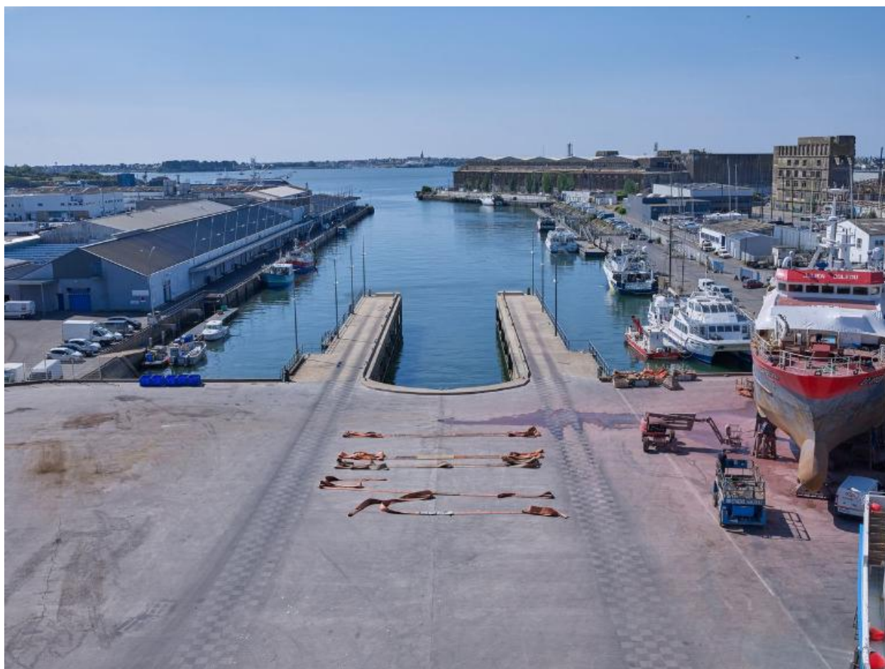
Vue du quai depuis le sommet de l'élévateur à bateau
