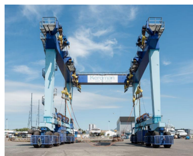
Vue de l'élévateur à bateaux d'une capacité de 650 tonnes Phot. Charlotte Barraud IVR53_20215600569NUCA
