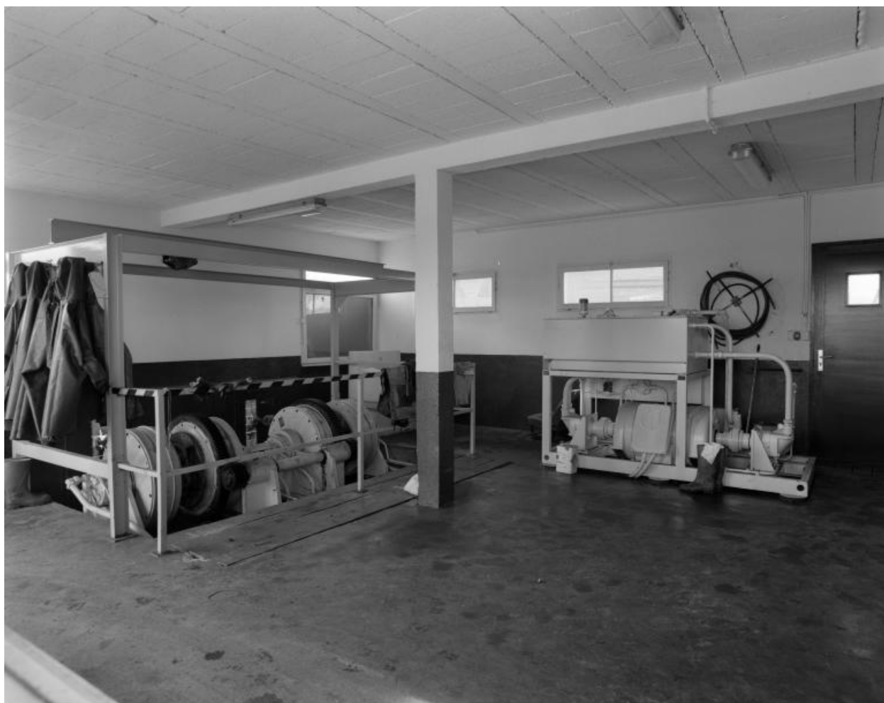
Vue du treuil de hissage de la quatrième ligne de réparation en 2000. Il s'agissait d'un treuil à chaîne à deux tambours
