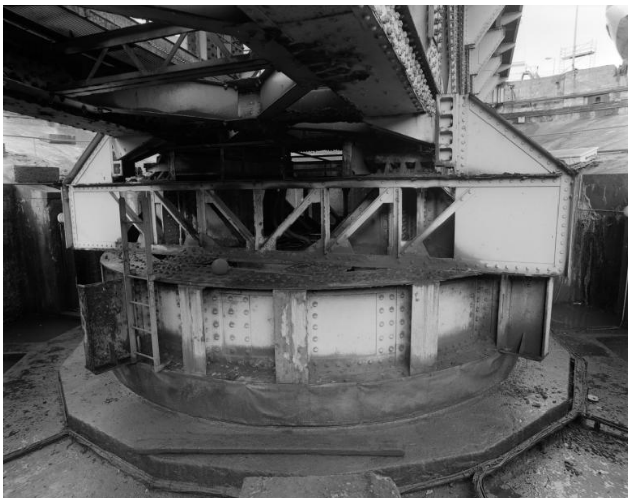
Vue de détail du pont basculant et tournant dans sa fosse bétonnée en 2000 : axe central
