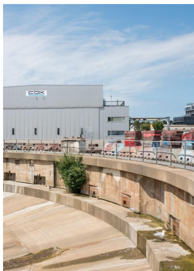
Vue de la fosse du slipway vers le nord Phot. Charlotte Barraud IVR53_20215600576NUCA
