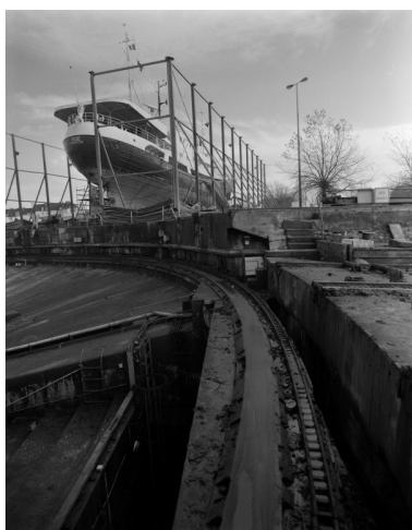
Vue de détail de la fosse bétonnée du pont basculant et tournant en 2000 : chemin de roulement extérieur Phot. Bernard Bègne IVR53_20005600566X
