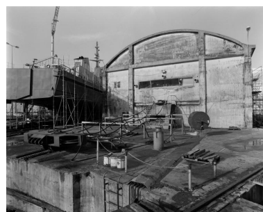
Vue du bâtiment abritant le treuil de hissage principal du slipway en 2000 Phot. Bernard Bègne IVR53_20005600545X
