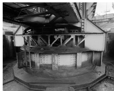
Vue de détail du pont basculant et tournant dans sa fosse bétonnée en 2000 : axe central Phot. Bernard Bègne IVR53_20005600571X
