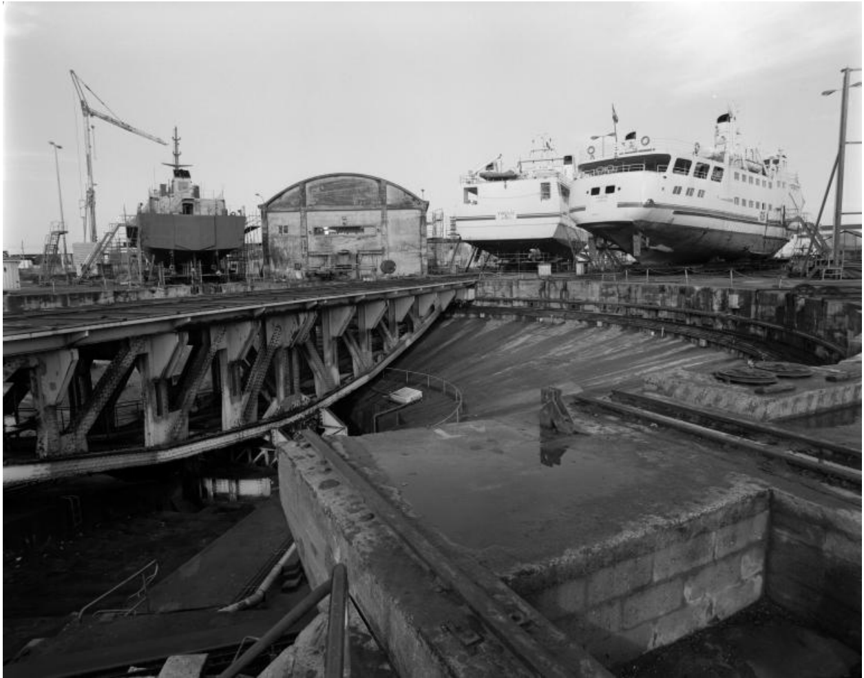
Vue du pont basculant et tournant en 2000. Au centre, le bâtiment abritant le treuil de hissage principal du slipway
