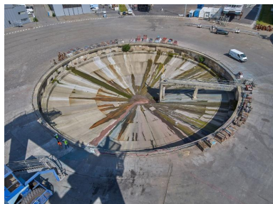
Vue générale de la fosse du slipway depuis le sommet de l'élévateur à bateaux Phot. Bernard Bègne IVR53_20215600457NUCA
