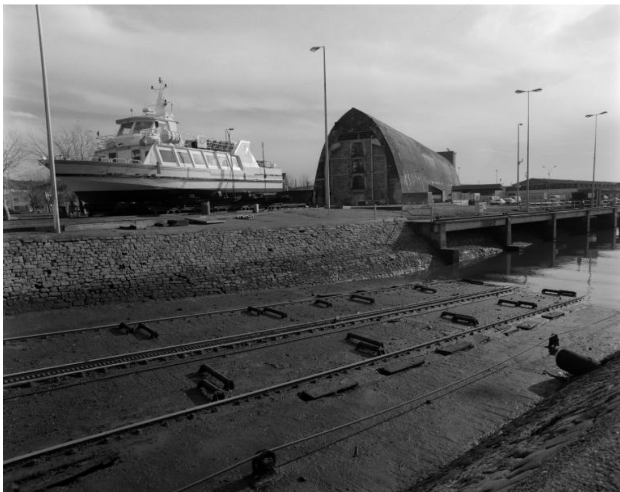
Vue de la rampe inclinée ou cale du slipway en 2000. Au centre, le dom-bunker est dit "T5"
