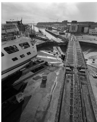
Vue du pont basculant et tournant depuis la quatrième ligne de réparation navale en 2000 (voie située à l'opposé de celle du dom-bunker ouest)
