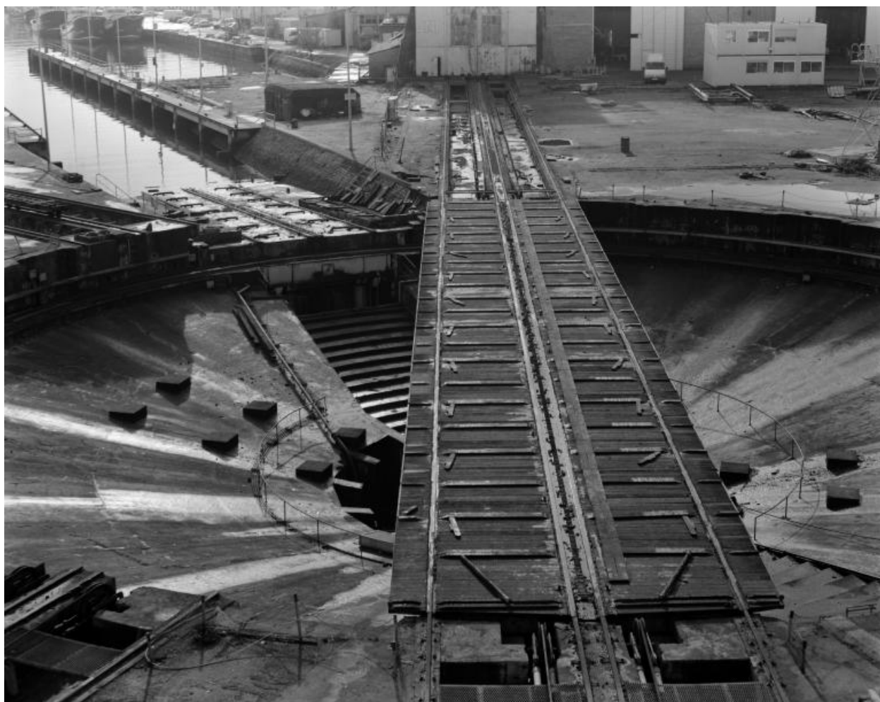
Vue du pont basculant et tournant en 2000. Sa voie ferrée spéciale à quatre rails est placée dans l'axe de la ligne de répartition du dom-bunker ouest. En haut à gauche, on distingue le haut de la rampe inclinée ou cale du slipway
