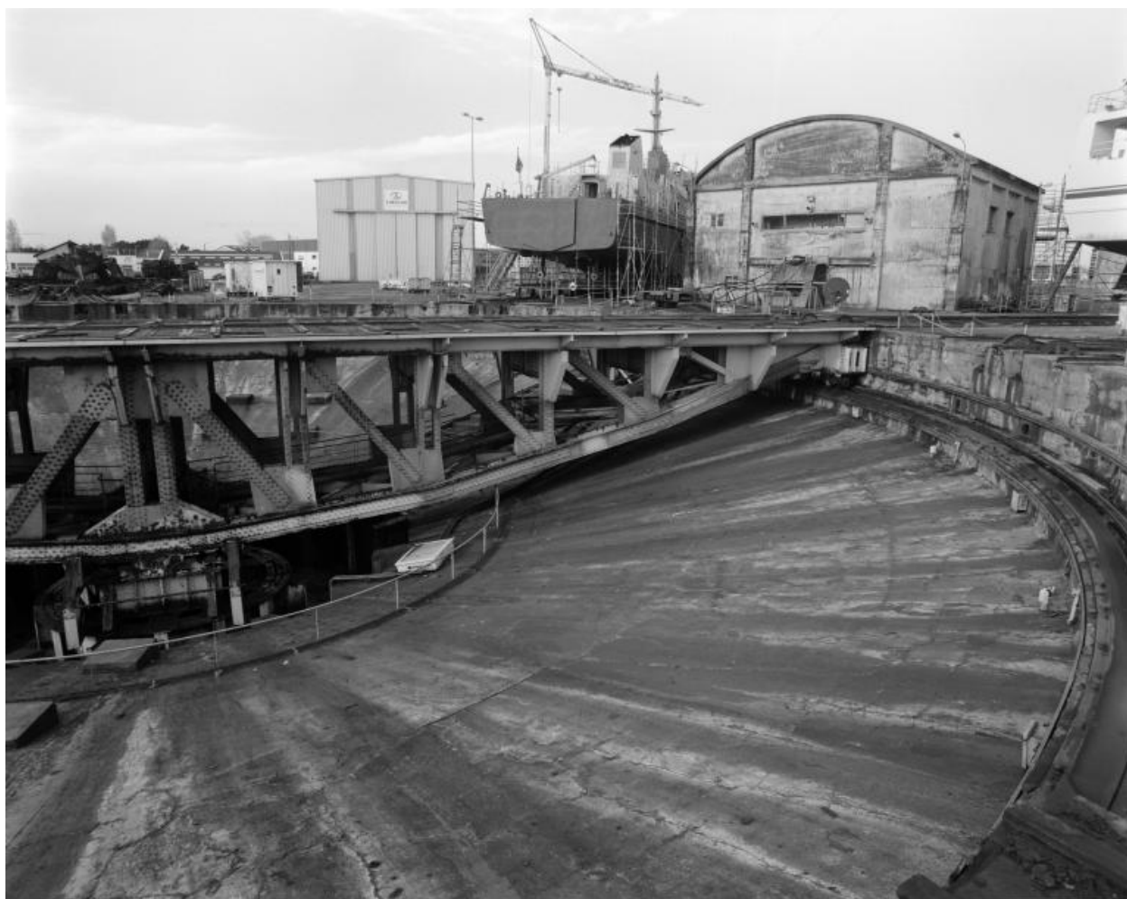
Vue du pont basculant et tournant dans sa fosse bétonnée en 2000. Au droite, le bâtiment abritant le treuil de hissage principal du slipway
