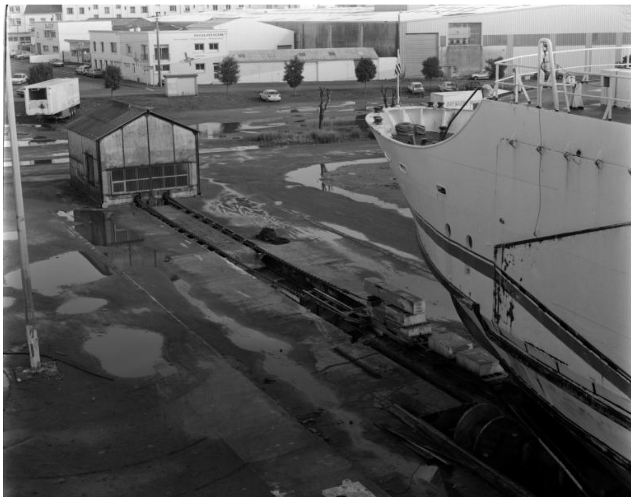
Vue de la troisième ligne de réparation navale en 2000. Dans l'axe de la voie, le bâtiment abritant le treuil de hissage à chaîne
