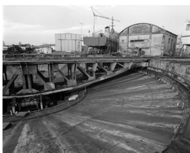
Vue du pont basculant et tournant dans sa fosse bétonnée en 2000. Au droite, le bâtiment abritant le treuil de hissage principal du slipway
