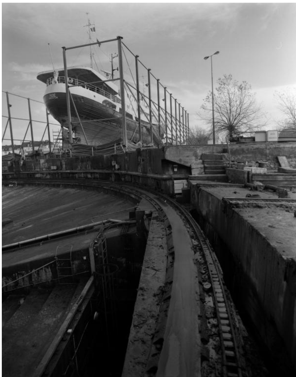
Vue de détail de la fosse bétonnée du pont basculant et tournant en 2000 : chemin de roulement extérieur
