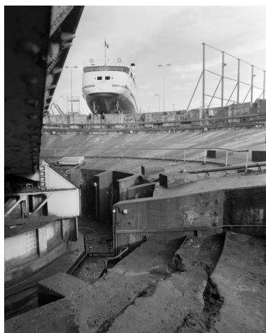
Vue de détail du pont basculant et tournant dans sa fosse bétonnée en 2000 : axe central Phot. Bernard Bègne IVR53_20005600565X
