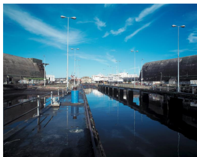
Vue de l'aire de réparation navale en 2000. Au centre, la cale du slipway accessible depuis le bassin long du port de pêche de Keroman.
