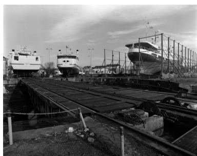
Vue du pont basculant et tournant en 2000. A l'arrière, les lignes de réparation navale n° 2 (Noé de Kingston), n° 3 (Acadie de Nantes) et n° 4 (Vindilis de Vannes)
