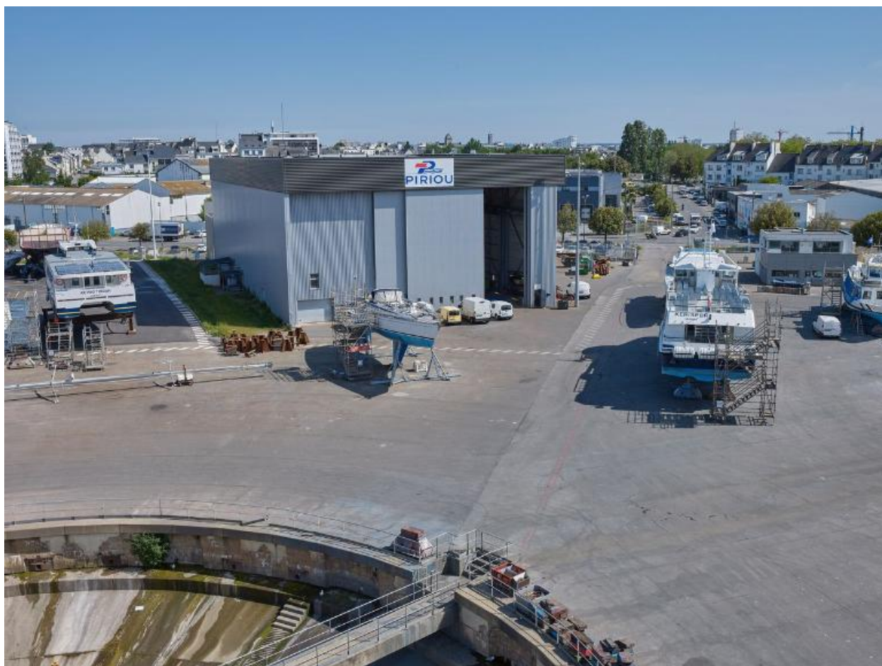
Vue générale vers le nord depuis le sommet de l'élévateur à bateaux. Au premier plan, la fosse du slipway
