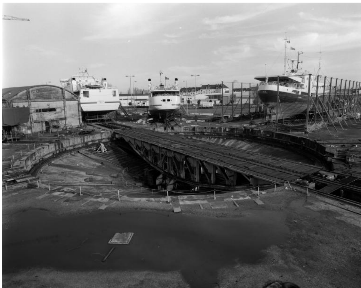
Vue du pont basculant et tournant en 2000. A l'arrière, les lignes de réparation navale n° 2, 3 et 4. A gauche, le bâtiment abritant le treuil principal de hissage
