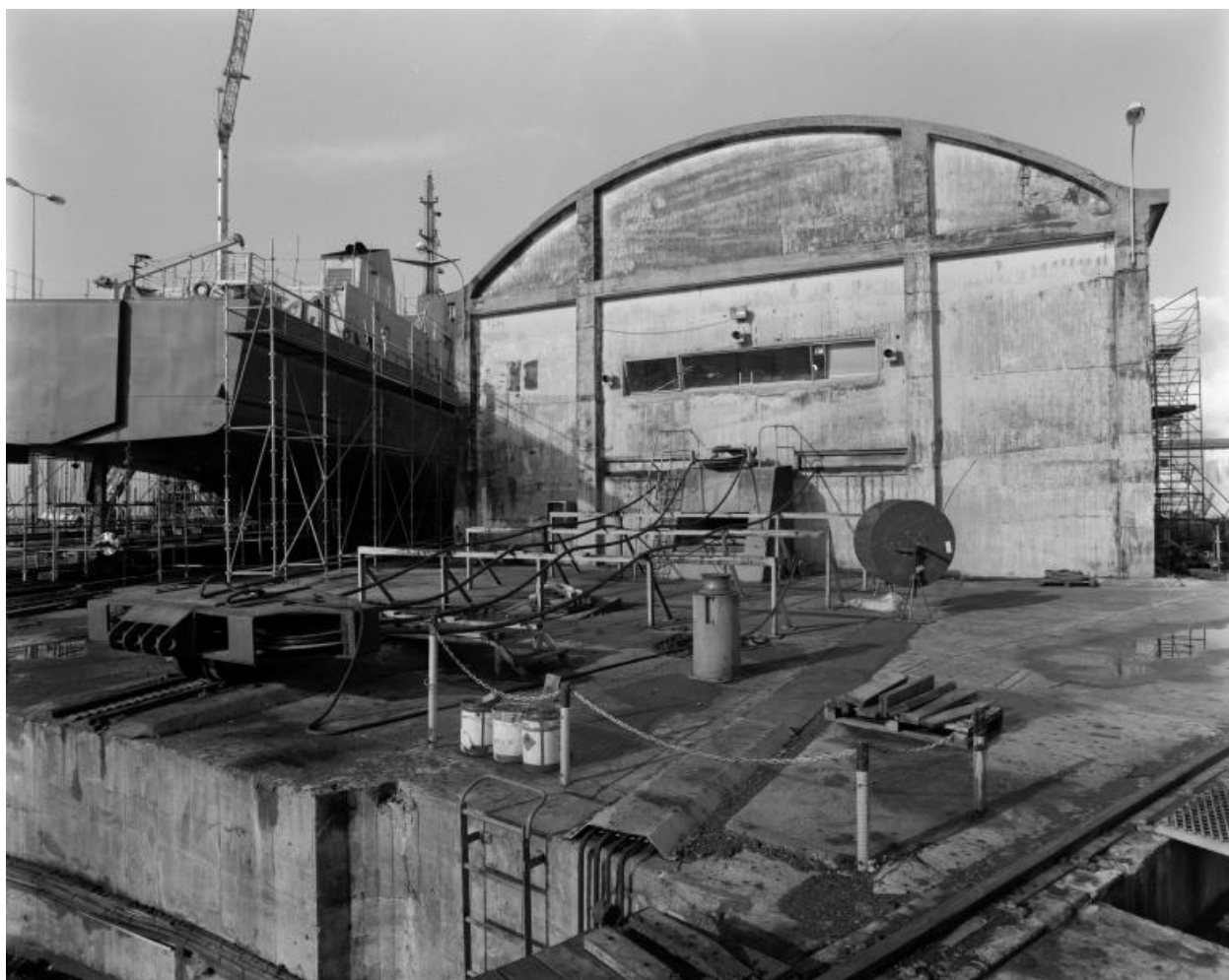
Vue du bâtiment abritant le treuil de hissage principal du slipway en 2000
