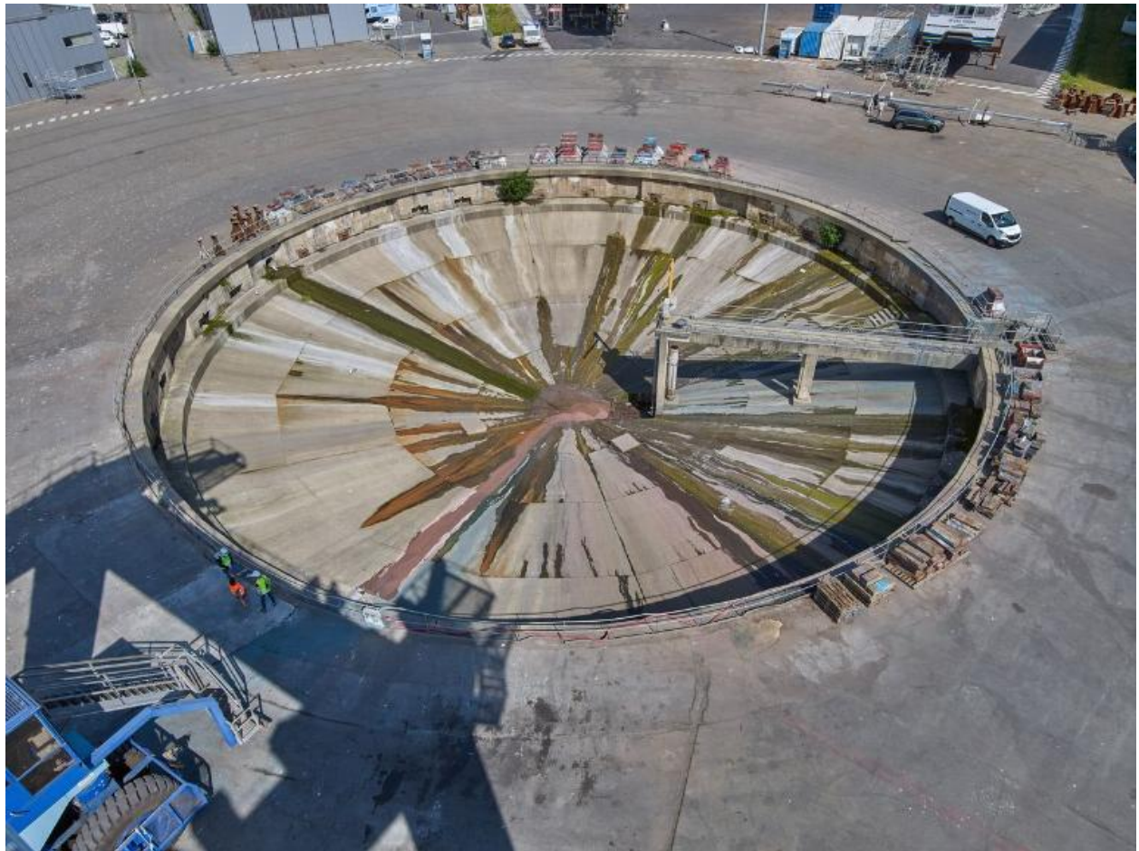
Vue générale de la fosse du slipway depuis le sommet de l'élévateur à bateaux
