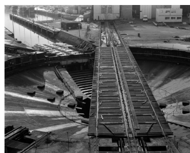
Vue du pont basculant et tournant en 2000. Sa voie ferrée spéciale à quatre rails est placée dans l'axe de la ligne de réparation du dom-bunker ouest. En haut à gauche, on distingue le haut de la rampe inclinée ou cale du slipway Phot. Bernard Bègne IVR53_20005600549X
