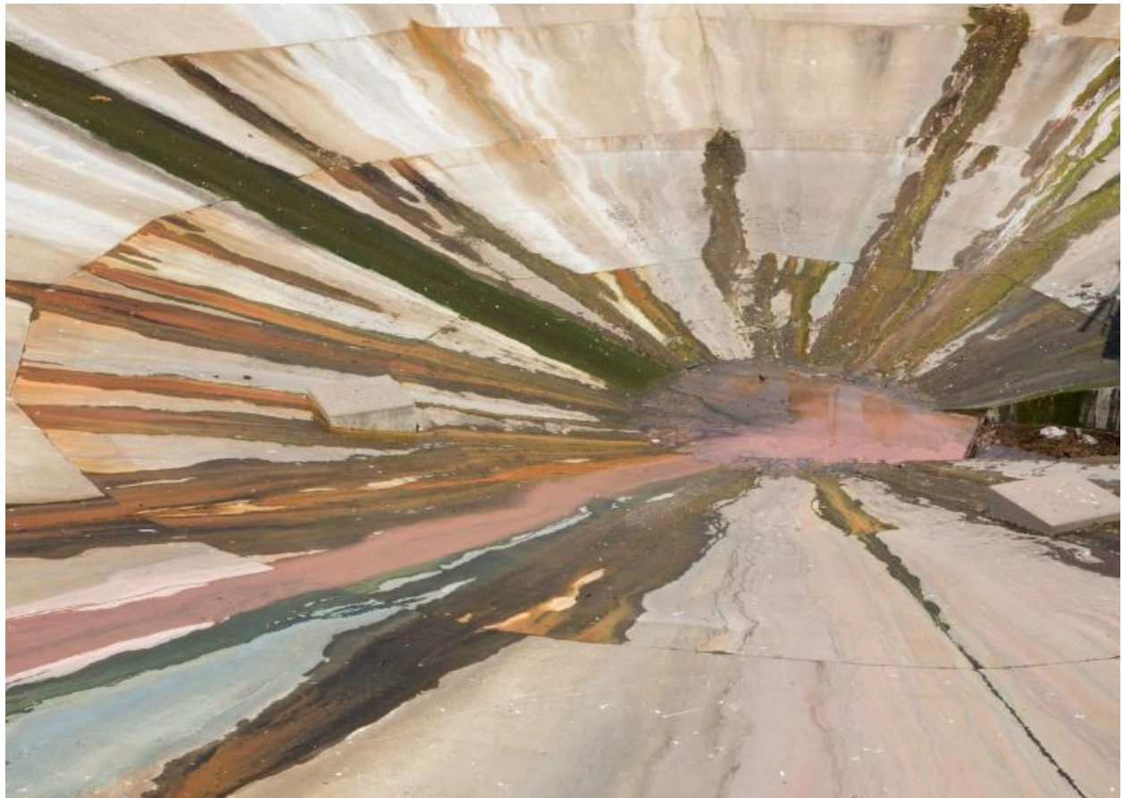
Vue du fond de la fosse du slipway
