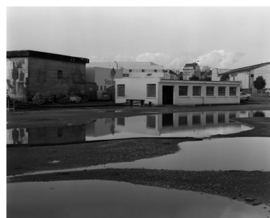
Vue de deux bâtiments situés au nord de l'aire de réparation navale en 2000. Le bâtiment de droite (peint en blanc) abritait le treuil de hissage de la quatrième ligne de réparation. Le bâtiment de gauche abritait vraisemblablement un groupe électrogène Phot. Bernard Bègne IVR53_20005600546X
