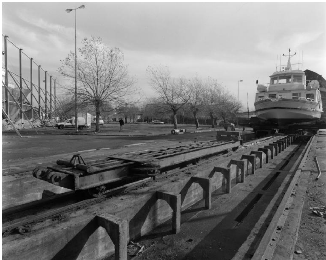
Vue de la ligne de réparation navale n° 1 (dans l'axe du dom-bunker est). La voie ferrée spéciale à quatre rails repose sur des fondations en béton armé
