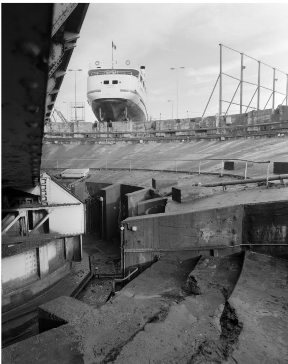
Vue de détail du pont basculant et tournant dans sa fosse bétonnée en 2000 : axe central
