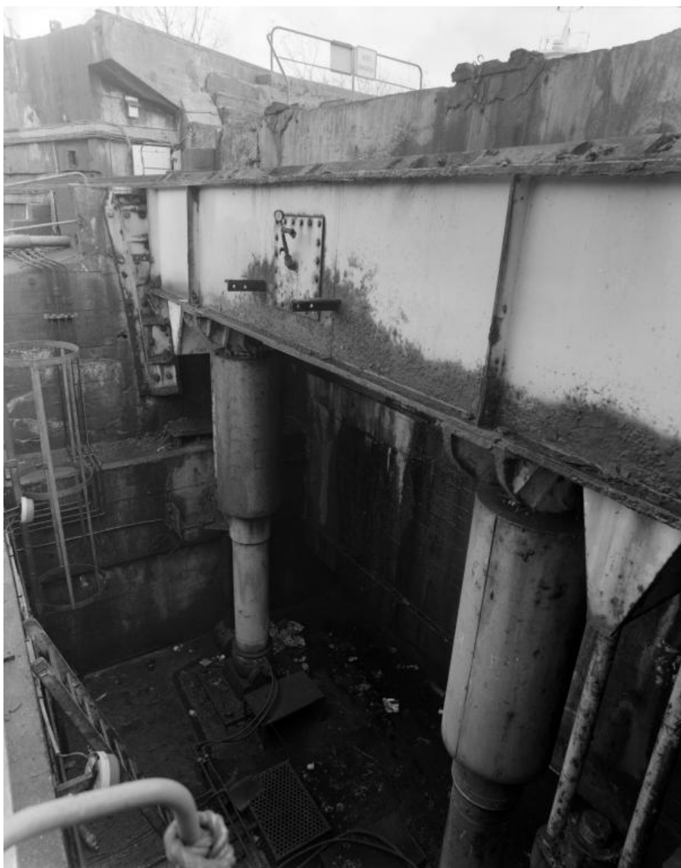
Vue de détail du pont basculant et tournant dans sa fosse bétonnée en 2000 : vérins, levage sud
