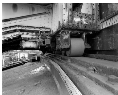
Vue de détail de la fosse bétonnée du pont basculant et tournant en 2000 : chemin de roulement Phot. Bernard Bègne IVR53_20005600573X
