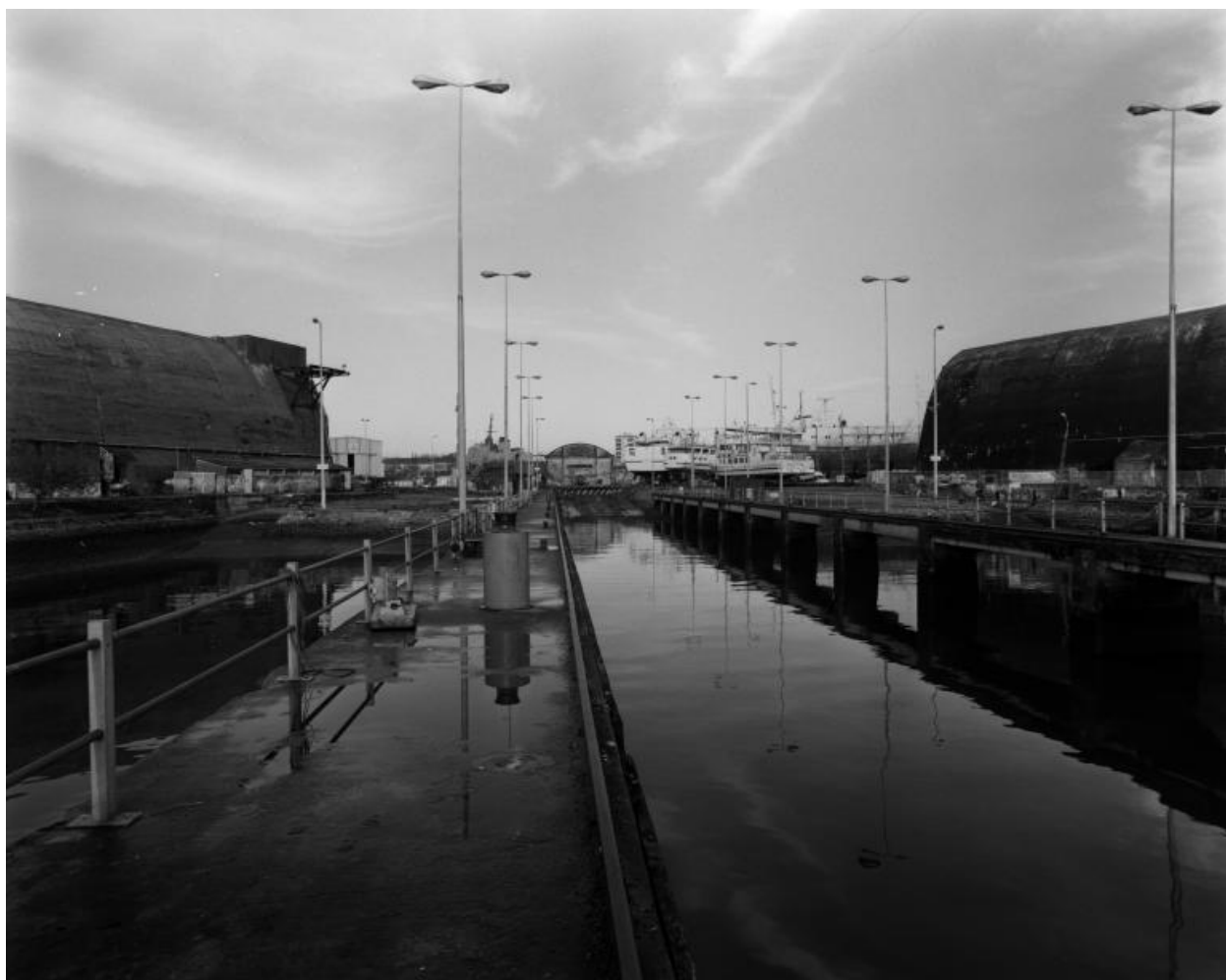
Vue de l'aire de réparation navale en 2000. Au centre, la cale du slipway accessible depuis le bassin long du port de pêche de Keroman. De part et d'autre de la cale, les deux dom-bunkers
