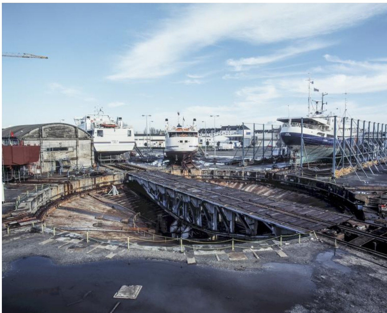
Vue générale du slipway en 2000. Entre 1932 et 2001, un pont tournant et basculant permettait de répartir les navires en construction ou en réparation sur sept voies
