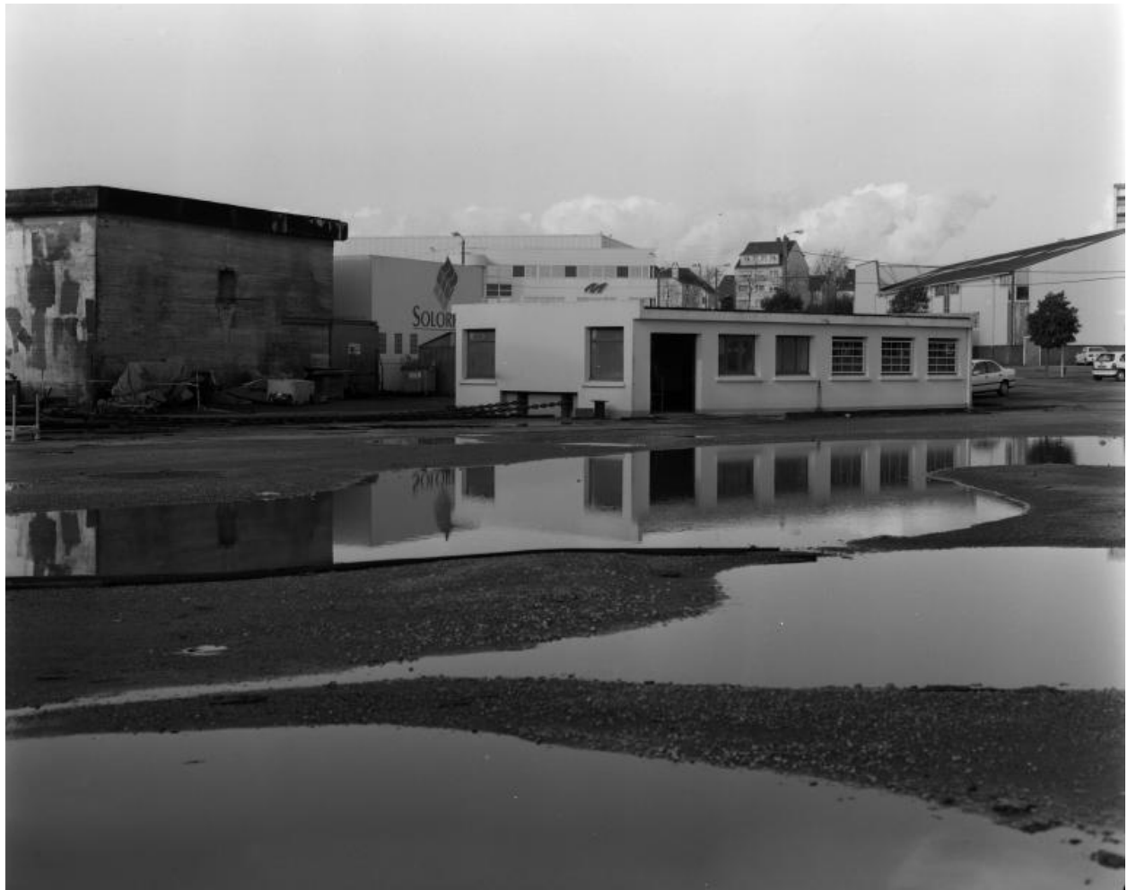
Vue de deux bâtiments situés au nord de l'aire de réparation navale en 2000. Le bâtiment de droite (peint en blanc) abritait le treuil de hissage de la quatrième ligne de réparation. Le bâtiment de gauche abritait vraisemblablement un groupe électrogène
