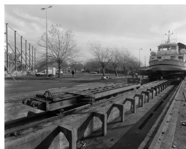
Vue de la ligne de réparation navale n° 1 (dans l'axe du dom-bunker est). La voie ferrée spéciale à quatre rails repose sur des fondations en béton armé
