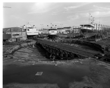
Vue du pont basculant et tournant en 2000. A l'arrière, les lignes de réparation navale n° 2, 3 et 4. A gauche, le bâtiment abritant le treuil principal de hissage
